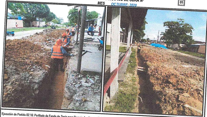
Ejecución de Partida 02.16: Perfilado de Fondo de Zanja para Drenaje Auxiliar con Tub 6"
