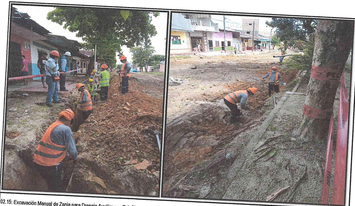
02.15: Excavación Manual de Zanja para Drenaje Auxiliar con Tub 6"
