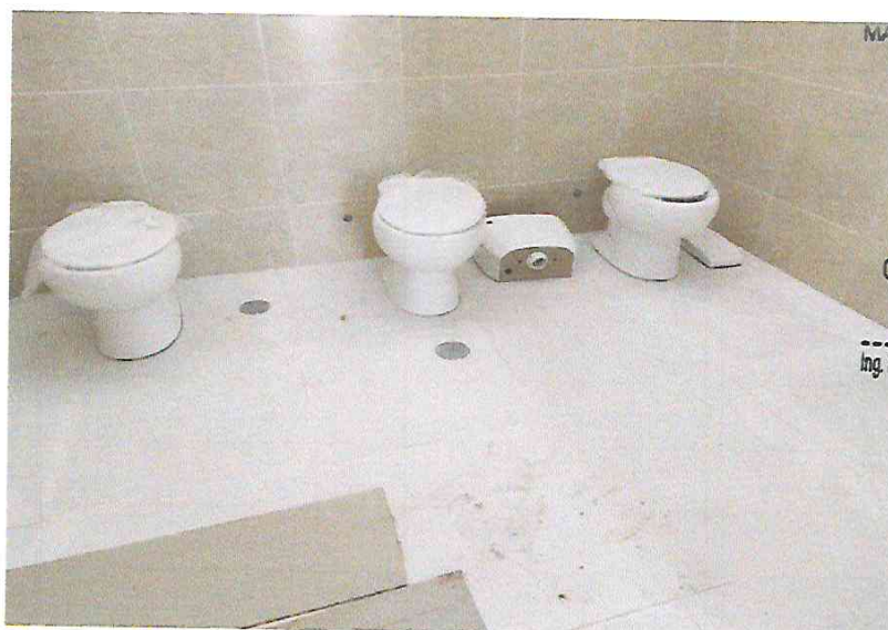
FOTO N°04: Vista de aparatos sanitarios para SS. HH en la obra "Mejoramiento y Equipamiento del servicio Educativo N° 62200 Barrio Carabanchel - San Lorenzo, Distrito Barranca, Provincia Datem Del Marañón - Loreto"
