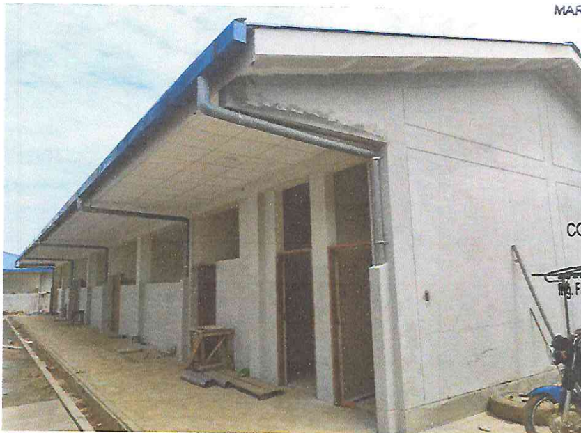
FOTO N°06: Vista del montaje canaletas y tuberías pluviales en la obra "Mejoramiento y Equipamiento del servicio Educativo N° 62200 Barrio Carabanchel - San Lorenzo, Distrito Barranca, Provincia Datem Del Marañón - Loreto".
