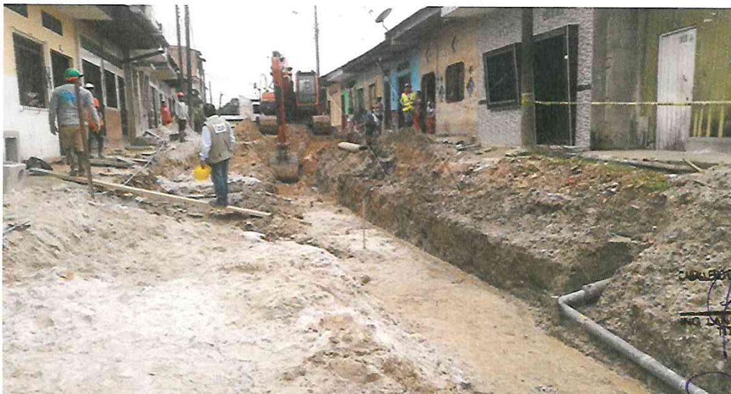
FOTOGRAFÍA 02: EXCAVACIÓN A NIVEL DE CANAL EN LA CA. BELAUDE TERRY
