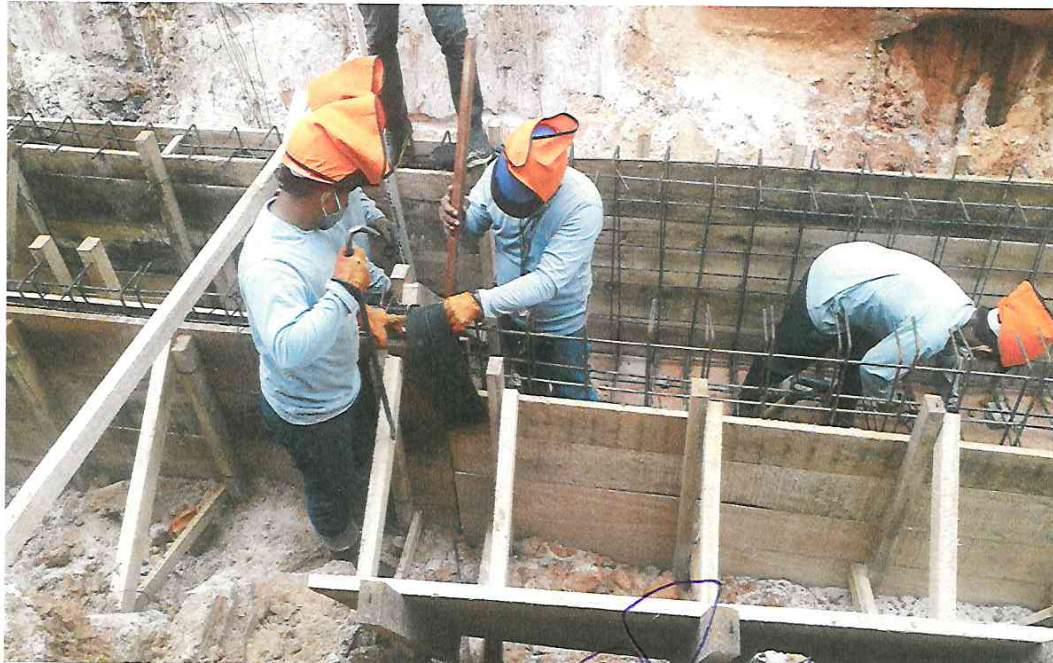
FOTOGRAFÍA 07: COLOCACIÓN DE JUNTA DE DILATACION CON WATER STOP 6" EN LA CA. BELAUDE TERRY
