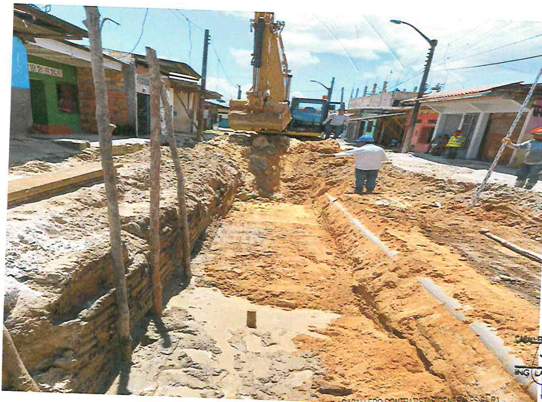
FOTOGRAFÍA 10: INICIO DE EXCAVACION A NIVEL DE CANAL Y SOBRE EXCAVACION - EN LA CA.PAMPACHICA
