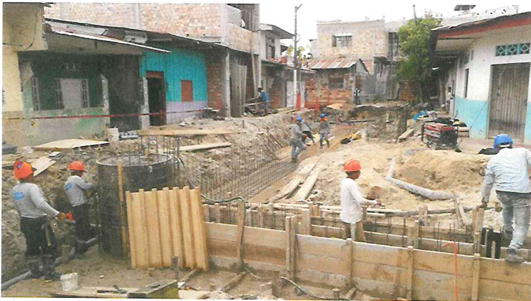
FOTOGRAFÍA 05: COLOCACIÓN DE ESTRUCTURA DE ACERO CORRUGADO DE Ø3/8" EN LA CA. BELAUDE TERRY
