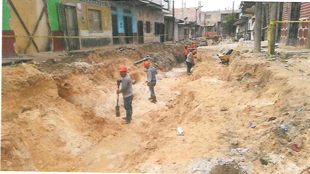
FOTOGRAFÍA 03: PERFILADO DE EXCAVACIÓN EN LA CA. BELAUDE TERRY
