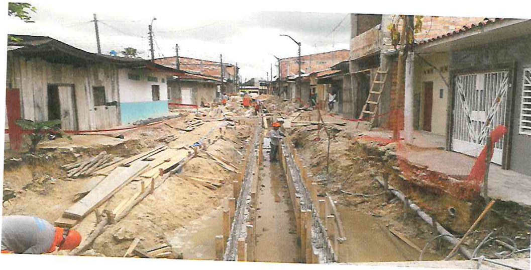
FOTOGRAFÍA 10: INICIO DE EXCAVACION A NIVEL DE CANAL Y SOBRE EXCAVACION - EN LA CA.PAMPACHICA
