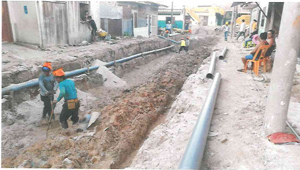
FOTOGRAFÍA 11: PERFILADO Y NIVELACION DE FONDO DE CANAL DE ALCANTARILLA EN LA CA. PAMPACHICA
