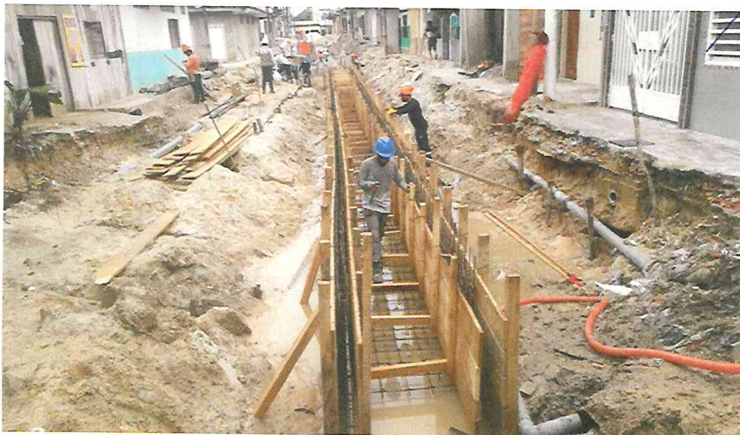
FOTOGRAFÍA 06: ENCOFRADO DE ALCANTARILLA EN LA CA. BELAUDE TERRY
