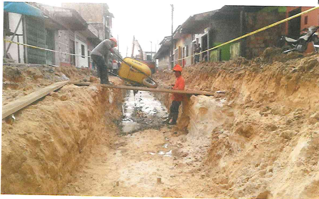
FOTOGRAFÍA 04: VACEO DE SOLADO EN LA CA. BELAUDE TERRY
