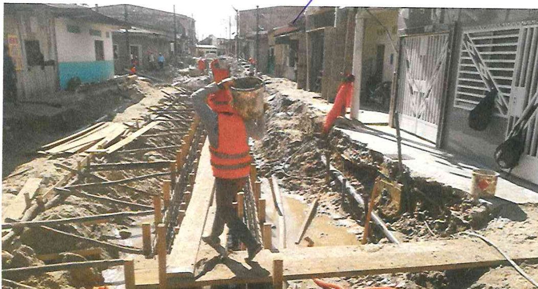
FOTOGRAFÍA 08: VACEO DE PRIMER TRAMO DE ALCANTARILLA EN LA CA. BELAUDE TERRY
