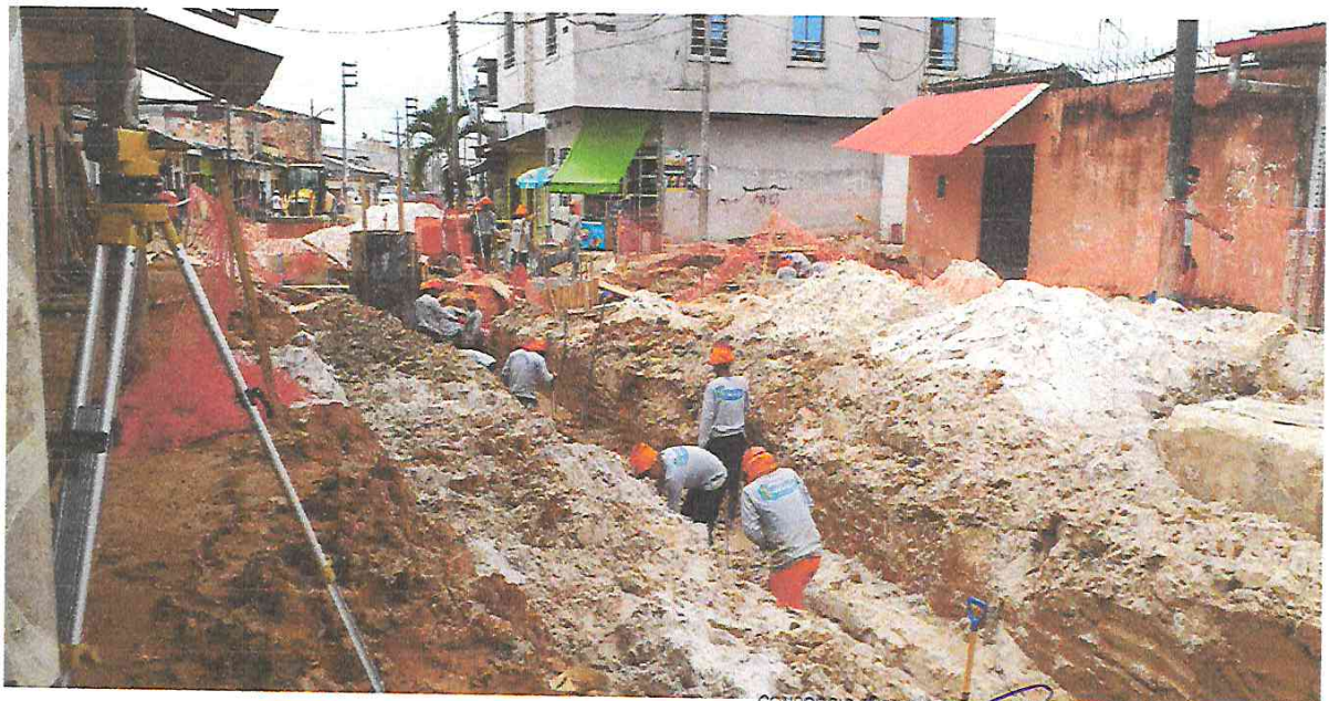
Foto N° 14: Excavación de Zanja con maquinaria hasta cota de fondo de alcantarilla, Ca. Garcilazo de la vega tramo 8.
