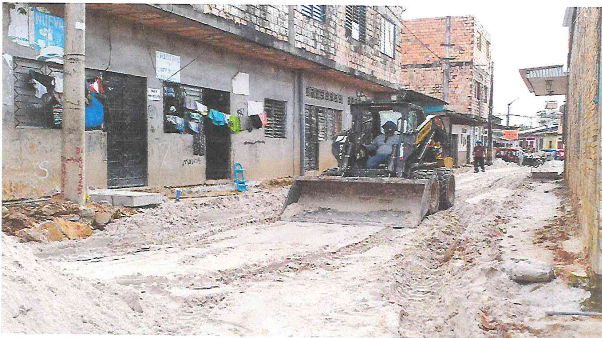
Foto N° 10: Relleno de sobre excavación Arena en el Psj. Inca Roca tramo 5.
