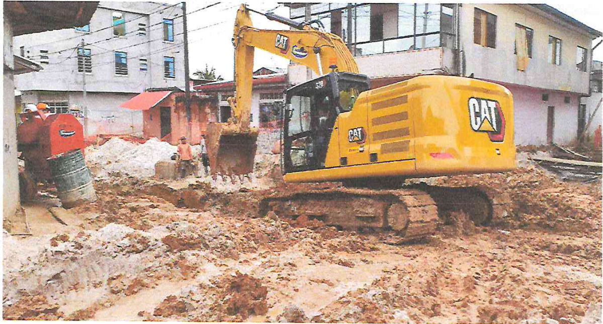
Foto N° 06: Corte de terreno a nivel de subrasante con maquinaria.
