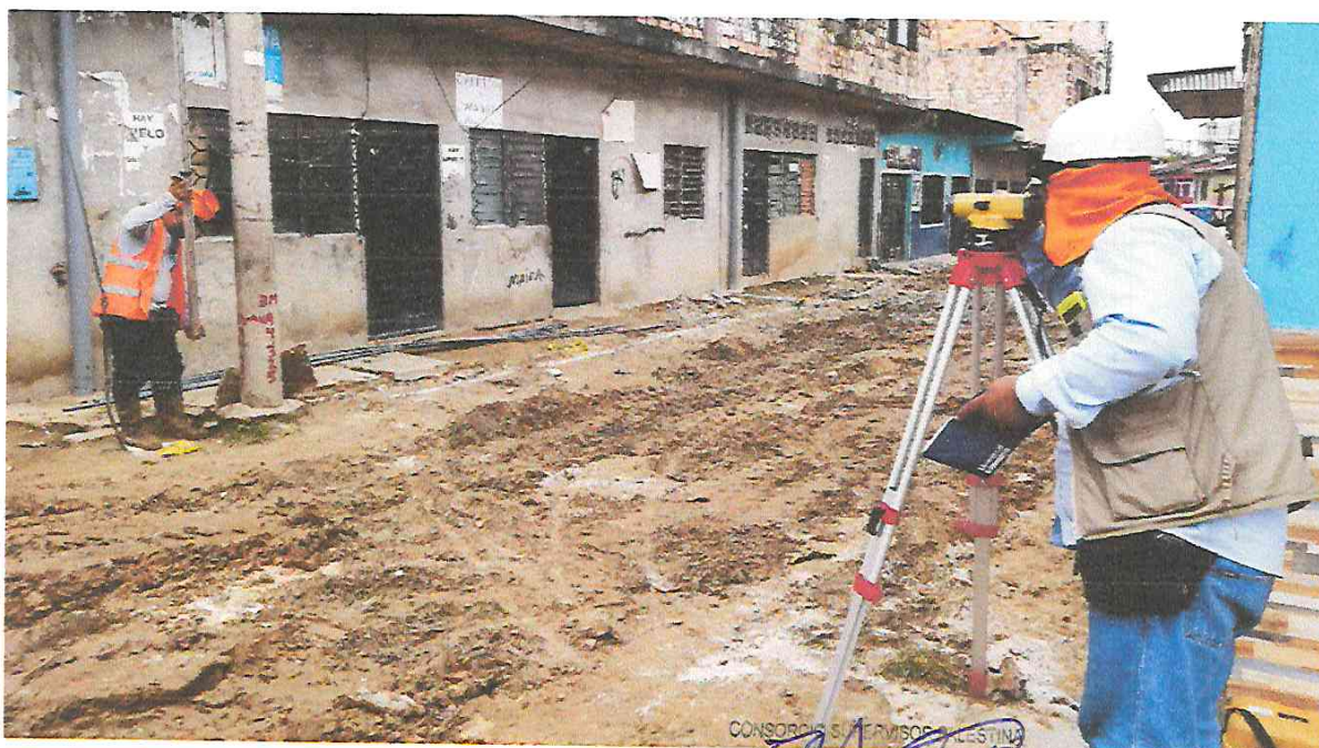
Foto N° 12: Trazo nivel y replanteo.
