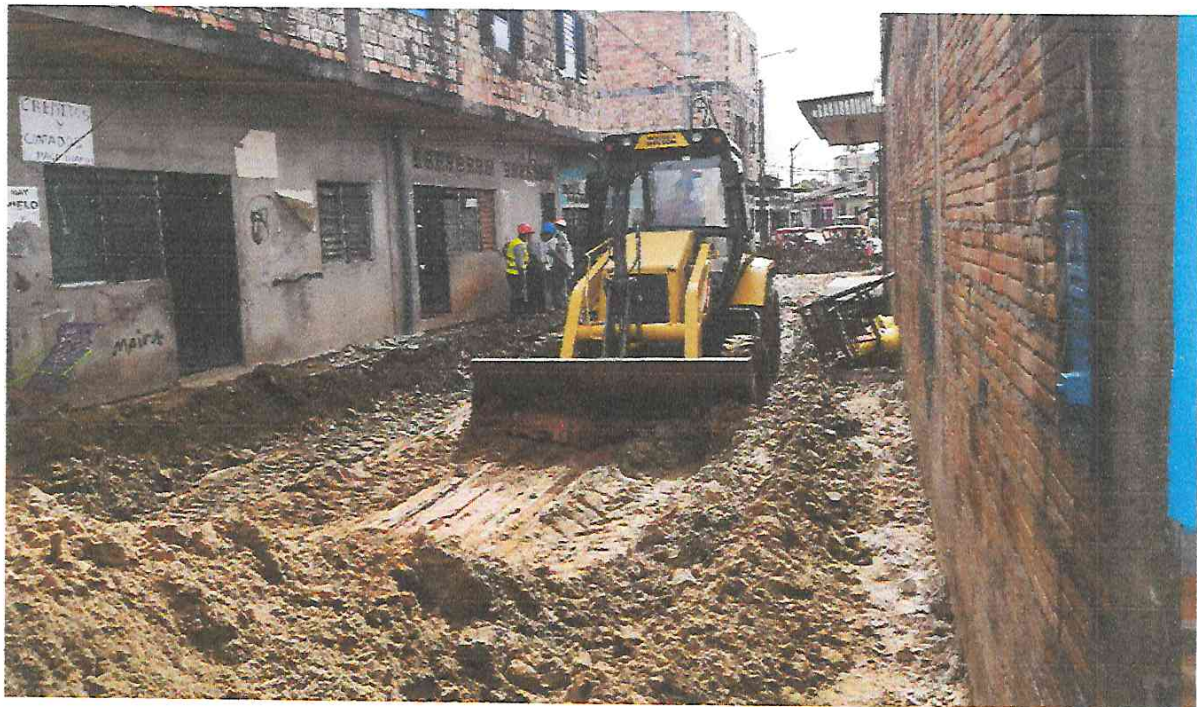
Foto N° 06: Corte de terreno a nivel de subrasante con maquinaria.
