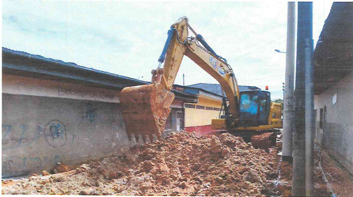
Foto N° 08: Corte de terreno a nivel de subrasante con maquinaria.
