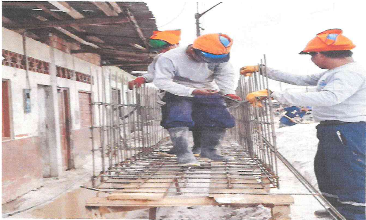
Foto N° 18: Acero de Refuerzo \varnothing 1/2" ; F_y = 4,200 \text{ Kg/Cm}^2 para alcantarilla de sección variable.
