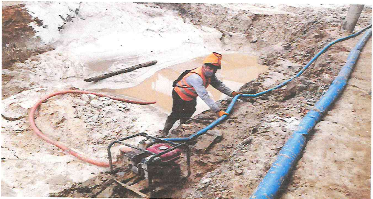
Foto N° 04: Bombeo para eliminación de aguas filtrantes y pluviales.
