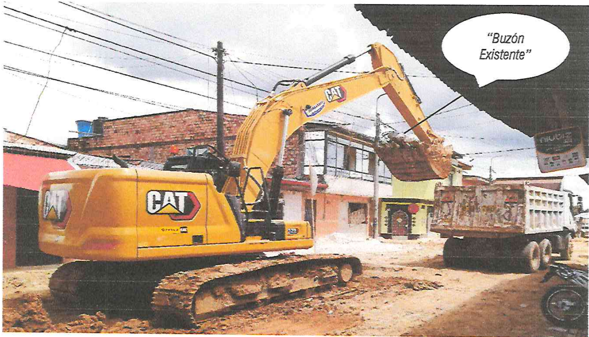
Foto N° 14: Excavación de Zanja con maquinaria hasta cota de fondo de alcantarilla, Ca. Garcilazo de la vega tramo 8.
