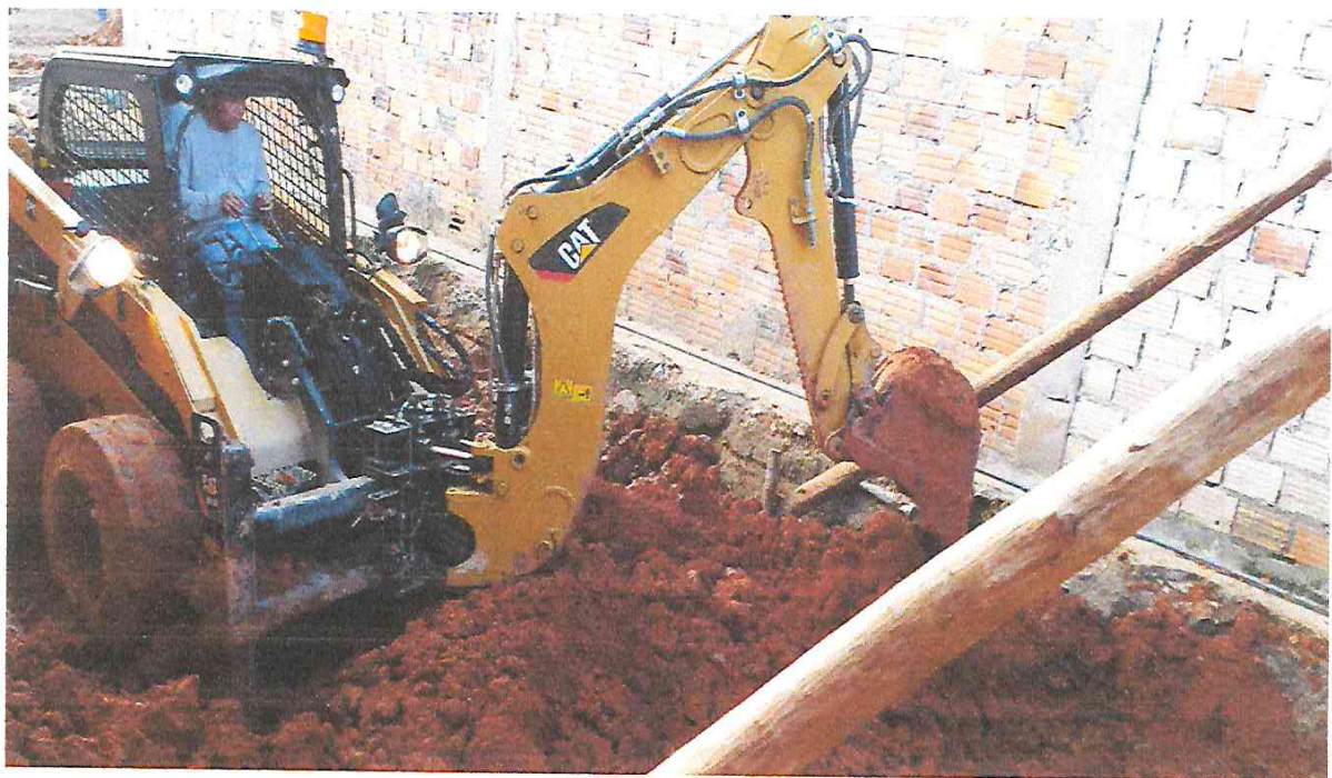
Foto N° 08: Corte de terreno a nivel de subrasante con maquinaria.
