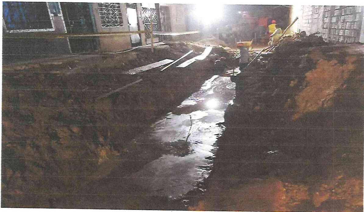
Foto N° 16: Solado para canal rectangular, mezcla c:a 1:10, e=4”.
