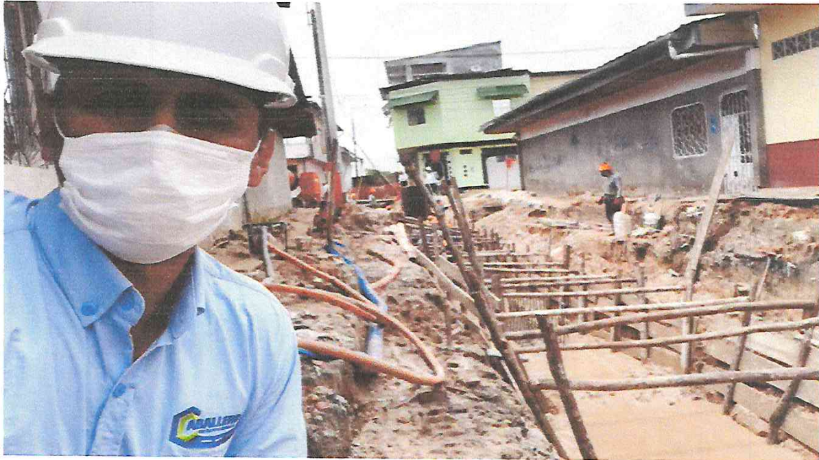
Foto N° 10: Relleno de sobre excavación Arena en el Psj. Inca Roca tramo 5.
