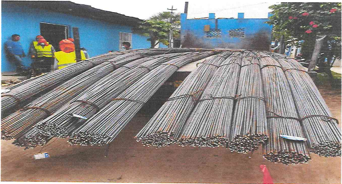
Foto N° 03: Transporte de materiales a obra.
