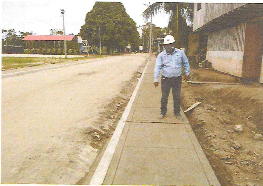
- VERIFICACION DE LA JUNTA DE DILATACION EN VEREDA CON MEZCLA DE ASFALTO Y ARENA CADA 3 M ASI COMO TAMBIEN LAS BRUÑAS DE CANTO Y TRANSVERSAL EN VEREDAS.
