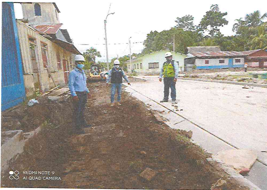
- LIMPIEZA, CONFORMACION, NIVELACION Y COMPACTACION PARA LOS TRABAJOS DE VEREDAS.
