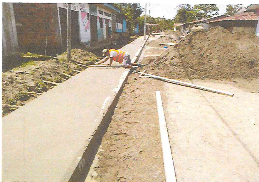
- ACABADO CON BRUÑA DE CANTO Y TRANSVERSAL EN VEREDAS.
