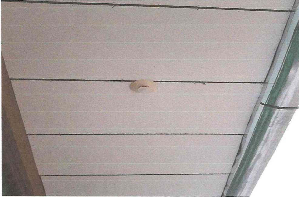
FOTO N°11: Se presenta los trabajos de colocación de punto de luz exterior.
