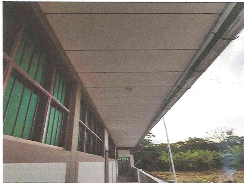
FOTO N°06: EN LA FOTO, se muestra el cielorraso exterior y canaleta pluvial. DIRECCION: ATLANTIDA N° 314
