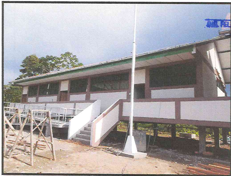
FOTO N°19: SE MUESTRA TRABAJOS DE PINTURA EN MUROS EXTERIORES E INTERIORES CULMINADOS EN SU TOTALIDAD.
