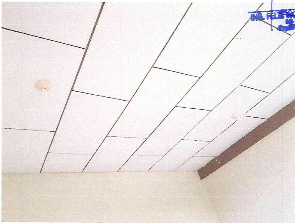
FOTO N°08: Se muestra el cielorraso interior de la I.E DIRECCION: ATLANTIDA N° 314
