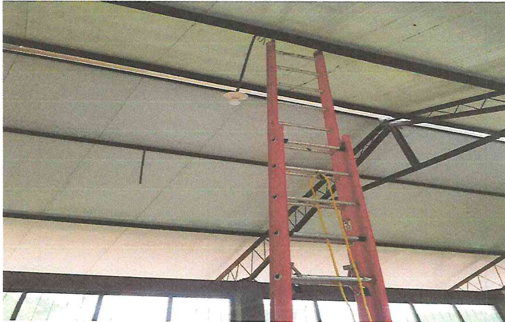
FOTO N°09: Se muestra los trabajos de instalación del alumbrado de las aulas.
