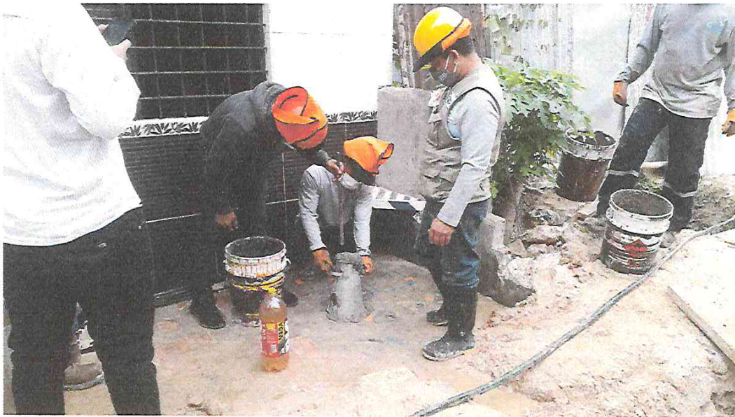
FOTOGRAFÍA 11: EJECUCION DE ENSAYO SLUMP DE ACUERDO AL DISEÑO DE MEZCLA ANTES DEL INICIO DE VACEO DEL MORTERO
