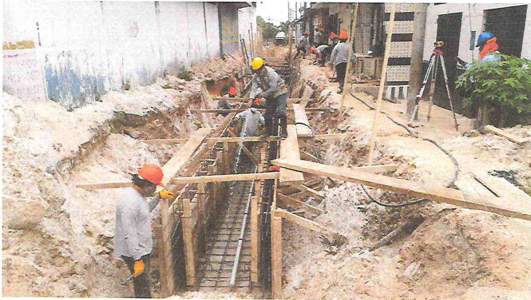
FOTOGRAFÍA 07: ENCOFRADO DE ALCANTARILLA EN PASAJE FORTES
