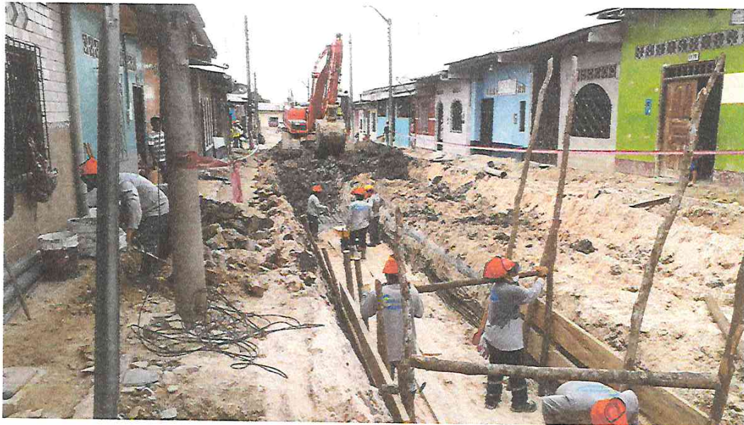
FOTOGRAFÍA 17: SE CONTINUA CON LOS TRABAJOS DE ENTIBADO Y CAMA DE ARENA EN LA CALLE PAMPACHICA
