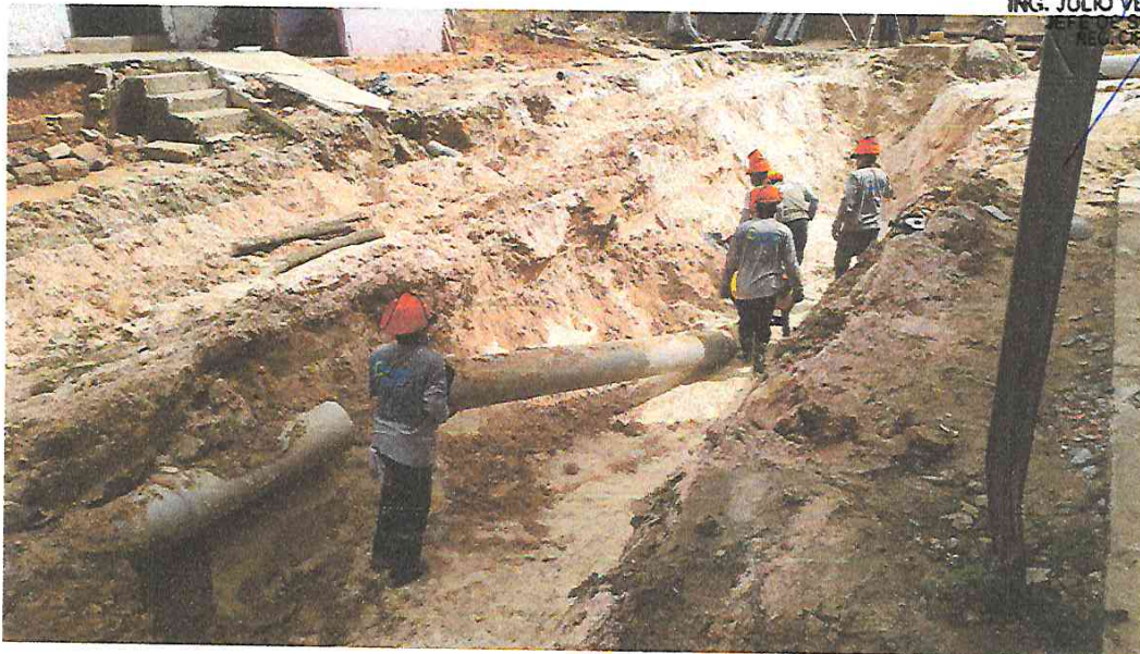
FOTOGRAFÍA 16: RETIRO DE TUBERIA EXISTENTE EN CALLE PAMPACHICA
