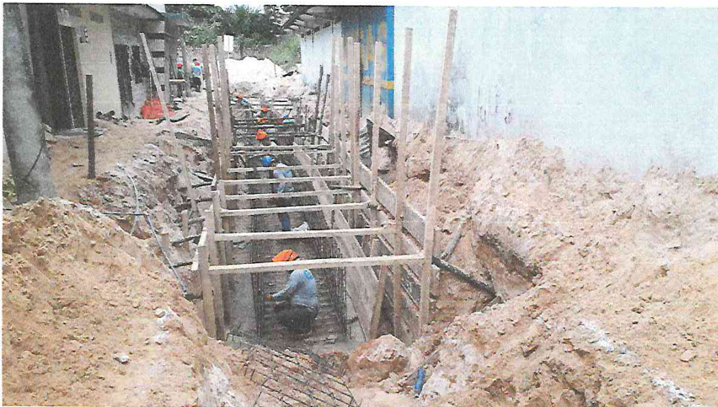
FOTOGRAFÍA 06: COLOCACION DE ESTRUCTURA DE ACERO CORRUGADO DE Ø3/8" Y ENTIBADO DE CANAL – PASAJE ARMANDO FORTES
