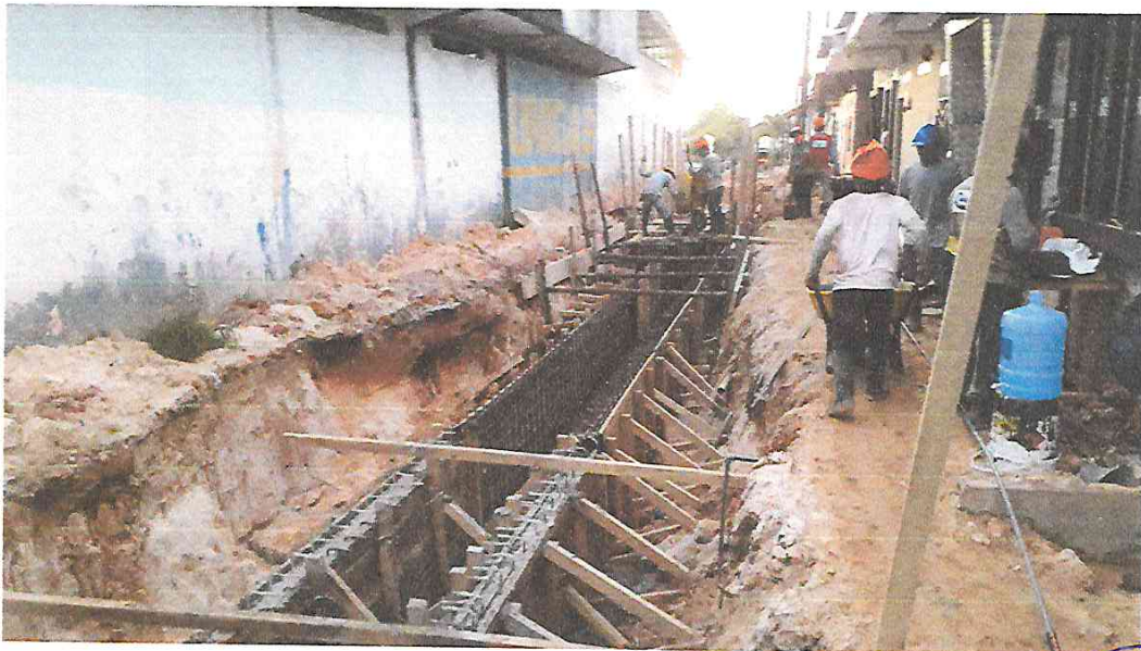
FOTOGRAFÍA 19: VACEO EN CANAL DE ALCANTARILLA EN EL PASAJE ARMANDO FORTES
