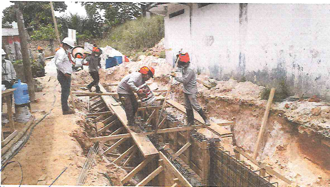
FOTOGRAFÍA 10: VACEO DE PRIMER TRAMO DE ALCANTARILLA EN PASAJE FORTES
