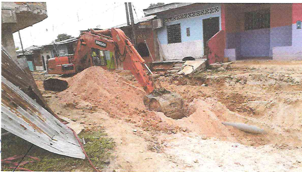
FOTOGRAFÍA 12: INICIO DE EXCAVACION A NIVEL DE CANAL Y SOBRE EXCAVACION EN LA CALLE PAMPACHICA
