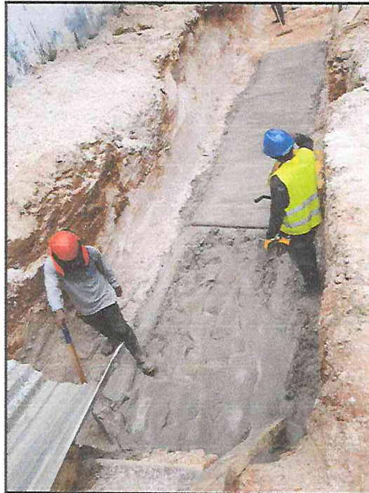
FOTOGRAFÍA 06: COLOCACION DE ESTRUCTURA DE ACERO CORRUGADO DE Ø3/8" Y ENTIBADO DE CANAL – PASAJE ARMANDO FORTES
