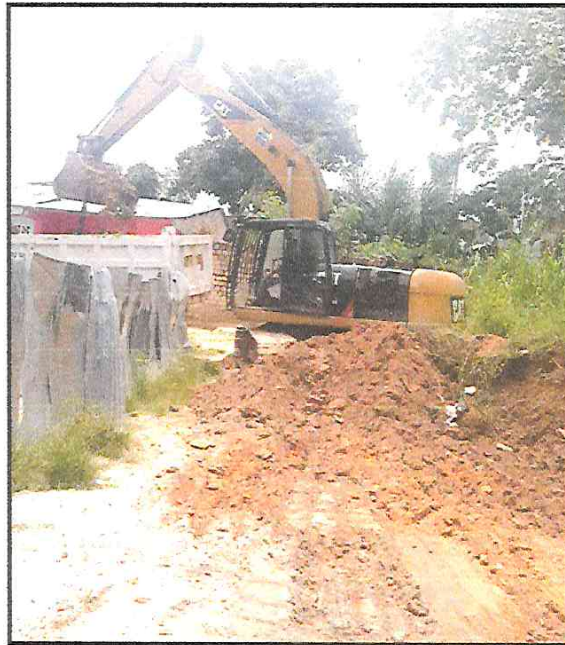
FOTOGRAFÍA 02: EXCAVACION A NIVEL DE CANAL EN EL PASAJE A. FORTES
