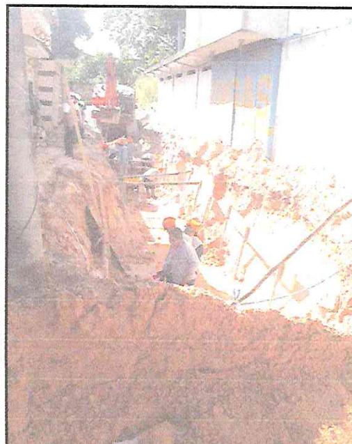
FOTOGRAFÍA 04: PERFILADO DE EXCAVACION DE CANAL EN PSJ. FORTES
