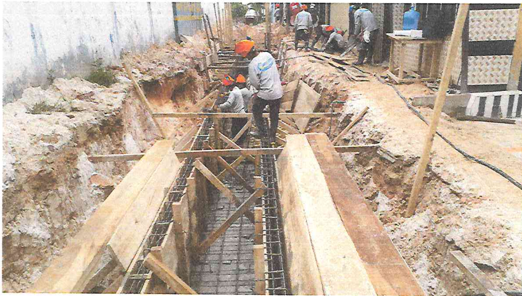
FOTOGRAFÍA 09: INICIO DE VACEO DE PRIMER TRAMO DE ALCANTARILLA EN PASAJE FORTES
