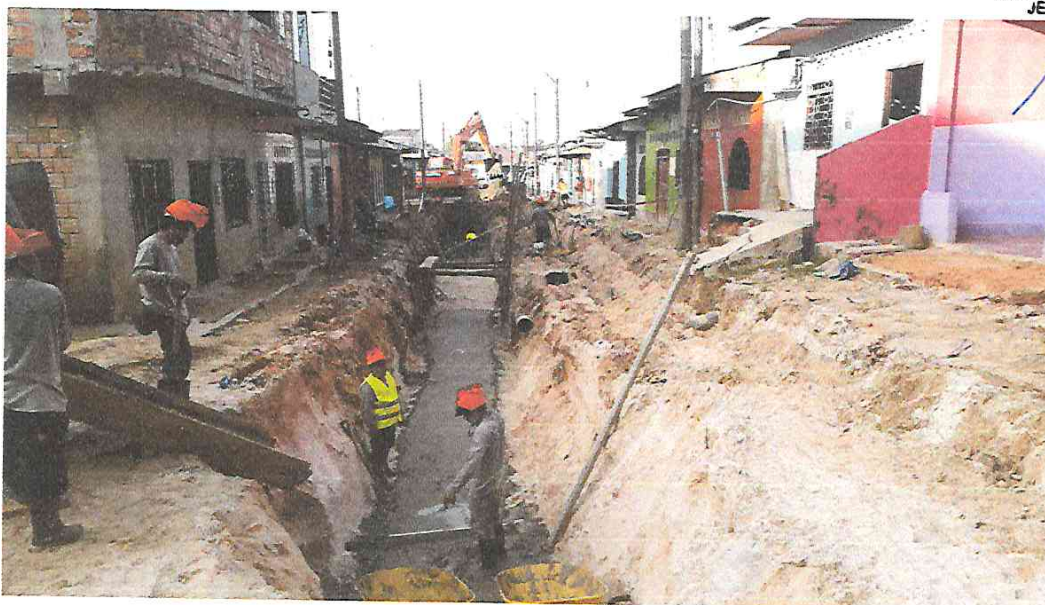
FOTOGRAFÍA 18: VACEO DE SOLADO EN INICIO DE ALCANTARILLA EN LA CALLE PAMPACHICA
