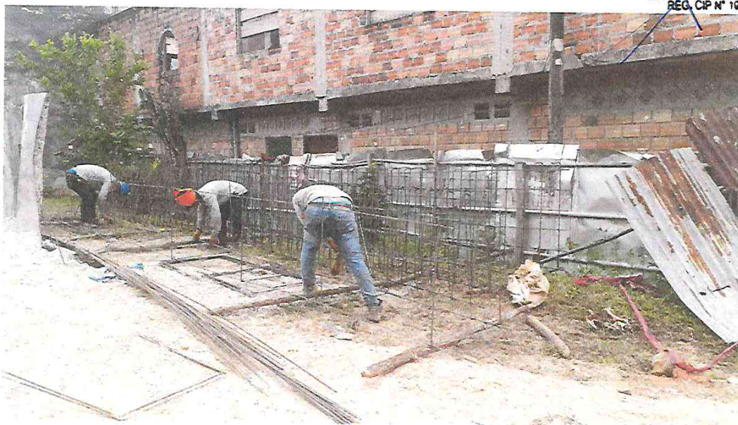
FOTOGRAFÍA 14: HABILITACION DE ESTRUCTURA DE ALCANTARILLA
