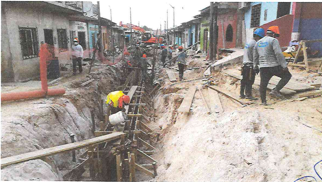
FOTOGRAFÍA 21: SE CONTINUA CON EL INICIO DE VACEO DEL PRIMER TRAMO DE ALCANTARILLA EN LA CALLE PAMPACHICA
