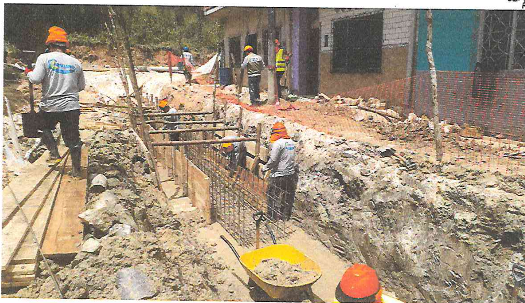
FOTOGRAFÍA 20: COLOCACION DE ESTRUCTURA Y ENCOFRADO DE ALCANTARILLA EN LA CALLE PAMPACHICA
