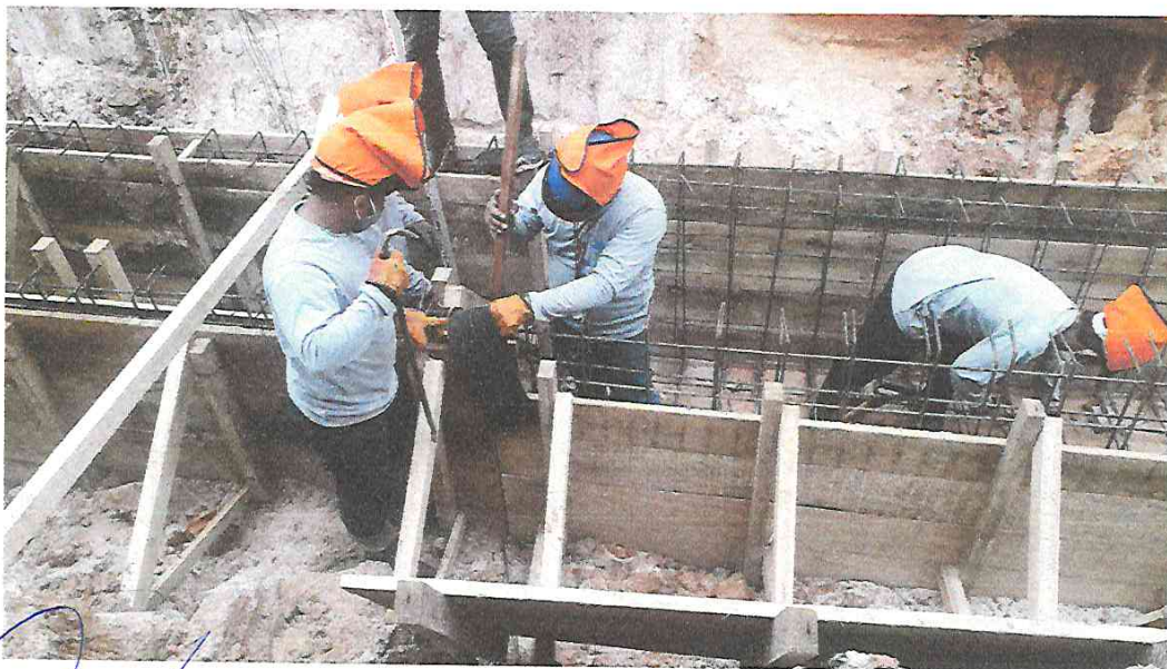
FOTOGRAFÍA 08: COLOCACION DE JUNTA DE DILATACION CON WATER STOP 6"
