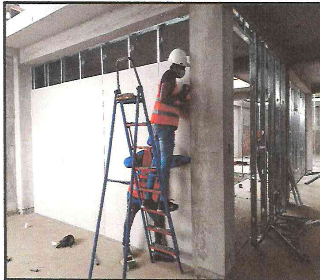
INSTALACIÓN DE TABIQUERIA CON DRYWALL.
