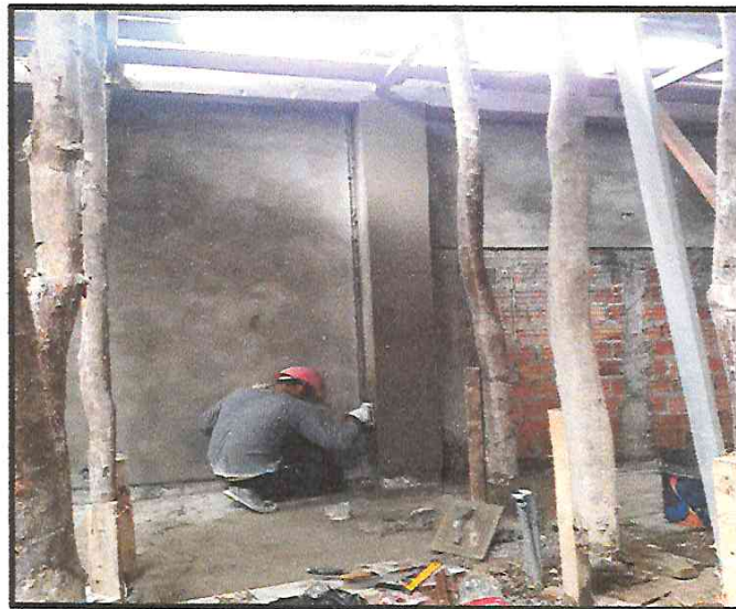
TARRAJEO EN MUROS INTERIORES.
