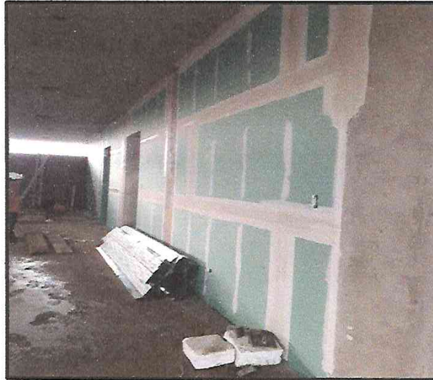
INSTALACIÓN DE TABIQUERIA CON DRYWALL.
