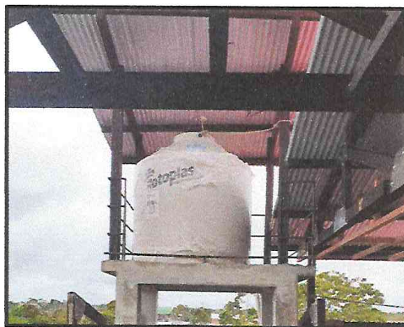
SUMINISTRO E INSTALACIÓN DE TANQUE ELEVADO.
