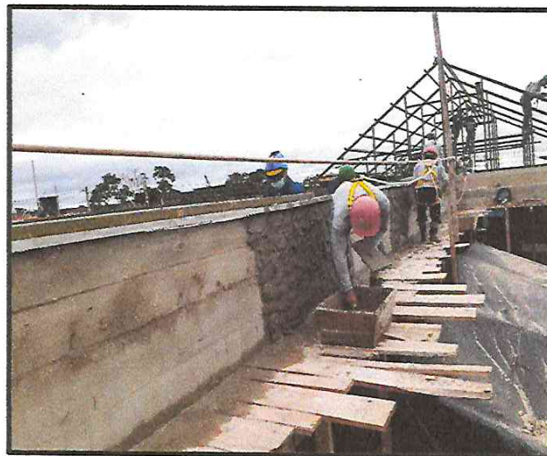
TARRAJEO EN PARAPETOS.
