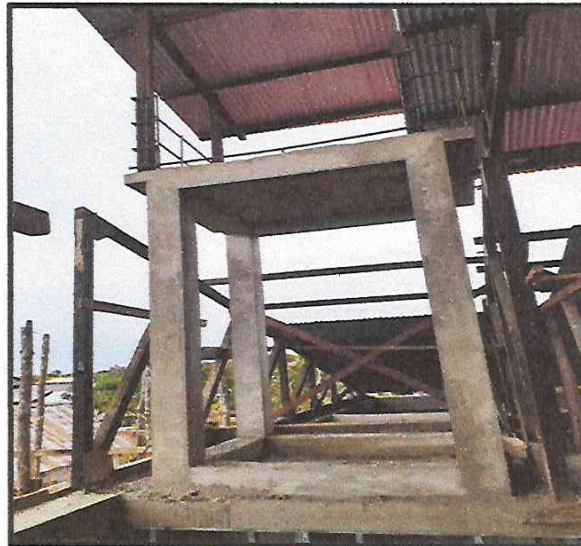
CASTILLO PARA TANQUE ELEVADO.
