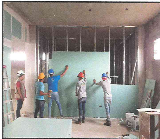
INSTALACIÓN DE TABIQUERIA CON DRYWALL.
