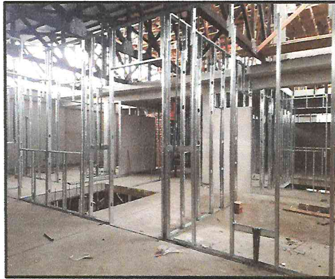
INSTALACIÓN DE TABIQUERÍA CON DRYWALL.
