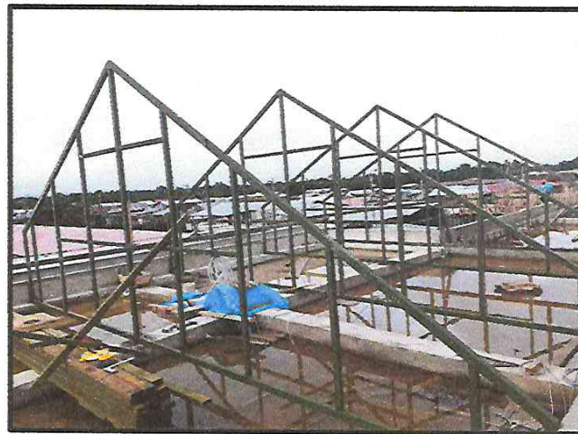
INSTALACIÓN DE TIJERALES METÁLICOS.
