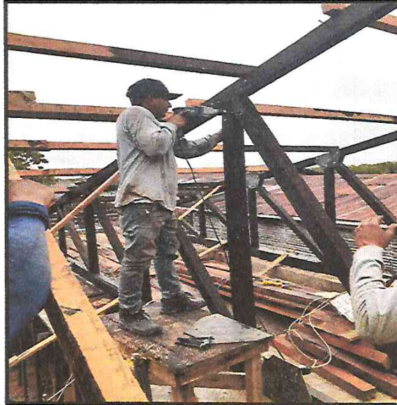
INSTALACIÓN DE TIJERALES DE MADERA.
