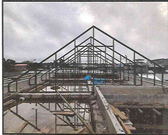
INSTALACIÓN DE TIJERALES METÁLICOS.
