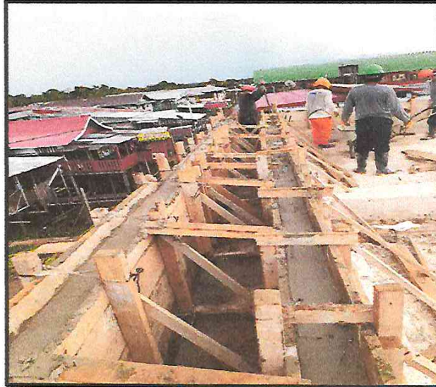
VACEO EN PARAPETOS.
