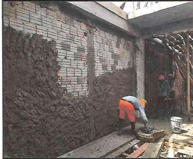
TARRAJEO EN MUROS INTERIORES.
