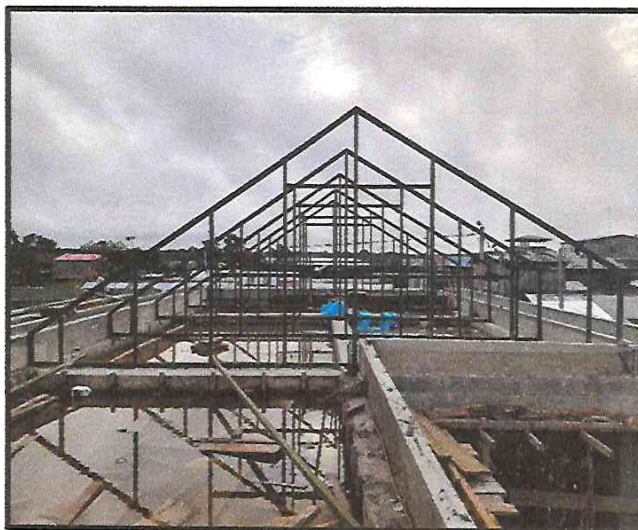
INSTALACIÓN DE TJERALES METÁLICOS.
