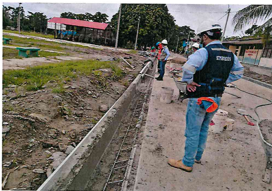
- TARRAJEO PULIDO EN SARDINEL Y LLENADO CON MORTERO F'C=175 KG/CM2
