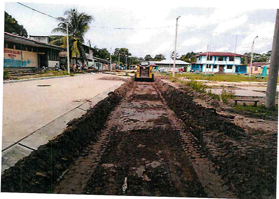
- ELIMINACION DE MATERIAL EXCEDENTE DEL CORTE MANUAL DE TERRENO PARA VEREDAS.
