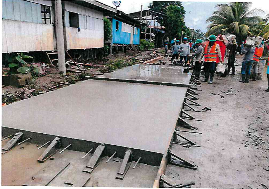
- LLENADO DE LOSA DE RODADURA Y VIBRADO DEL MISMO
