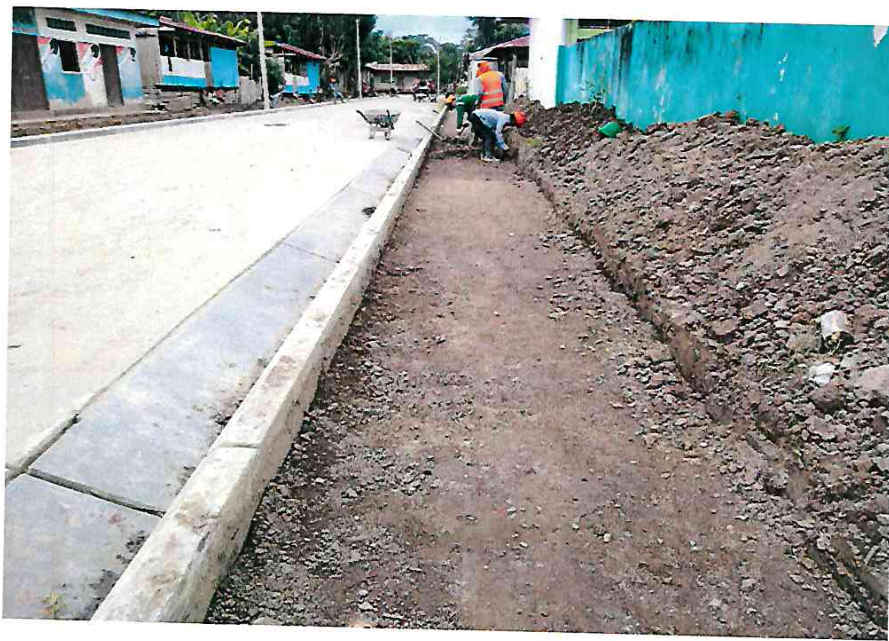
- CORTE MANUAL DE TERRENO PARA VEREDAS.
