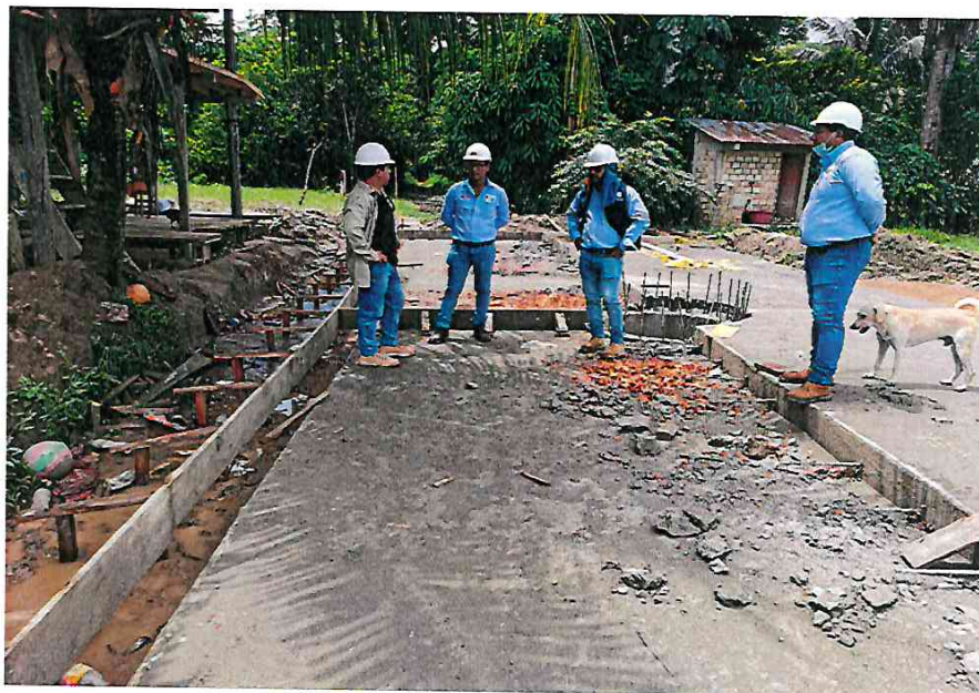
- COORDINACIONES SOBRES LOS TRABAJOS QUE SE REALIZAN DURANTE EL DIA CON SUPERVISION.
