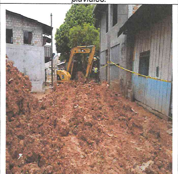
Eliminación de material excedente.
