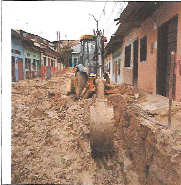
Corte a nivel de sobreexcavación en calle Triangulo de Bermuda.
