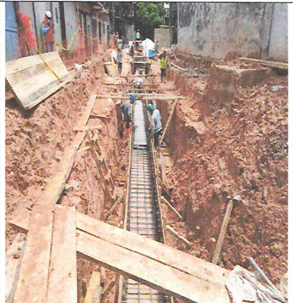
Llenado de mortero en losa y muros de canal.
