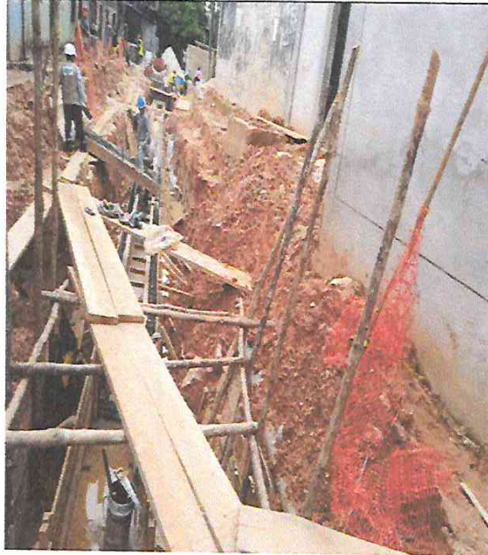
Llenado de mortero en losa y muros de canal.
