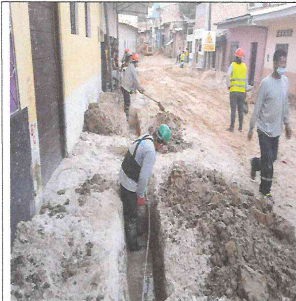
Colocación e instalación de drenaje auxiliar con tubería de PVC 6" en calle prolongación Jose Gálvez.
