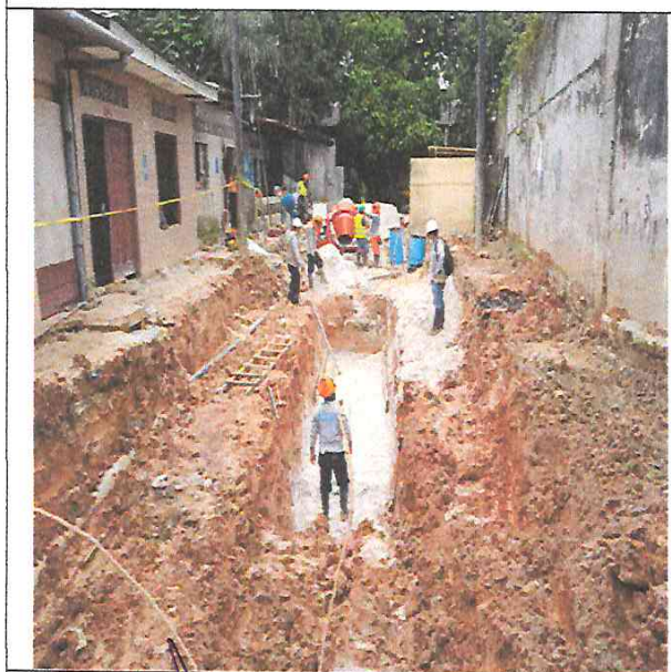
Colocación de cama de arena en zanja canal e=10cm.
