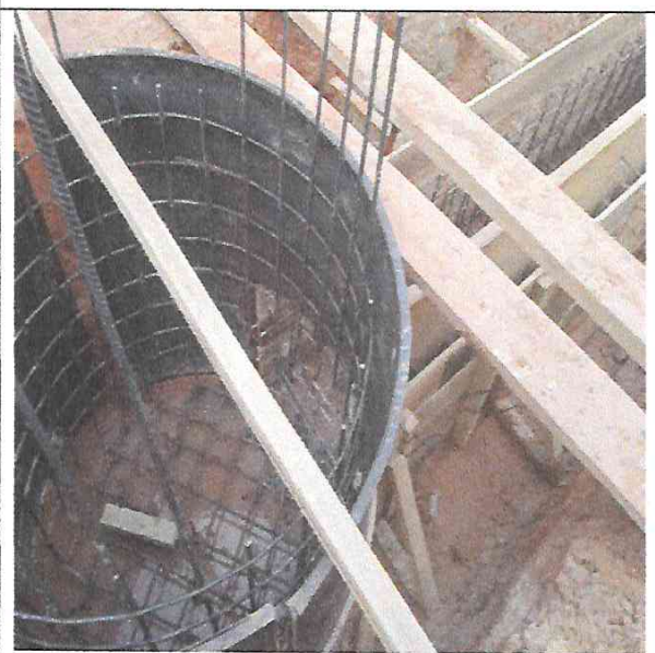
Encofrado de buzones y canales.
