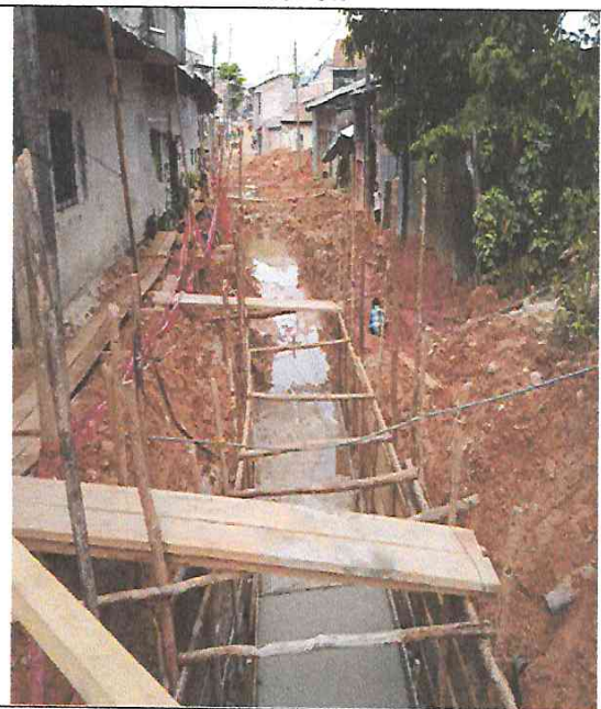
Llenado de solado en zanja canal e=10cm.
