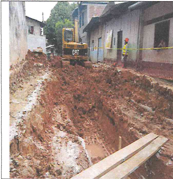
Excavación de zanja canal en calle prolongación Jose Galvez.
