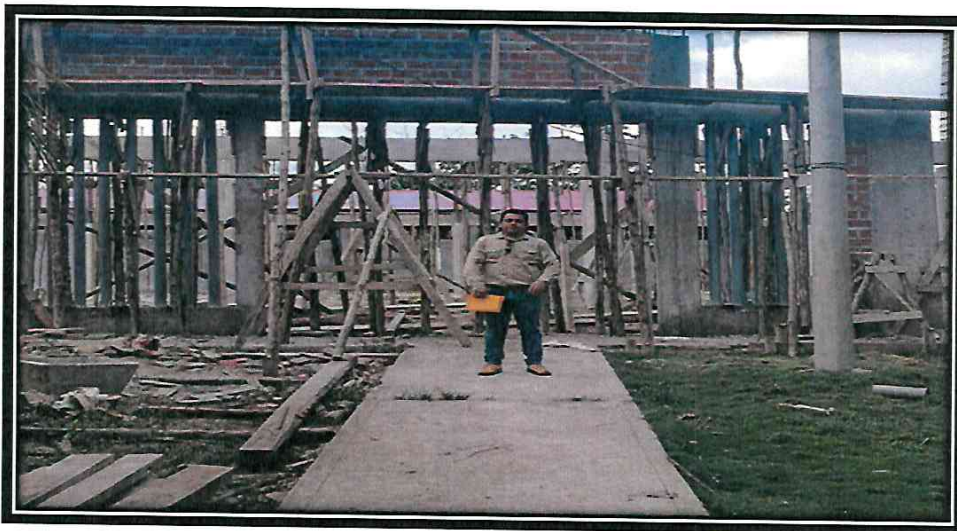
4.0 EN LA FOTO SE APRECIA TRABAJOS DE VEREDAS DE ACCESO HACIA LA ENTRADA PRINCIPAL.
