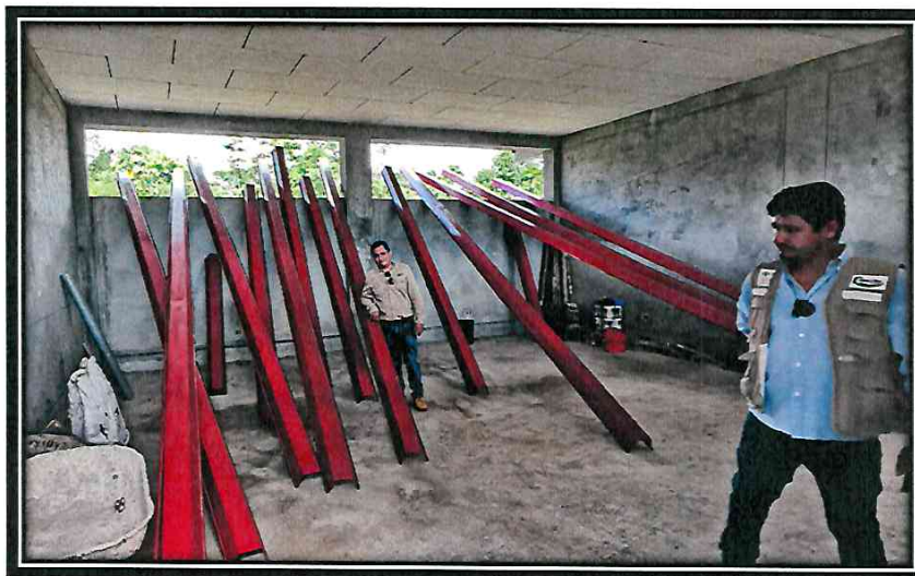
1.0 EN LA FOTO SE APRECIA LA CONSTRUCCION DE PISOS DE MORTERO S/COLOR, E=2.5 CM BRUÑADO Y AL MISMO TIEMPO HABILITACION DE LA CORREA METALICA TIPO CANALES "U" DE 4".
