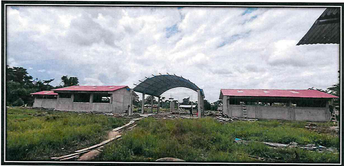
4.00 EN LA FOTO SE PUEDE APRECIAR LA COLOCACION DE CALAMINAS TRASLÚCIDAS EN LOS MODULOS AULA + SS.HH Y SUM COMEDOR.
