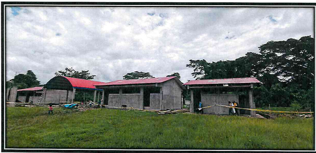
5.00 EN LA FOTO SE PUEDE APRECIAR LA COLOCACION DE CUMBRERA DE CALAMINA ONDULADA ZINC DE 0.26mm EN TODOS LOS MODULOS.
