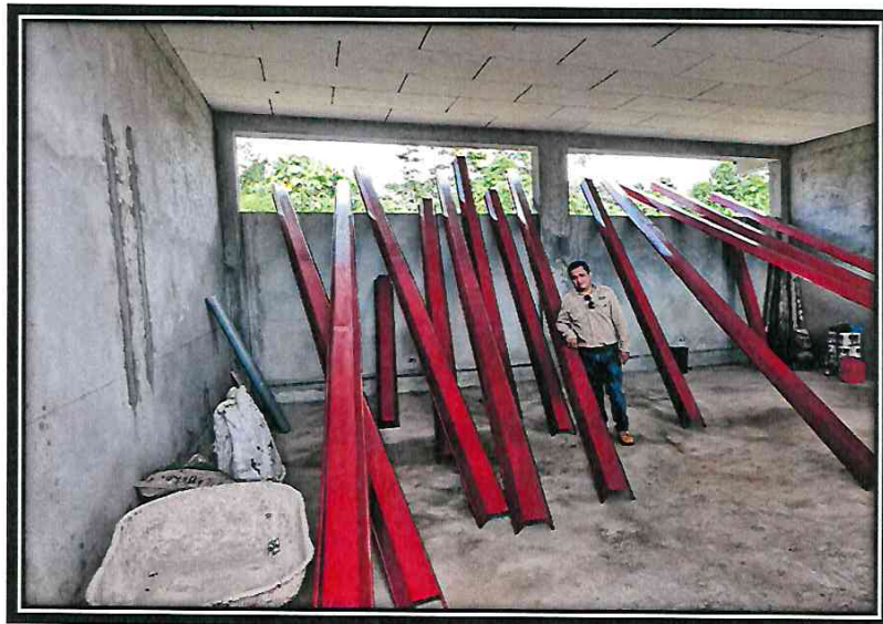
2.0 EN LA FOTO SE APRECIA HABILITACION Y POSTERIOR IZAJE DE LAS CORREA METALICA TIPO CANALES "U" DE 4" LOSA DEPORTIVA.
