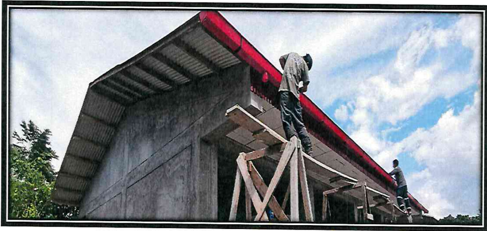
3.0 EN LA FOTO SE APRECIA LA COLOCACION CANALETAS DE PLANCHA GALVANIZADO DE EVACUACIÓN PLUVIAL Ø 8".
