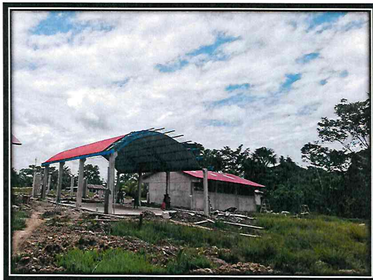
1.00 EN LA FOTO SE APRECIA HABILITACION Y COLOCACION DE LA ARMADURA METALICA, VIGA METALICA Y TEMPLADORES METALICOS EN EL MODULO PATIO DE FORMACION.
