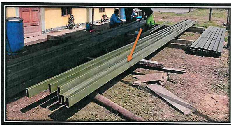
2.0 EN LA FOTO SE APRECIA LA HABILITACION DE LA ESTRUCTURA METALICA PARA LA COBERTURA DEL TECHO EN EL MODULO DE LA LOSA DEPORTIVA.
