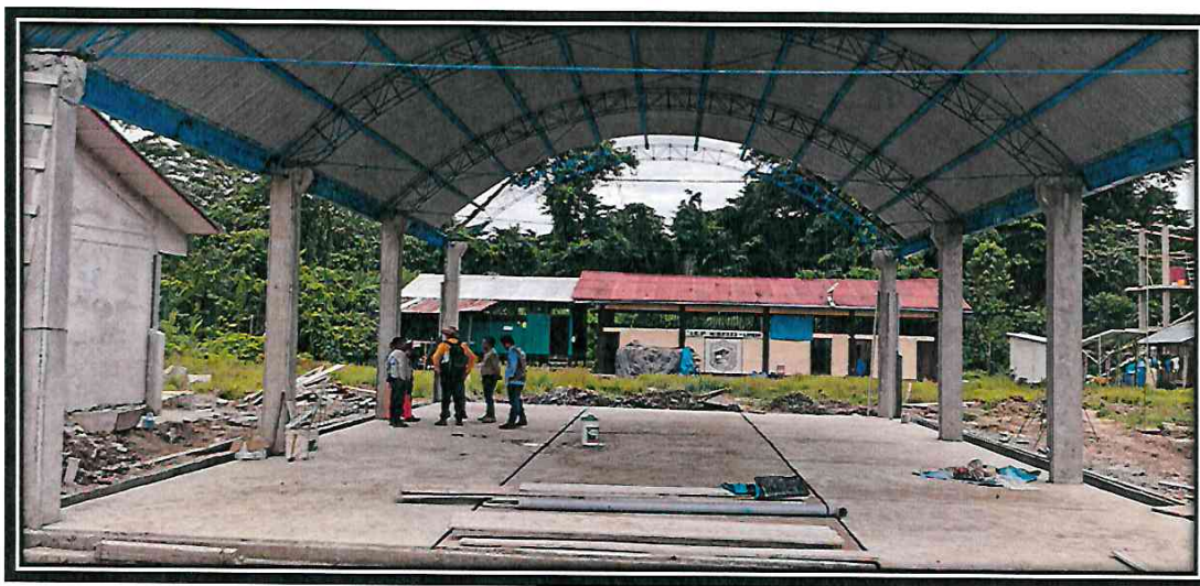
2.00 EN LA FOTO SE APRECIA EL TECHADO DE LA COBERTURA CON FIBRA VEGETAL +BITUMEN ASFALTICO Y CANALETA METALICA EN EL MODULO PATIO DE FORMACION.
