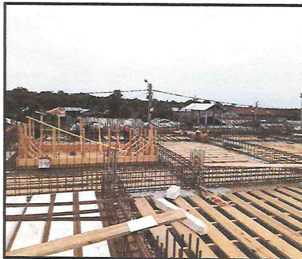
COLOCACIÓN DE MALLA METÁLICA.
