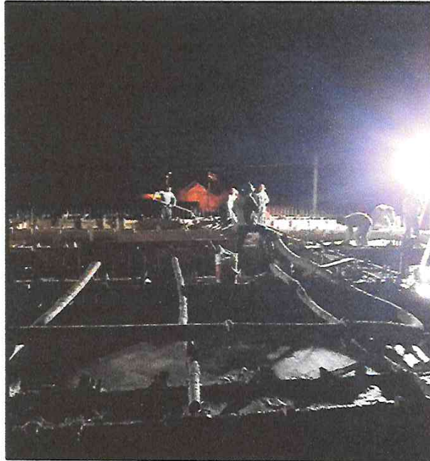
VACEO DE LOSA ALIGERADA.
