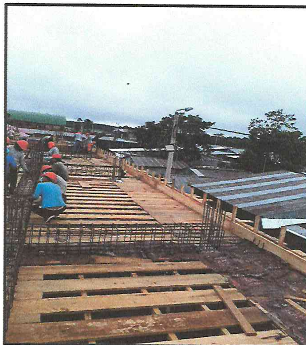
INSTALACIÓN DE ACERO CORRUGADO EN VIGAS.
