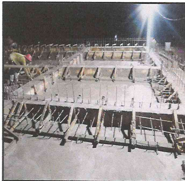
VACEO DE LOSA ALIGERADA.
