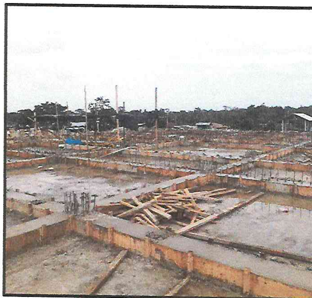
CURADO DE LOSA ALIGERADA.
