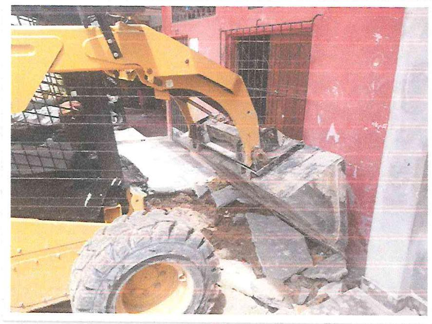
**FOTOGRAFÍA 08: DEMOLICIÓN DE VEREDAS EXISTENTES CALLE 26 DE MAYO**
