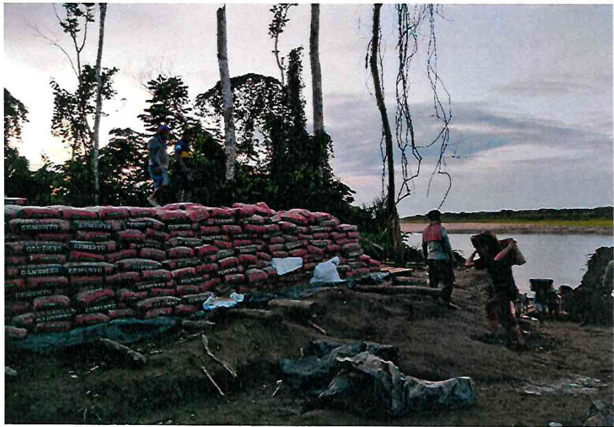
- Transporte de materiales como, cemento, acero de 3/8" 1/2" 5/8".
