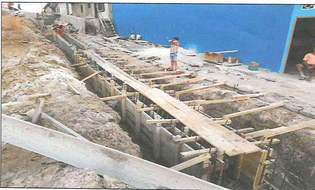
VISTA FOTOGRÁFICA N° 16: ENCOFRADO Y DESENCOFRADO EN MUROS LATERALES EN CANAL RECTANGULAR DE ALCANTARILLADO EN CALLE AMÉRICA TRAMO II.
