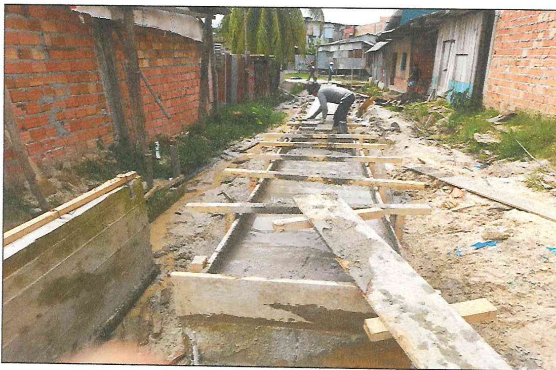
VISTA FOTOGRÁFICA N° 08: VACEADO DE LOSA DE RODADURA EN CALLE LAGUNAS TRAMO III.
