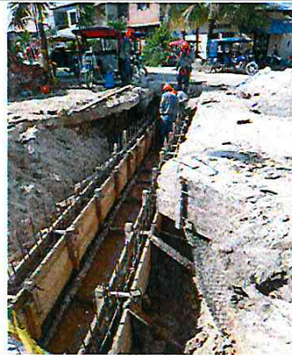
Vista: Encofrado de Muro de canal en Empalme de Ca. San Roman c/ Ca. Atahualpa
