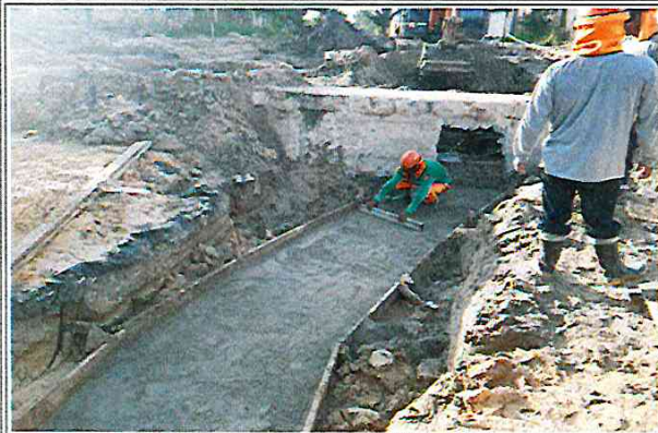
Vista: Vaceo de solado de canal - Empalme Ca. Libertad / Ca. Vargas Guerra
