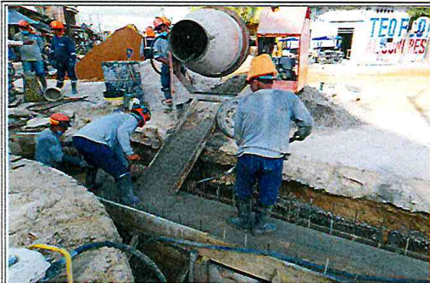
Vista: Vaceo de muro de canal rectangular - Empalme de Ca. San Roman c/ Ca. Atahualpa
