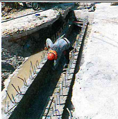
Vista: Enlucido de muro de canal rectangular Ca. San Roman c/ Ca. Atahualpa
