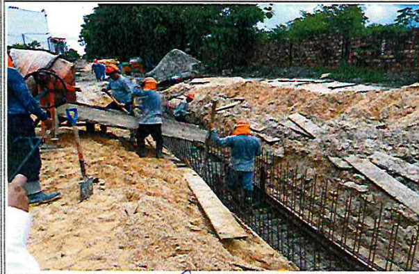
Vista: Vaceo de losa de fondo de canal Ca. Libertad cuadra 14
