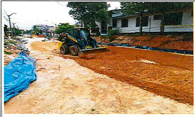
Vista: Colocación de material A-2-4 para Sub Base -San Roman ( Ca. Libertad/ Ca. Atahualpa)
