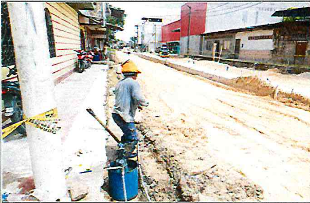
Vista: Ejecución de la prueba hidraulica - Pje. Independencia (Ca. Jose Galvez/Av. Del ejercito)
