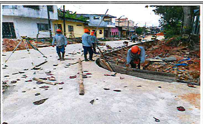
Vista: Encofrado para losa de rodadura Ca. San Roman c/ Ca. Libertad
