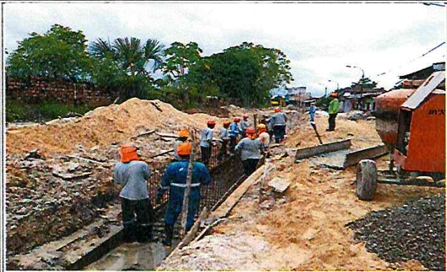
Vista: Habilitación de acero de canal para muros- Ca. Libertad (Ca. Independencia / Ca. Vargas Guerra)
