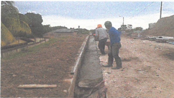
VACIADO DE CONCRETO F'C=175 KG/CM2 EN CUNETAS, EN JR. 2 DE MAYO
