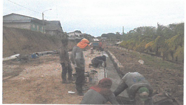
ENCOFRADO, ACERO Y VACIADO DE CUNETAS, EN JR. 2 DE MAYO
