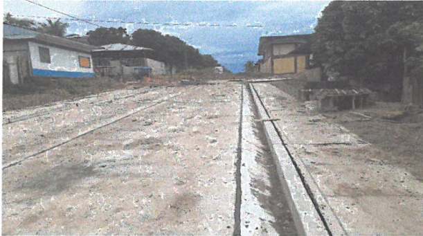
RELLENO DE JUNTAS EN SARDINEL, EN JR. 2 DE MAYO
