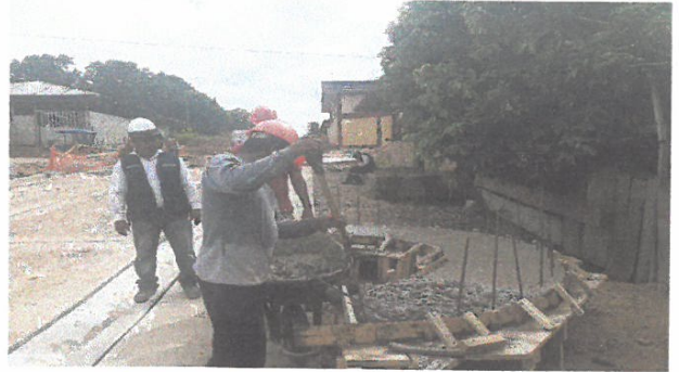
VACIADO DE CONCRETO F'C=175 KG/CM2 EN BANCAS, EN JR. 2 DE MAYO
