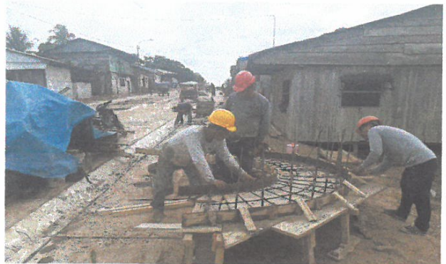
ENCOFRADO DE BANCAS, EN JR. 2 DE MAYO
