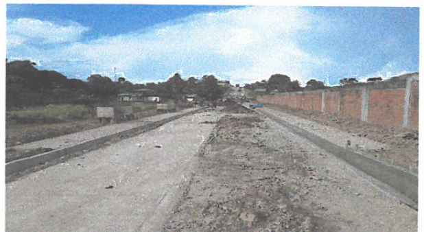
VACIADO DE CONCRETO EN CUNETAS F'C=175 KG/CM2, EN JR. 2 DE MAYO
