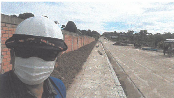
VACIADO DE CONCRETO EN CUNETAS F'C=175 KG/CM2, EN JR. 2 DE MAYO
