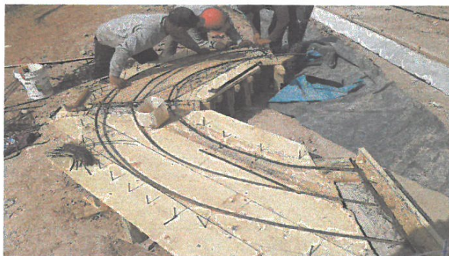
ENCOFRADO DE BANCAS, EN JR. 2 DE MAYO
