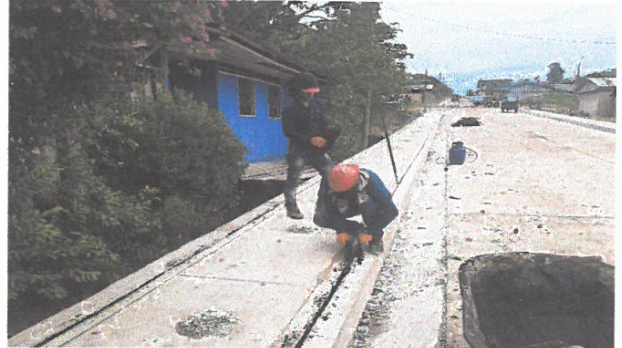
RELLENO DE JUNTAS EN VEREDAS, EN JR. 2 DE MAYO
