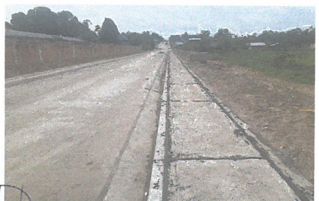
RELLENO DE JUNTAS EN VEREDAS, EN JR. 2 DE MAYO
