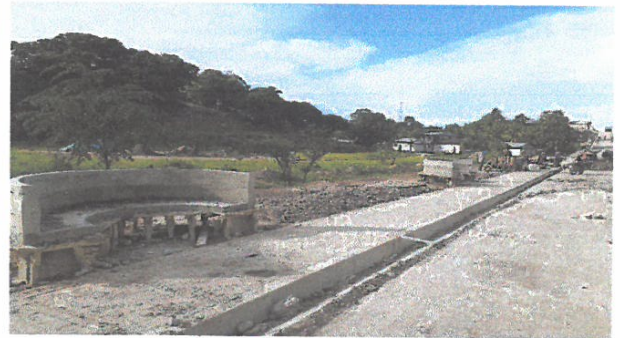
CUNETAS TERMINADAS, EN JR. 2 DE MAYO
