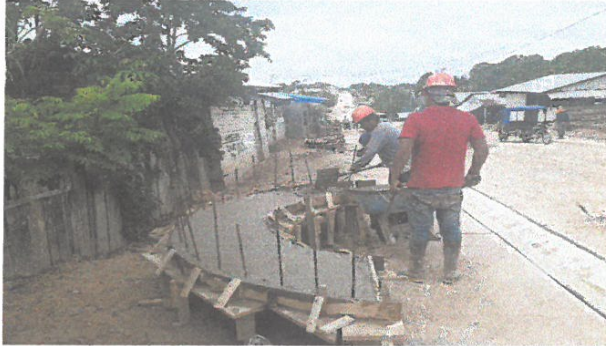
VACIADO DE CONCRETO F'C=175 KG/CM2 EN BANCAS, EN JR. 2 DE MAYO
