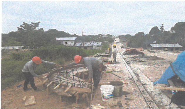
ENCOFRADO DE BANCAS, EN JR. 2 DE MAYO
