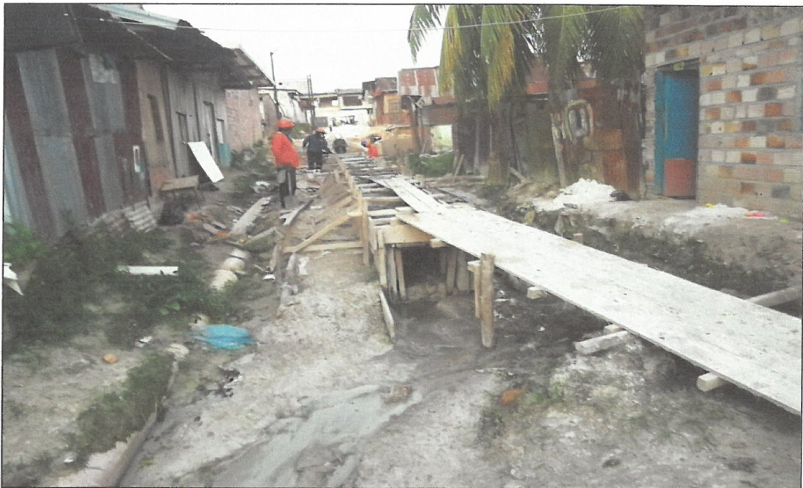
VISTA FOTOGRÁFICA N° 04: VACEADO DE LOSA DE RODADURA EN CALLE LAGUNAS TRAMO III.
