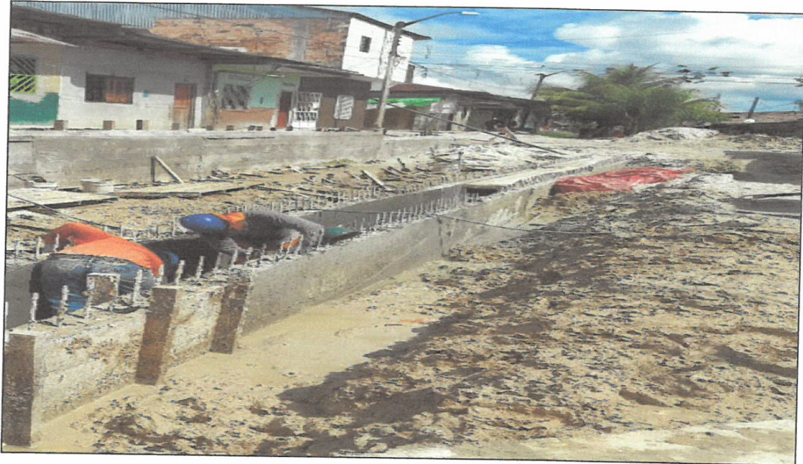
VISTA FOTOGRÁFICA N° 08: ACERO CORRUGADO 1/2" EN CANAL DE ALCANTARILLADO EN CALLE SALAVERRY.
