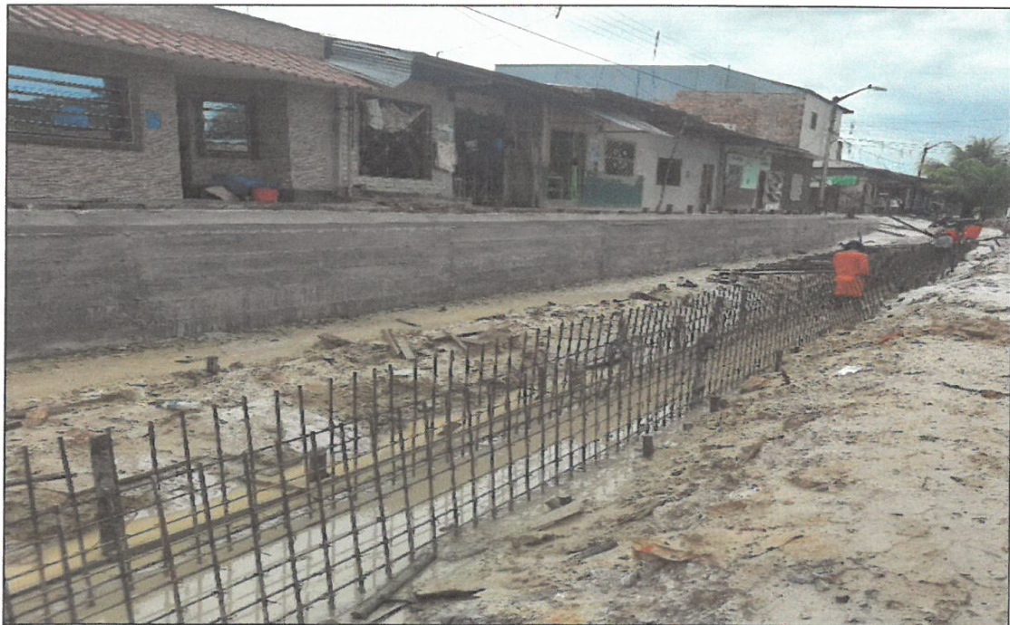
VISTA FOTOGRÁFICA N° 02 : ACERO CORRUGADO 1/2" EN CANAL DE ALCANTARILLADO EN CALLE SALAVERRY.
