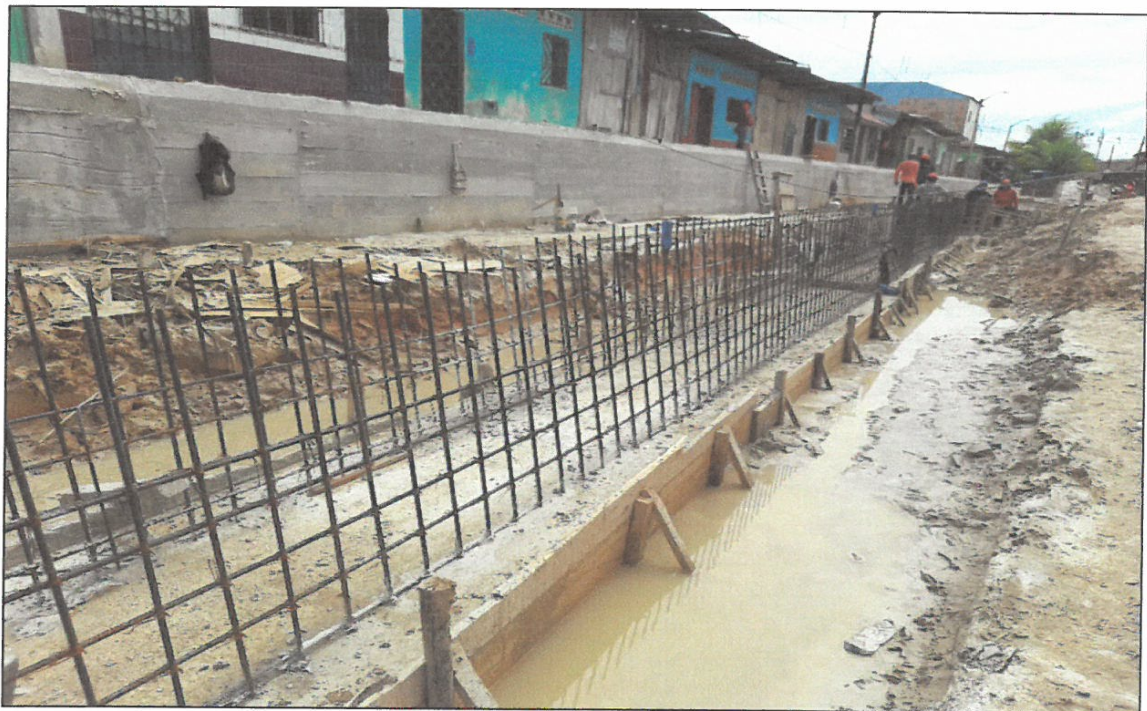
VISTA FOTOGRÁFICA N° 06: ACERO CORRUGADO 1/2" EN CANAL DE ALCANTARILLADO EN CALLE SALAVERRY.
