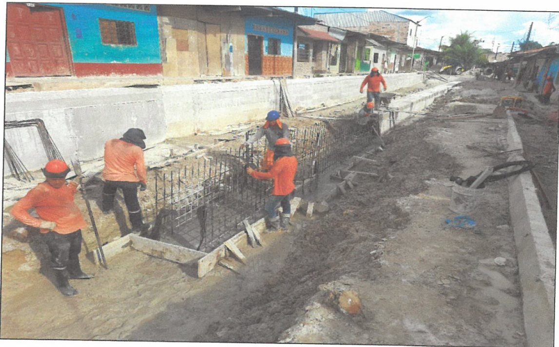
VISTA FOTOGRÁFICA N° 08: ACERO CORRUGADO 1/2" EN CANAL DE ALCANTARILLADO EN CALLE SALAVERRY.
