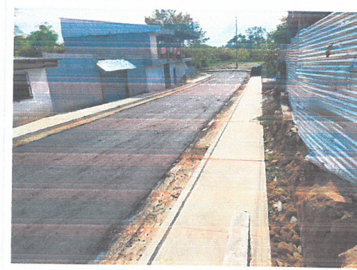
Verificación de la imprimación bituminosa en la calle Jáuregui.
