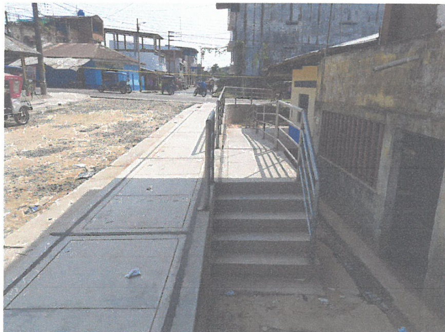
VISTA DE LAS PASAMANO METALICO CON TUBO DE ACERO GALVANIZADO, EN LA CALLE TARATA CUADRA 6
