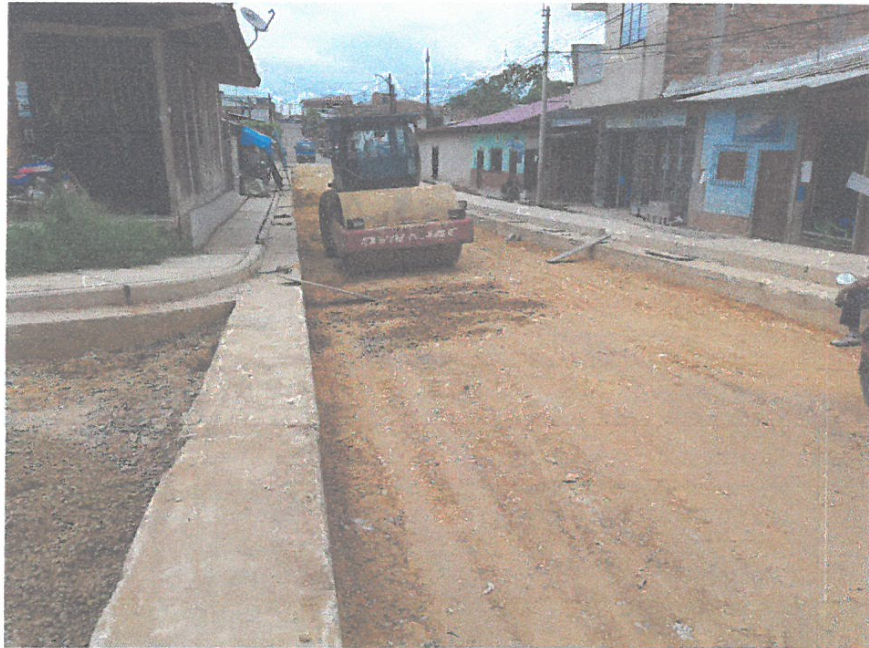
TRABAJOS DE COMPACTACIÓN CON RODILL, A NIVEL DE SUB RASANTE.
