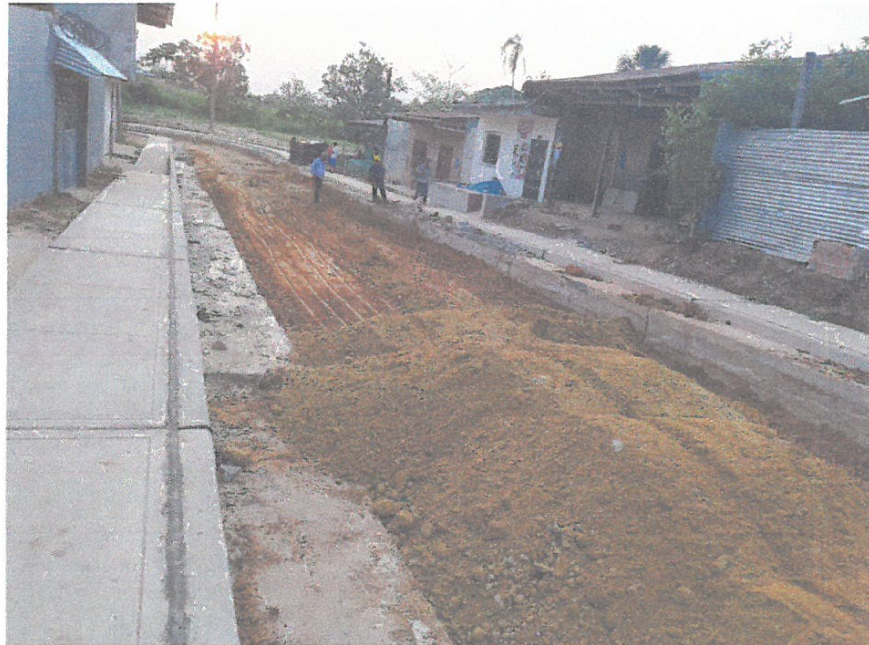
COLOCACIÓN DE MATERIAL PARA SUB BASE.
