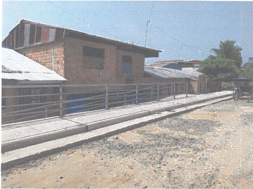
VISTA PANORÁMICA DE LOS TRABAJOS DE PASAMANOS METÁLICOS
