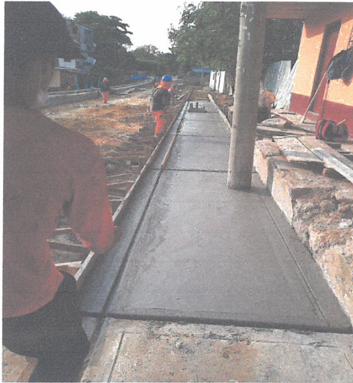
TRABAJOS DE BRUÑADO EN VEREDAS DE CALLE 6 DE FEBRERO, LADO IZQUIERDO.
