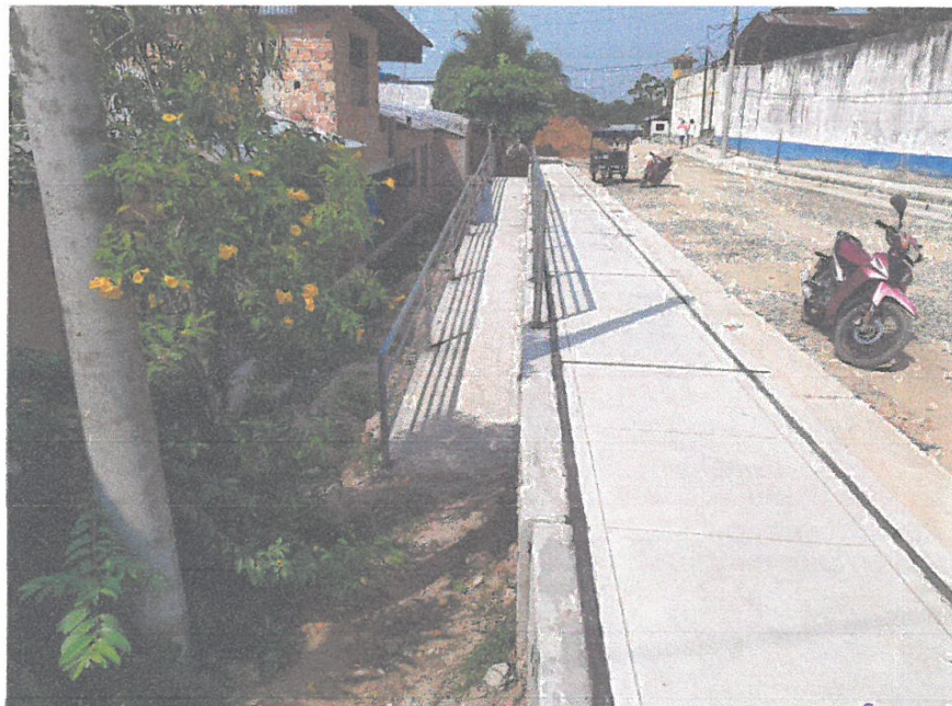
TRABAJOS DE PASAMANOS EN RAMPAS.
