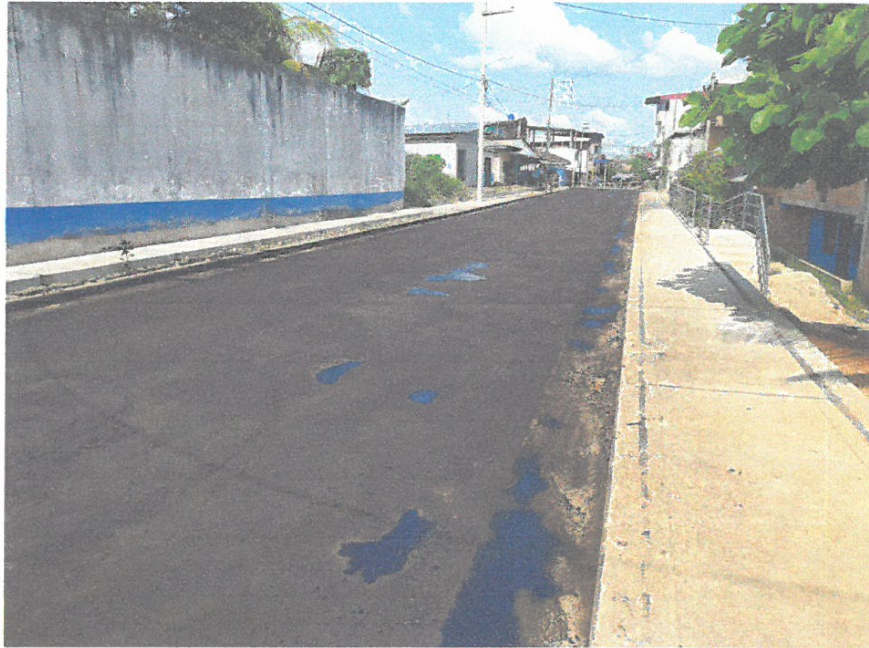
IMPRIMACIÓN BITUMINISA EN LA CCALLE TARATA CUADRA 6.
