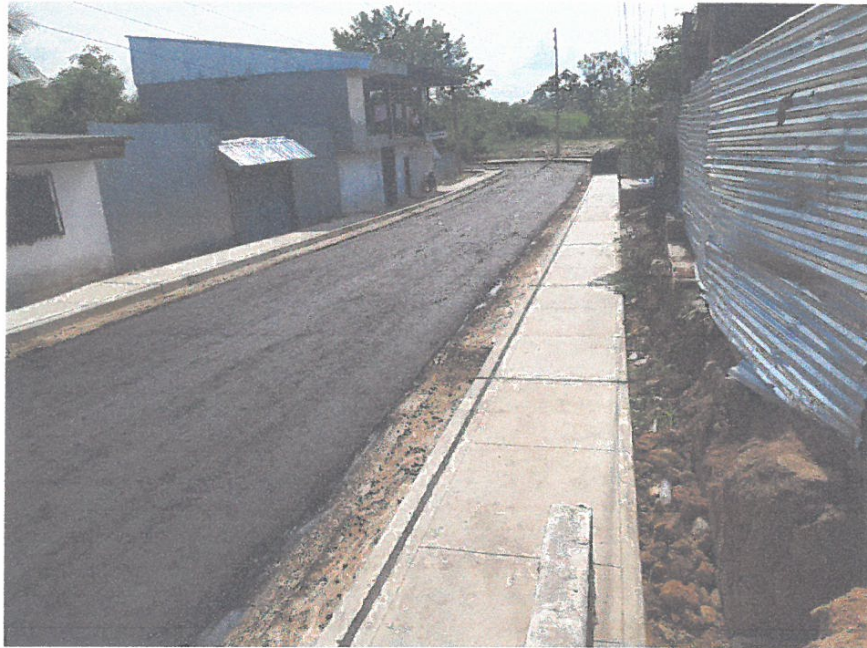
IMPRIMACIÓN BITUMINOSA, CALLE JAUREGUI.
