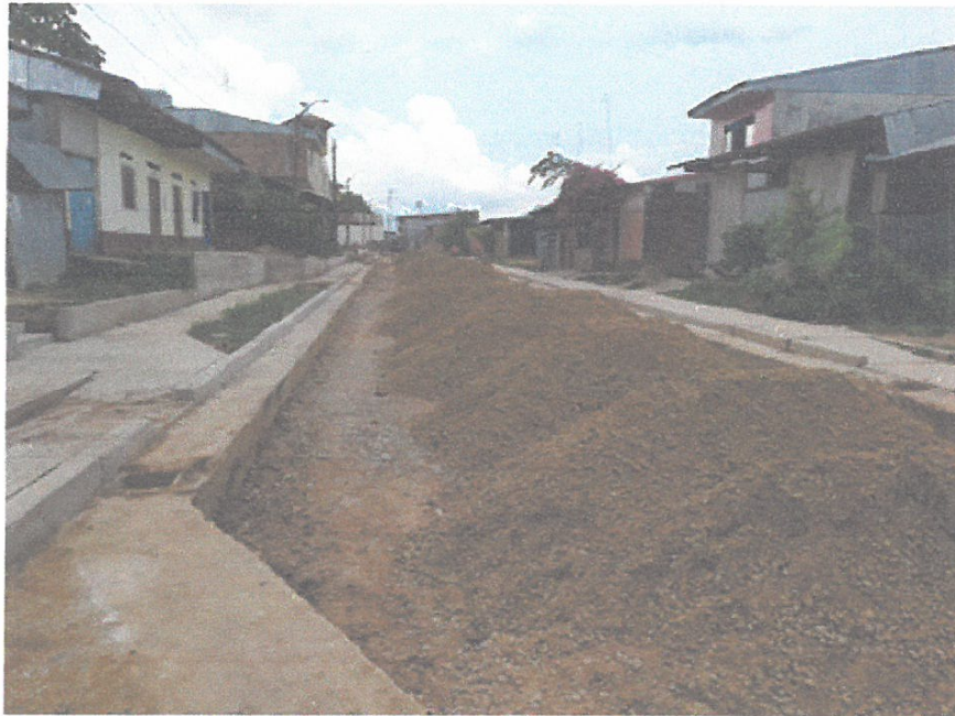
COLOCACIÓN DE MATERIAL PARA BASE.
