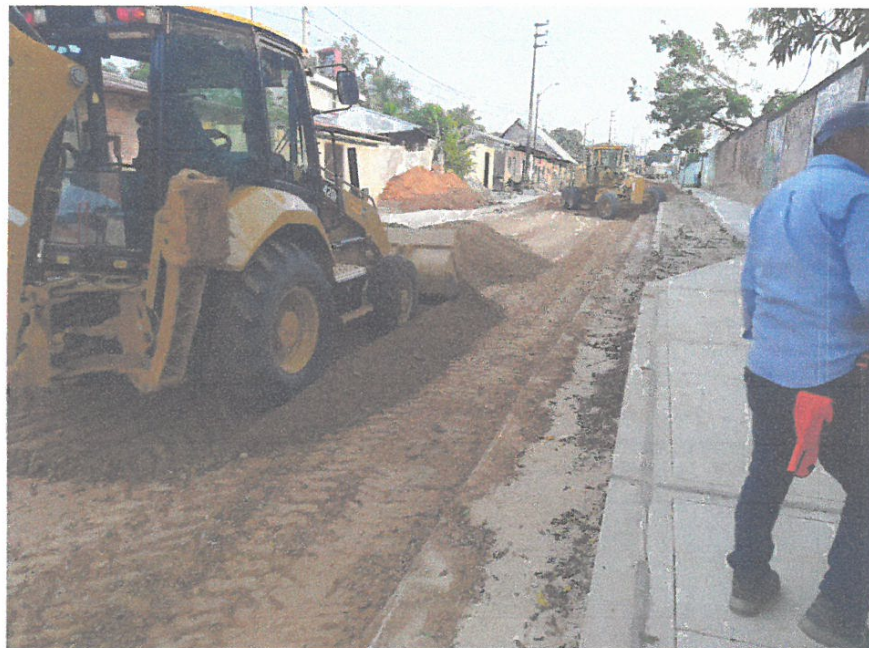
EXPARCIDO DE BASE CON MAQUINARIA PESADA.
