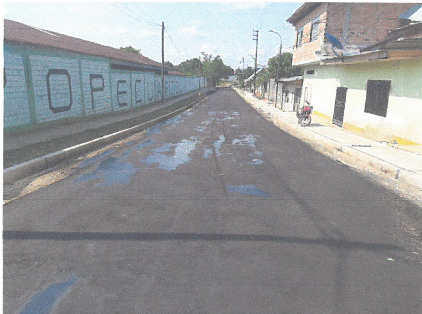
IMPRIMACIÓN BITUMINOSA, CALLE RAYMONDI.
