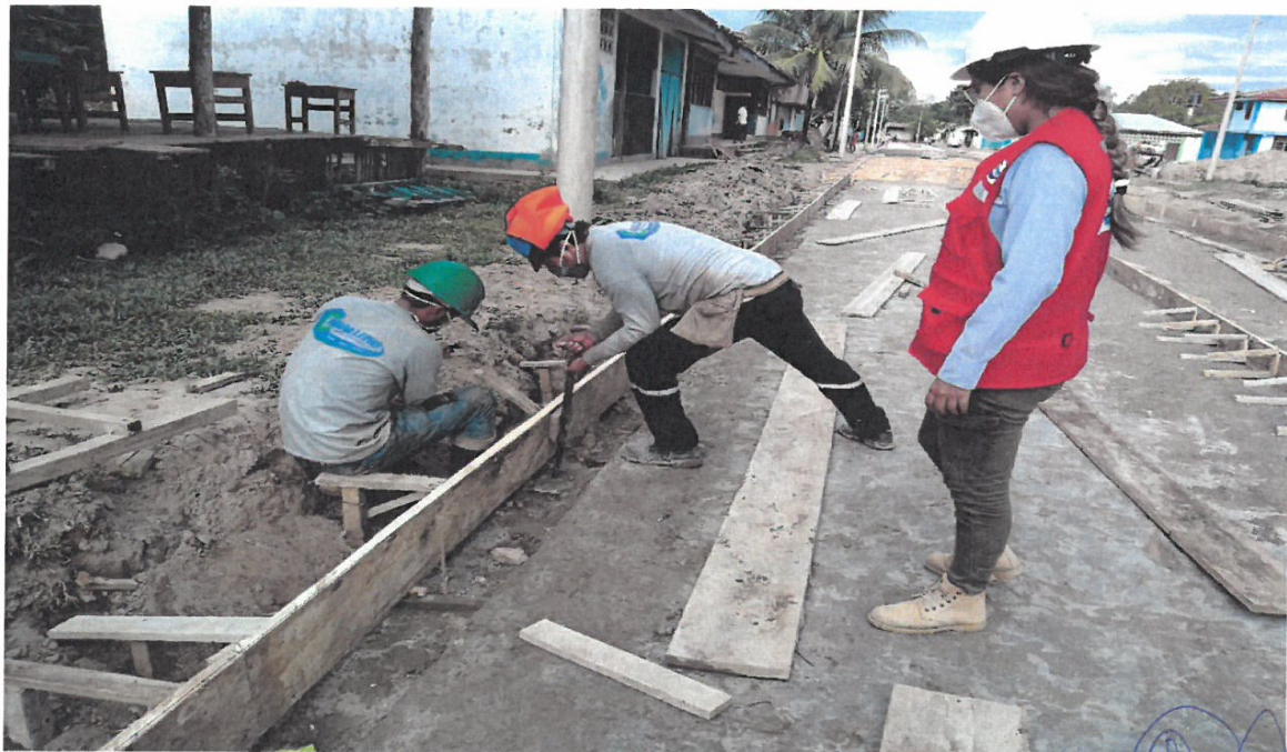
Imagen 8 Supervisión de seguridad en el trabajo de carpintería (encofrado)
