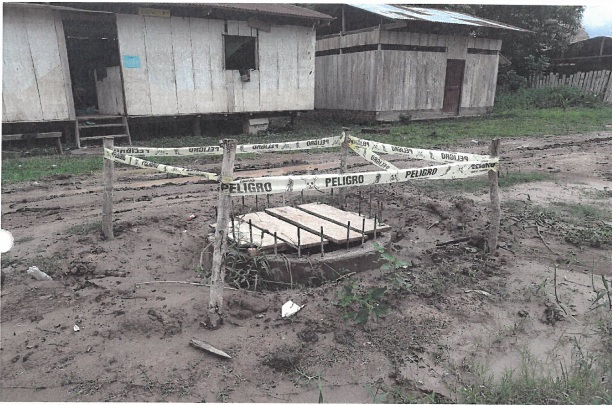
Imagen 3 Protección Colectiva. Colocación de tapas en los buzones abiertos de las calles no pavimentadas
