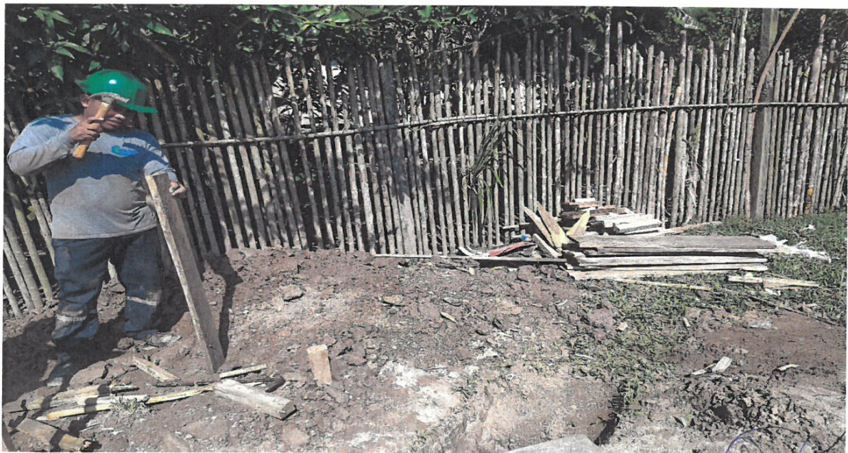
Imagen 6 Retiro de clavos después del desencofrado y colocación de tablas de forma ordenada para posteriormente llevarlo al punto de acopio.
