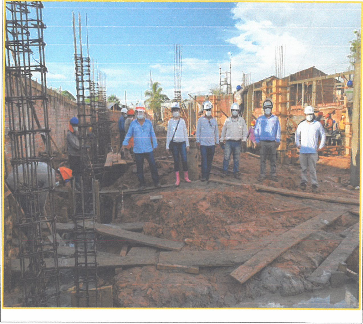
FOTO N°09: Vaceo en vigas de cimentación y armadura para columnas.
