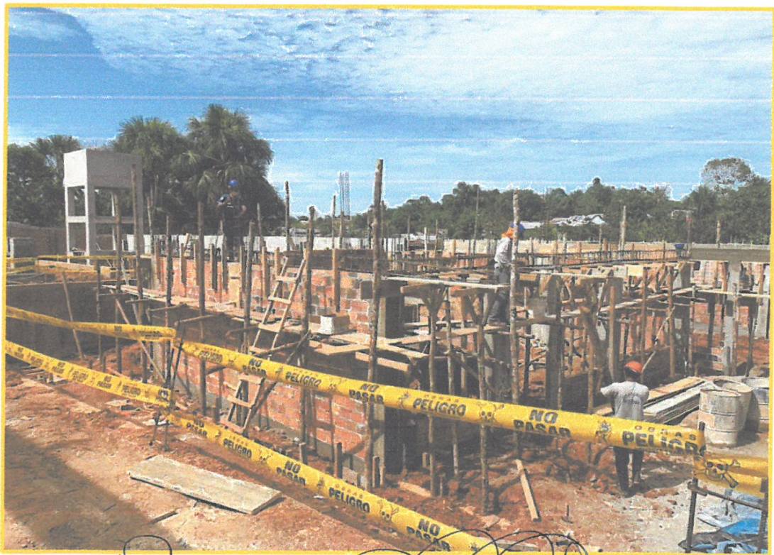
FOTO N°11: Habilitación de acero en Viga Collarín.
