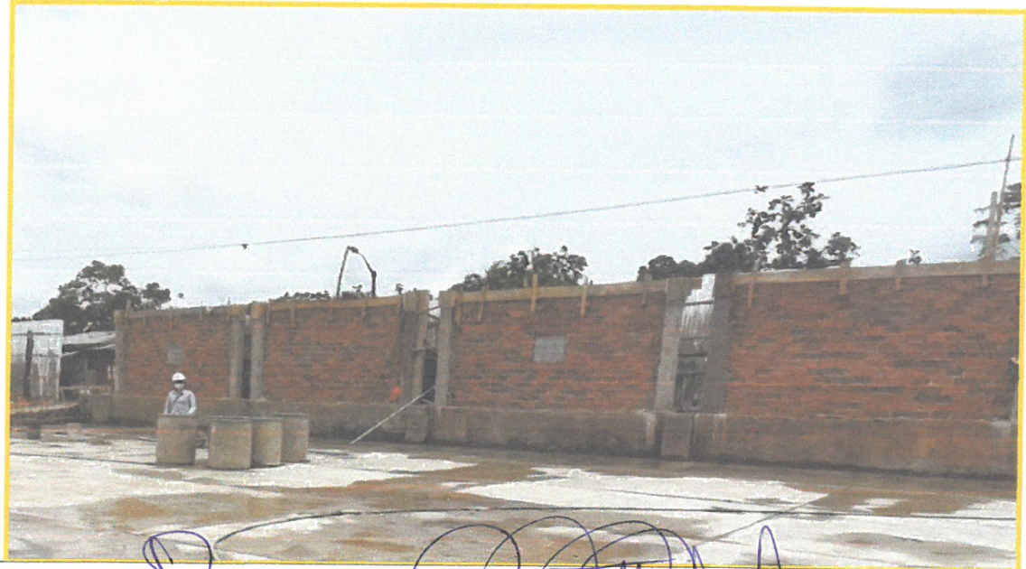
FOTO N°08: Imagen panorámica de encofrado de vigas de amarre en muro perimétrico, posteriormente al vacceo.
