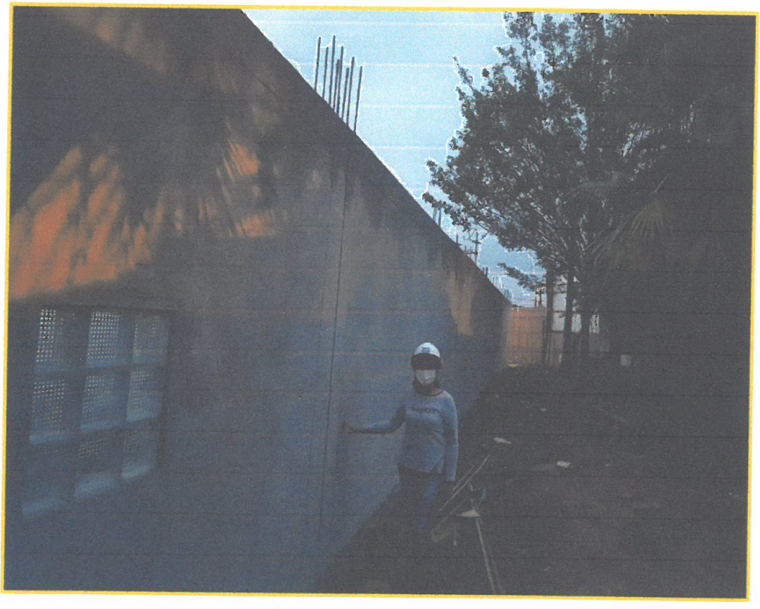
FOTON°14: Se observa los trabajos tarrajeo en exterior de muro perimétrico.
