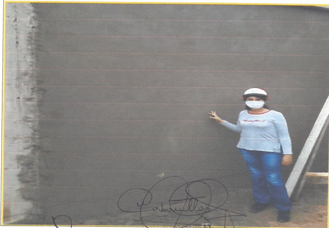
FOTO N°13: Se observa los trabajos tarrajeo en interior de muro perimétrico.
