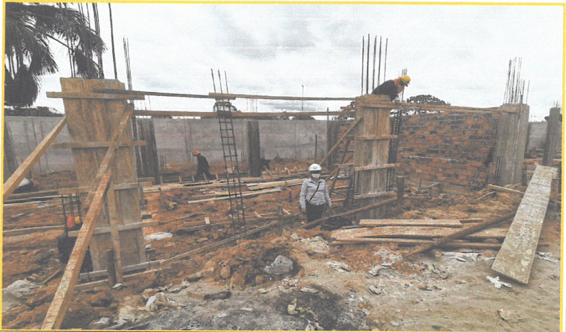
FOTO N°11: Habilitación de acero en Viga Collarín.
