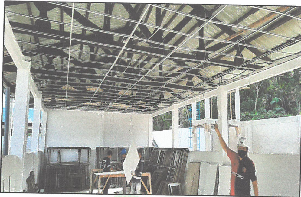
FOTO N°09: COLOCACION DE PERFILES DE ALUMINIO EN CIELORAZO
