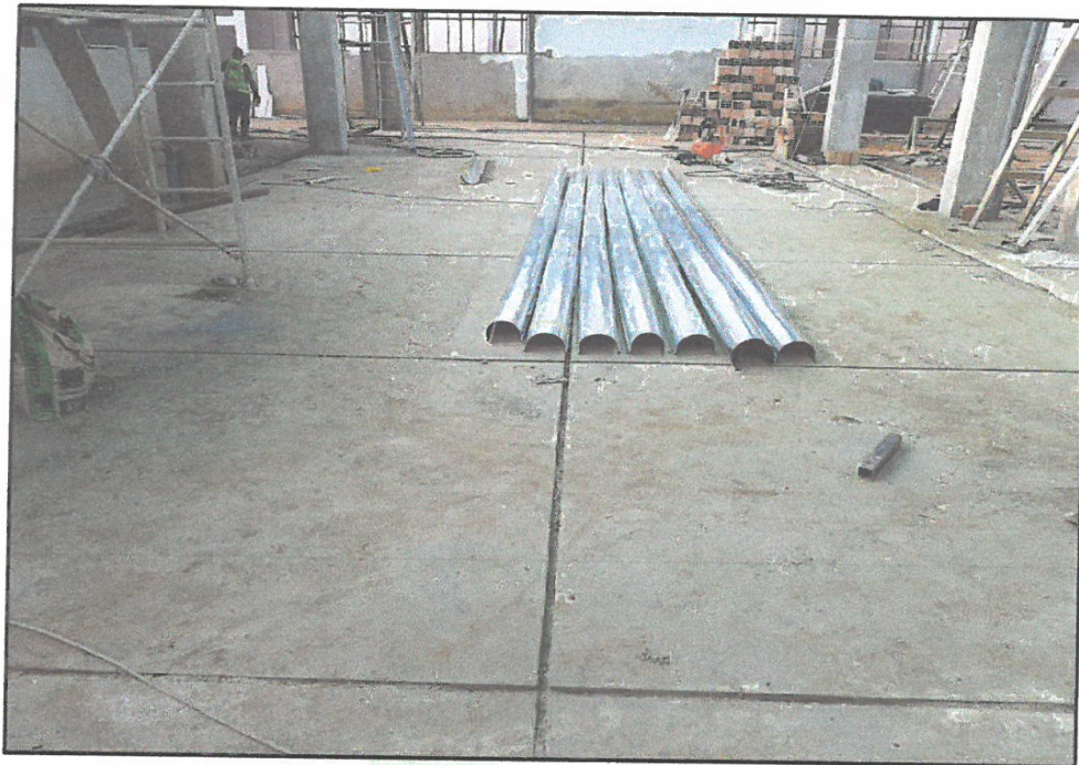
FOTO N°03: PISO TERMINADO EN PATIO DE FORMACIÓN DE INICIAL, Y CONFECCION DE CANALETAS PARA EVACUACIÓN DE AGUAS DE LLUVIA EN MODULOS
