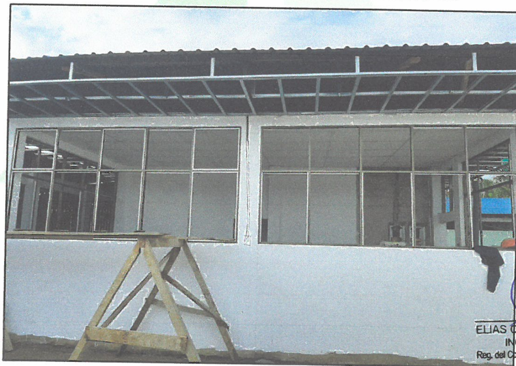
FOTO N°10: INSTALACIÓN DE PERFILES DE ALUMINO EN FRIZO
