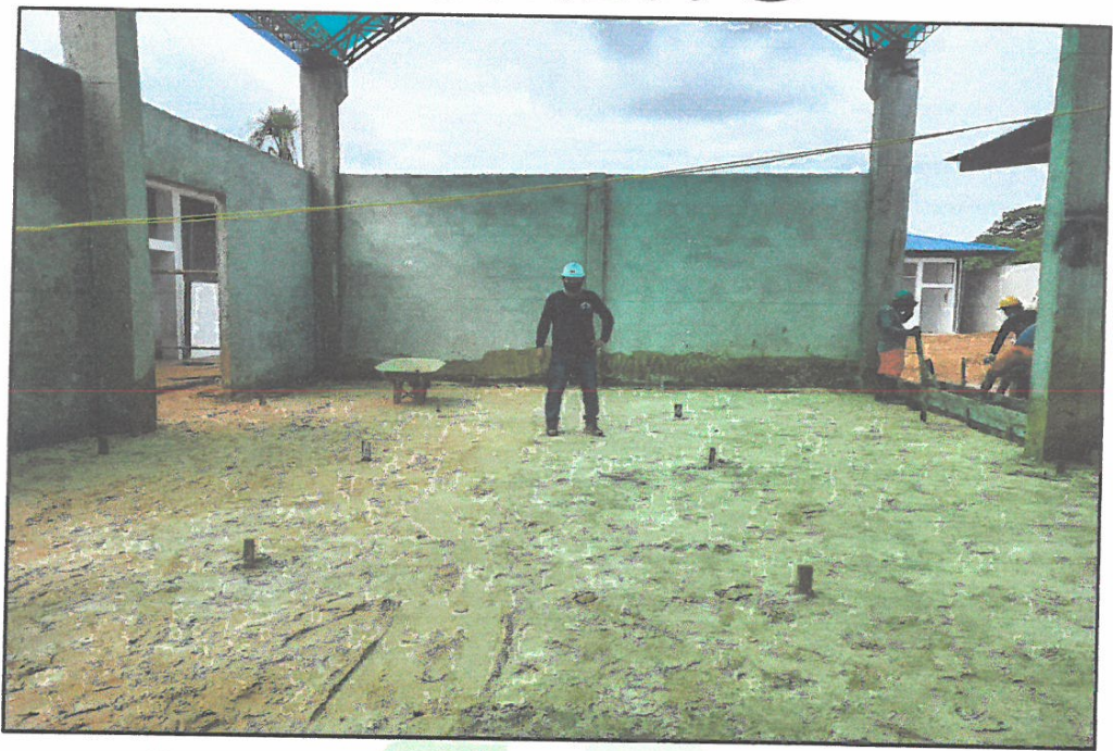
FOTO N°01: PREPARACIÓN DE TERRENO PARA VACEO DE SOLADO EN PATIO DE FORMACIÓN DE INICIAL.
