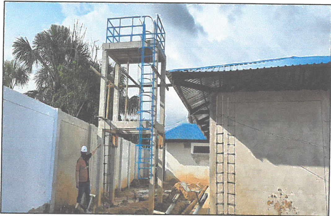
FOTO N°13: INSTALACIÓN DE ESCALERA TIPO GATO Y BARANDAS EN TANQUE ELEVADO
