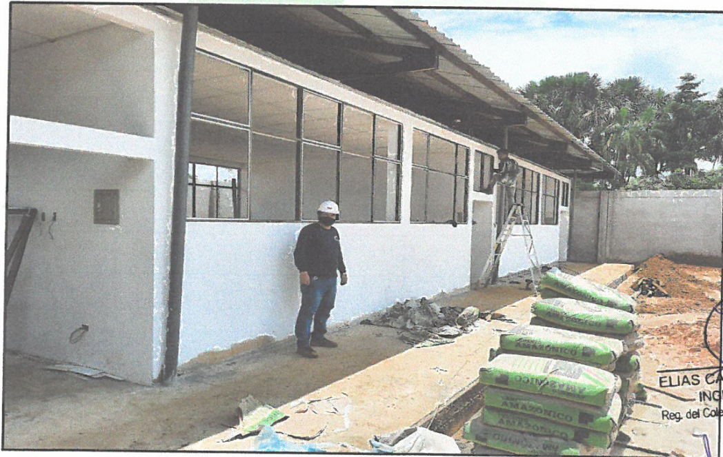
FOTO N°08: INSTALACIÓN DE MARCOS DE VENTANA EN ALUMINIO EN MODULOS.
