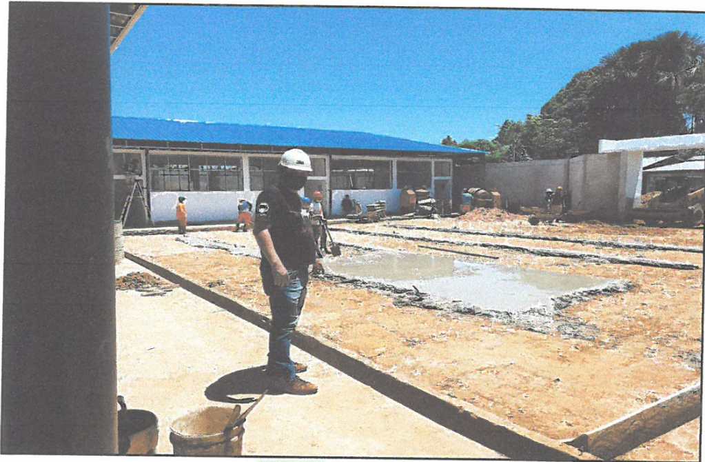
FOTO N°05: VACEO DE SOLADO EN PATIO DE FORMACIÓN PRIMARIA.
