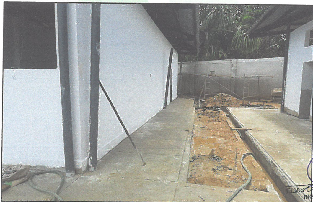
FOTO N°12: VISTA DE COLOCACIÓN DE TUBERIAS PARA BAJADAS DE AGUA DE LLUVIA.
