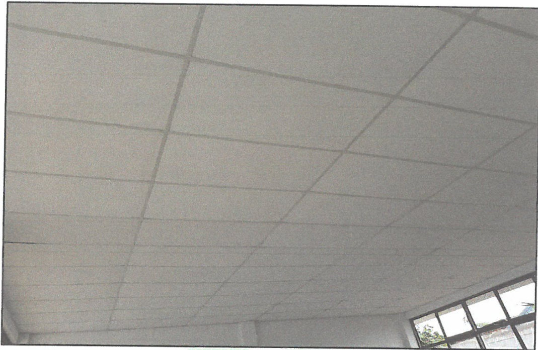
FOTO N°11: COLOCACIÓN DE PLANCHAS DE FIBROCEMENTO EN CIELORRAZO
