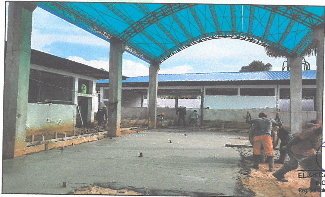
FOTO N°02: VACEO DE SOLADO EN PATIO DE FORMACIÓN DE INICIAL.
