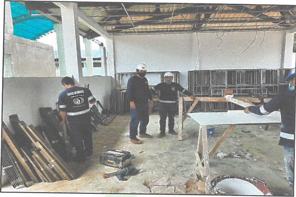
FOTO N°07: ARMADO DE MARCOS CON ALUMINIO EN VANOS PARA VENTANAS.
