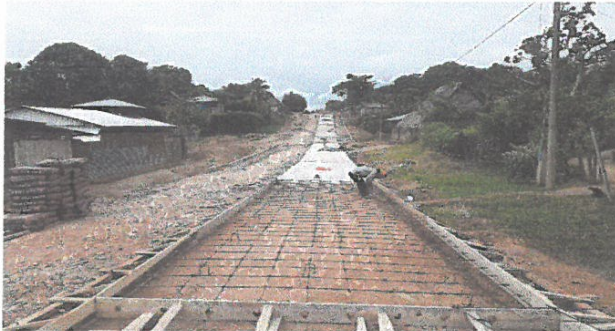
ENCOFRADO PARA PAVIMENTO, EN JR. 2 DE MAYO ENTRE JR. CONTAMANA Y JR. SAN JUAN
