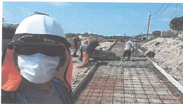
VACIADO DE CONCRETO F'C=210 KG/CM2, EN JR. 2 DE MAYO ENTRE JR. REQUENA Y JR. LIBERTAD
