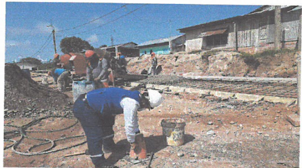
PRUEBA DE SLUMP EN VACIADO DE CONCRETO F'C=210 KG/CM2, EN JR. 2 DE MAYO ENTRE JR. REQUENA Y JR. LIBERTAD
