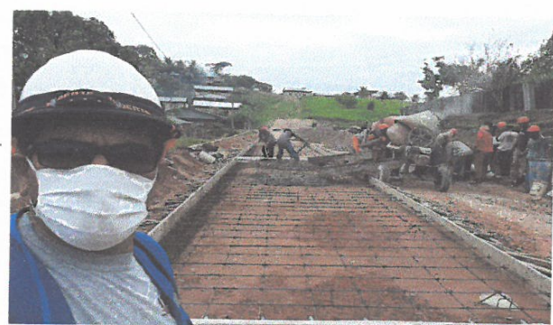
VACIADO DE CONCRETO F'C=210 KG/CM2, EN JR SAN JUAN ENTRE JR 2 DE MAYO Y JR. ZAPATA
