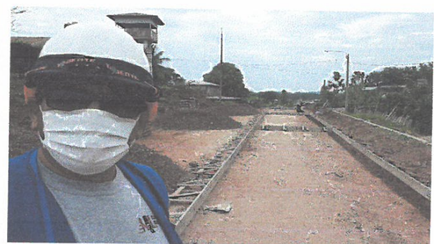
ENCOFRADO DE PAVIMENTO, EN JR. SAN JUAN ENTRE JR 2 DE MAYO Y JR. ZAPATA
