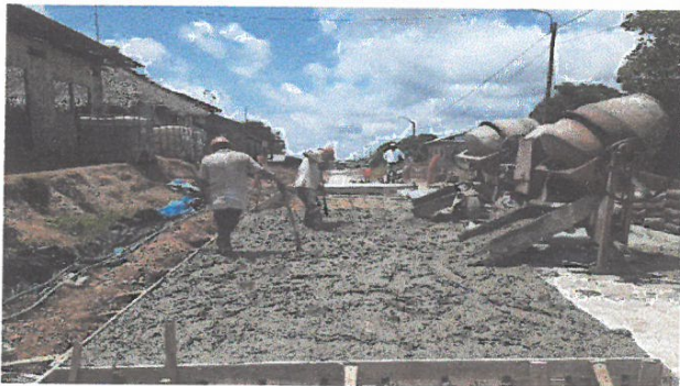
VACIADO DE CONCRETO F'C=210 KG/CM2, EN JR. 2 DE MAYO ENTRE JR MARIATEGUI Y JR. PROGRESO
