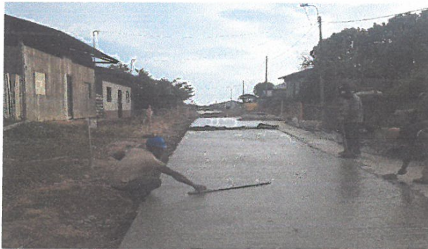
VACIADO DE CONCRETO F'C=210 KG/CM2, EN JR. 2 DE MAYO ENTRE JR LIBERTAD Y JR. MARIATEGUI
