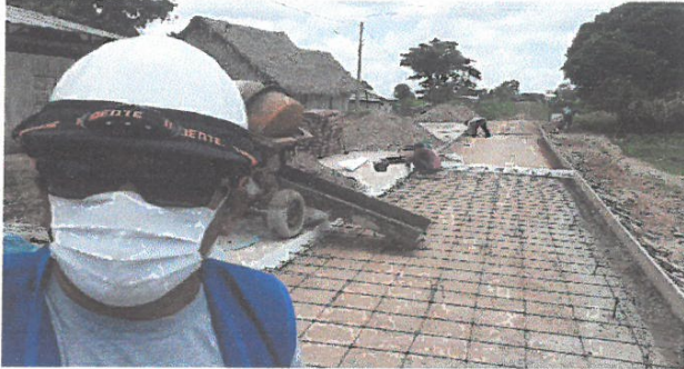
VACIADO DE CONCRETO F'C=210 KG/CM2, EN JR. 2 DE MAYO ENTRE JR PROGRESO Y JR. CONTAMANA
