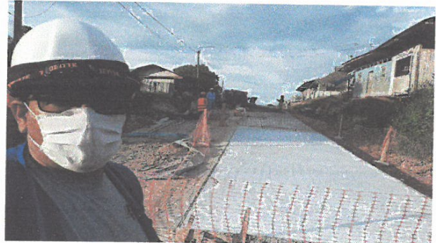
VACIADO DE CONCRETO F'C=210 KG/CM2, EN JR. 2 DE MAYO ENTRE JR MARIATEGUI Y JR. PROGRESO
