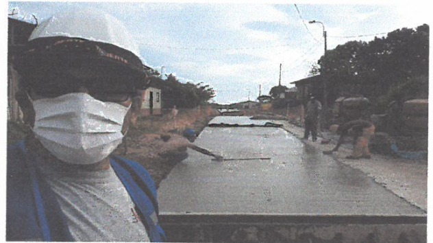
VACIADO DE CONCRETO F'C=210 KG/CM2, EN JR. 2 DE MAYO ENTRE JR LIBERTAD Y JR. MARIATEGUI
