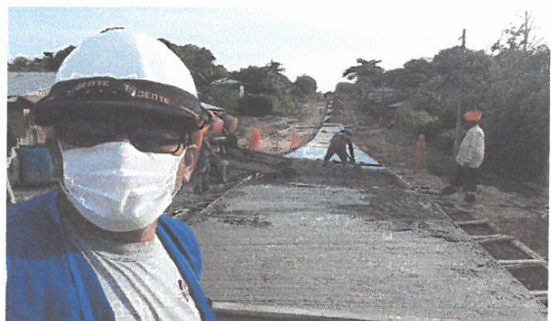
VACIADO DE CONCRETO F'C=210 KG/CM2, EN JR. 2 DE MAYO ENTRE JR. CONTAMANA Y JR. SAN JUAN
