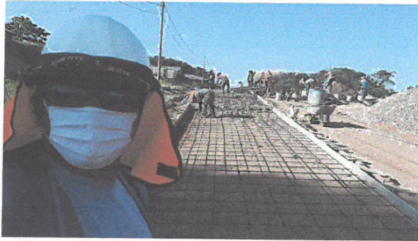
ENCOFRADO Y ACERO, EN JR. 2 DE MAYO ENTRE JR. REQUENA Y JR. LIBERTAD
