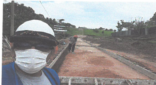
ENCOFRADO DE PAVIMENTO, EN JR. SAN JUAN ENTRE JR 2 DE MAYO Y JR. ZAPATA
