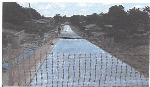
VACIADO DE CONCRETO F'C=210 KG/CM2, EN JR. 2 DE MAYO ENTRE JR PROGRESO Y JR. CONTAMANA
