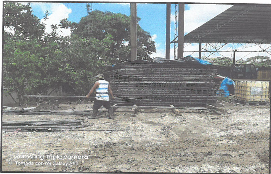
ALMACENAJE DE PILOTES HABILITADOS DE PILOTES, PARA SU POSTERIOR VACIADO CON CONCRETO ARMADO.
