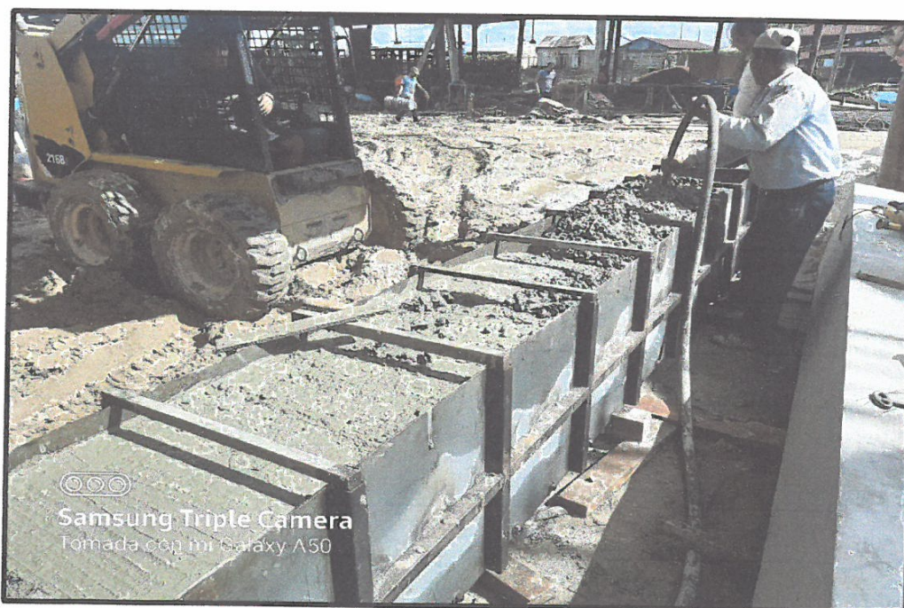
VACIADO DE CONCRETO ARMADO F 'C=280KG/CM2, ASI MISMO SE UTILIZO VIBRADOR DE CONCRETO PARA UN CORRECTO VACIADO DE PILOTE.
