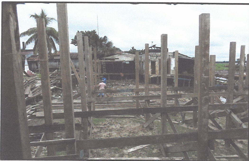
COLOCACION DE PILOTAJE DE MADERA DURA SHUNGO 6"x6" PARA LA CONSTRUCCION DE LOS MODULOS PROVISIONALES (OFICINAS ADMINISTRATIVAS, ALMACEN, COMEDOR, GARITA DE VIGILANCIA Y SS.HH)
