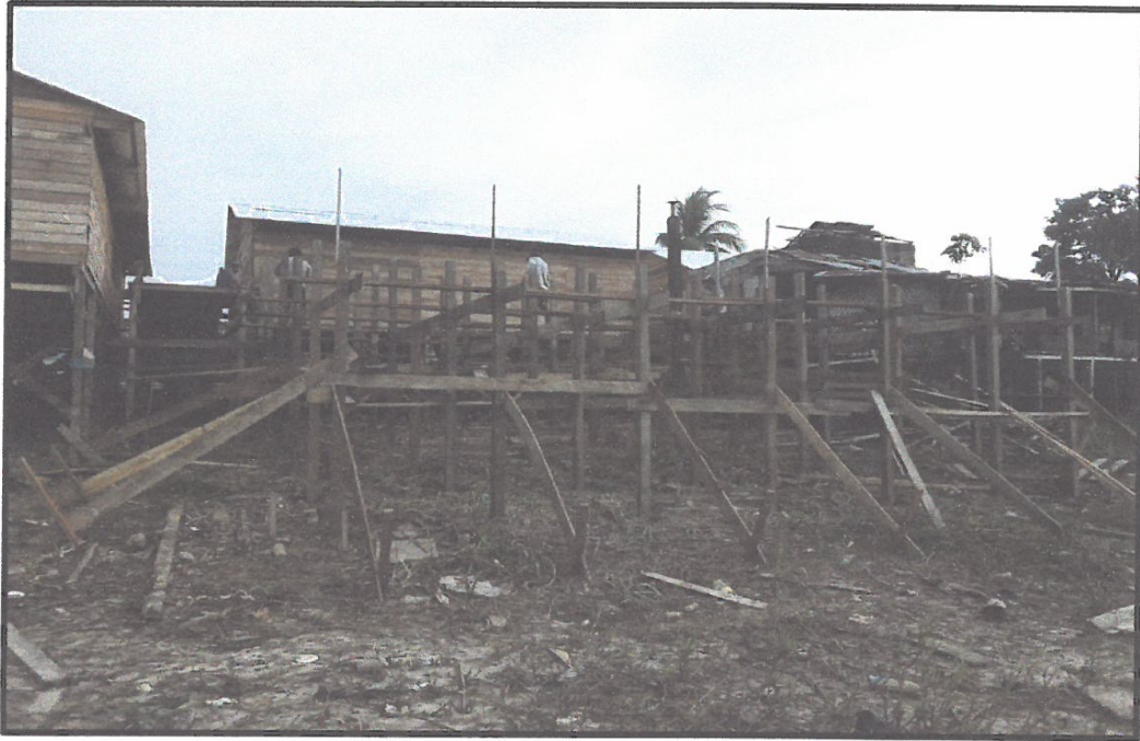
CONSTRUCCION DE OFICINAS ADMINISTRATIVAS, ALMACEN, GARITA DE VIGILANCIA EN OBRA.
