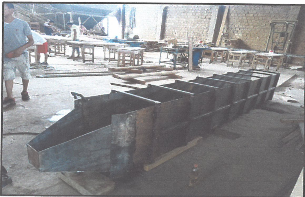
FABRICACION DE ENCOFRADO METALICO PARA LOS PILOTES DE CONCRETO DE 0.50 X 0.50.
