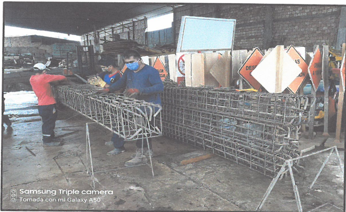
HABILITACION DE ACERO Ø 3/4" EN PILOTAJE DE CONCRETO DE 0.50 X 0.50 CM.
