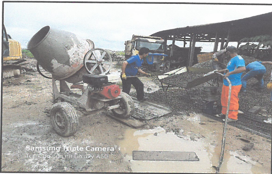
VACIADO DE CONCRETO ARMADO F'C=280KG/CM2 PARA PILOTES DE 0.50 X 0.50 CM.
