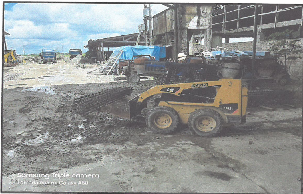
TRANSPORTE DE MATERIALES HABILITADOS DE PARA SU ALMACENAMIENTO Y POSTERIOR VACIADO CON CONCRETO F'_{C}=280\text{KG}/\text{CM}^2 .
