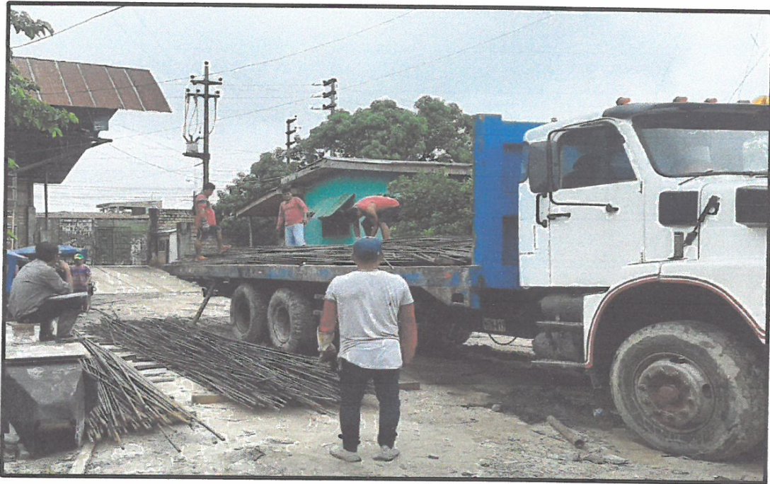
ABASTECIMIENTO DE MATERIALES PARA LA HABILITACION Y FABRICACION DE PILOTAJE DE CONCRETO Y DE ACERO Ø 3/4".
