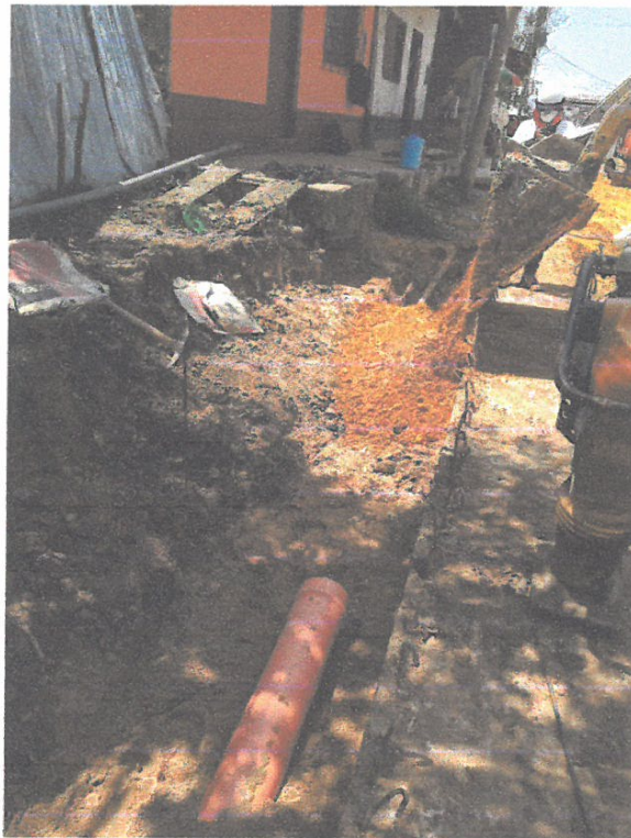
RELLENO CON MATERIAL MEJORADO, EN LA CALLE CONDOMINE CUADRA 03- LADO IZQUIERDO.
