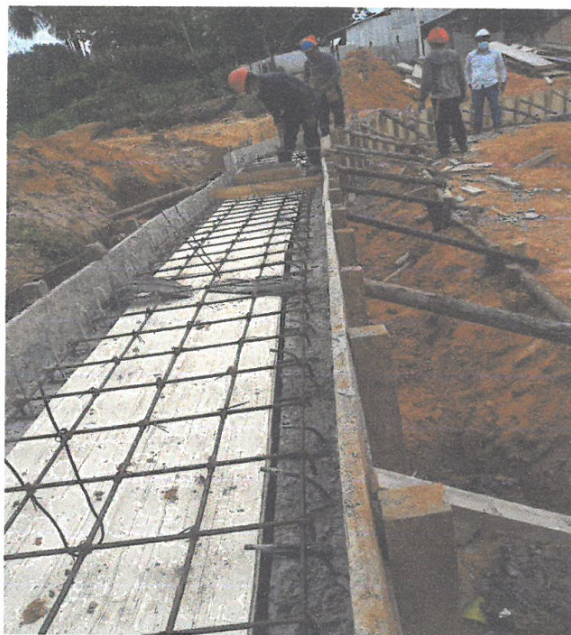
ENCOFRADO DE TAPAS DE CUNETETA EN LA CALLE RAYMONDI CUADRA 01-LADO DERECHO.
