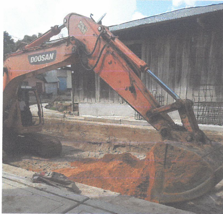
RELLENO CON MATERIAL MEJORADO EN LA CALLE CONDOMINE CUADRA 04.
