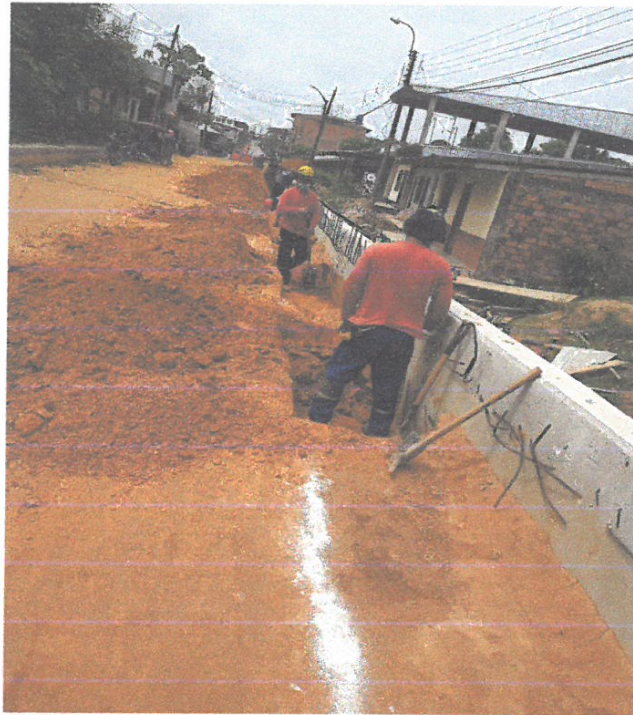
TRAZO Y EXCAVACION MANUAL DE ZANJA PARA CUNETETA, EN LA CALLE CONDAMINE CUADRA 03.
