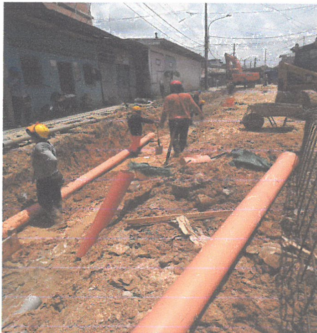
INSTALACION DE TUBERIA DE DESAGUE (8") EN LA CALLE MARAÑON CUADRA 04, LADO DERECHO.
