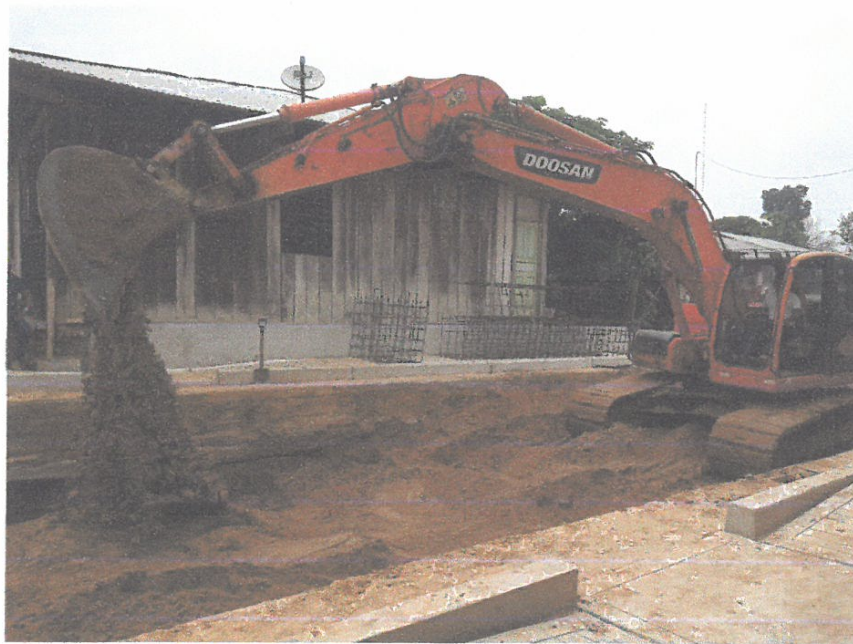
RELLENO CON ARENA EN LA CALLE CONDAMINE CUADRA 03.
