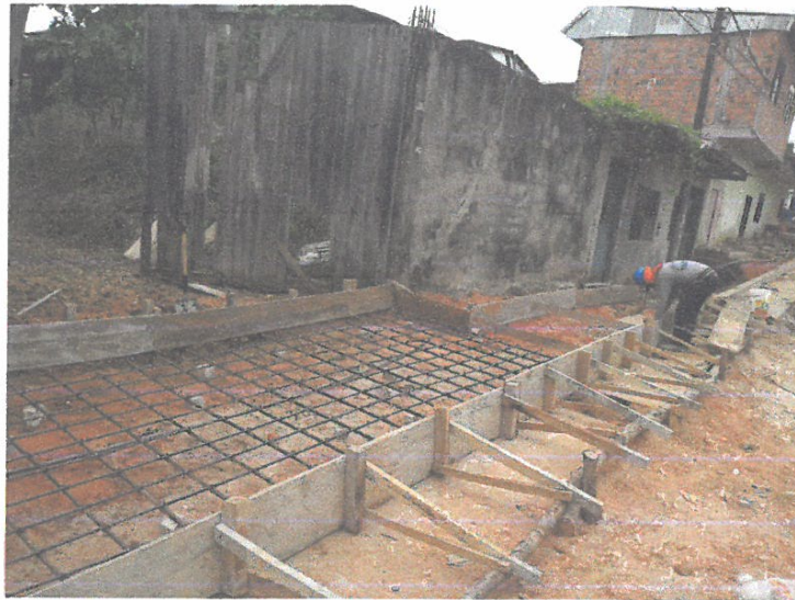
ENCOFRADO DE VEREDA EN LA CALLE RAYMONDI CUADRA 01-LADO IZQUIERDO.
