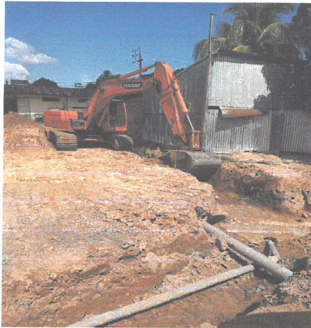
EXCAVACION DE ZANJA PARA ALCANTARILLA (0.60X0.60) EN LA CALLE 06 DE FEBRERO CUADRA 01-LADO DERECHO.
