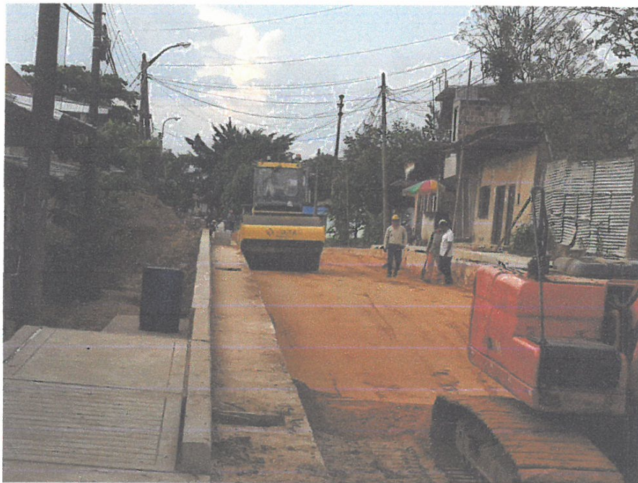
COMPACTACION DE TERRENO CON MAQUINA RODILLO LISO VIBRATORIO EN LA CALLE CONDOMINE CUADRA 03 Y 04.
