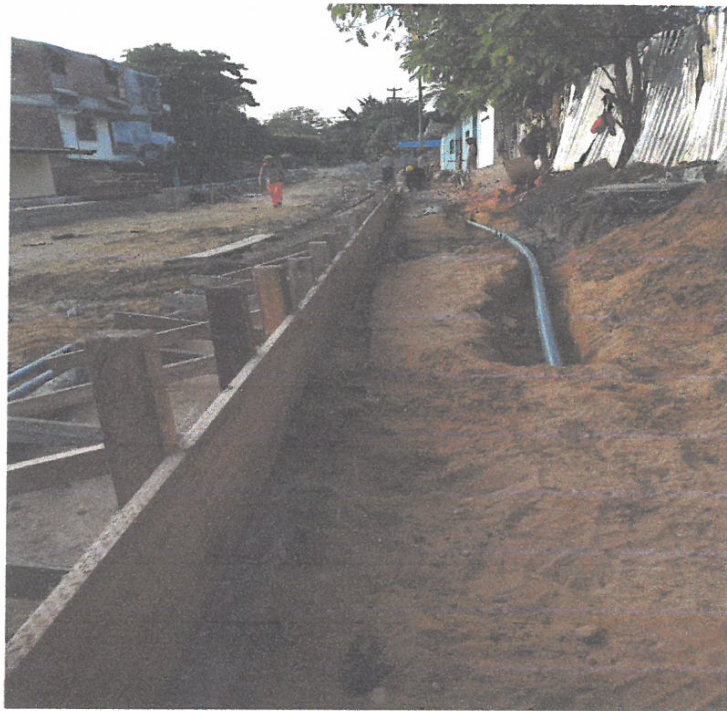
INSTALACION DE TUBERIA DE AGUA (2") EN LA CALLE CONDAMINE CUADRA 03, LADO IZQUIERDO.
