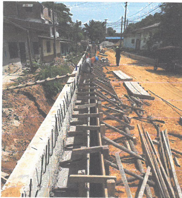
ENCOFRADO DE MURO DE CUNETTA EN LA CALLE CONDAMINE CUADRA 03-LADO DERECHO.
