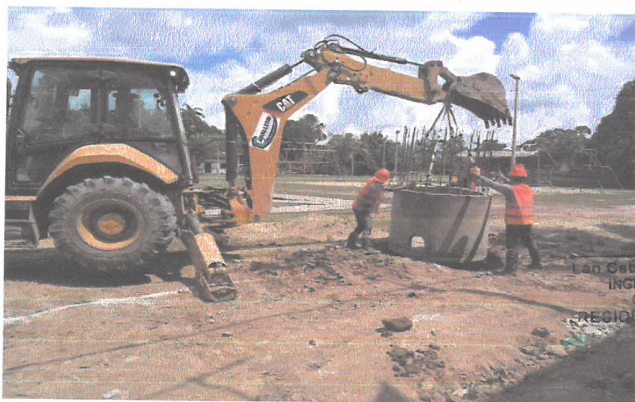
TRASLADO Y COLOCACION IN SITU DE BUZONES PREFABRICADOS.
