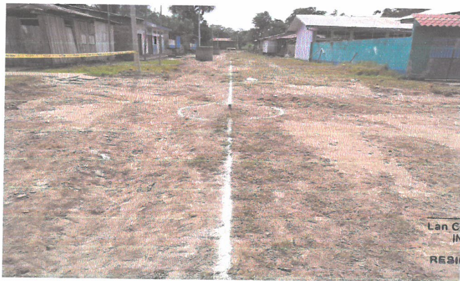
TRAZO, NIVELACION Y REPLANTEO EN LA CALLE IBERIA PARA BUZONES Y ALCANTARILLAS.
