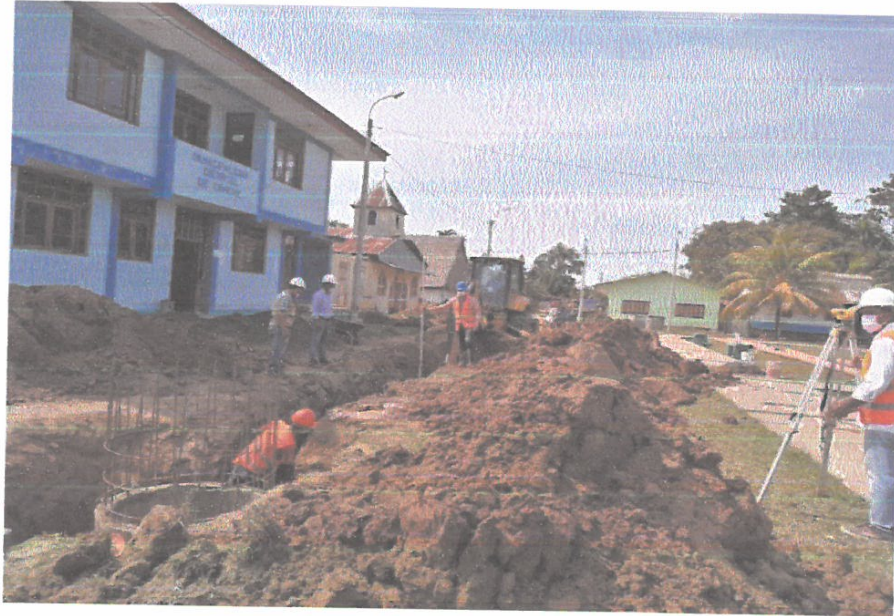
EXCAVACION PARA ALCANTARILLA EMISOR DE AGUAS PLUVIALES.
