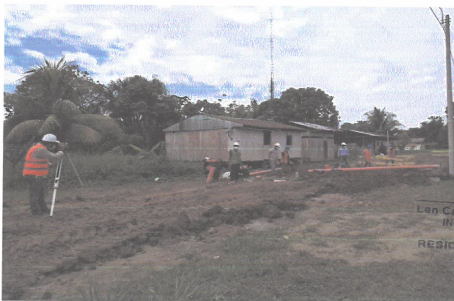
EXCAVACION MANUAL DE ZANJA PARA CONEXIONES DE SUMIDEROS.
