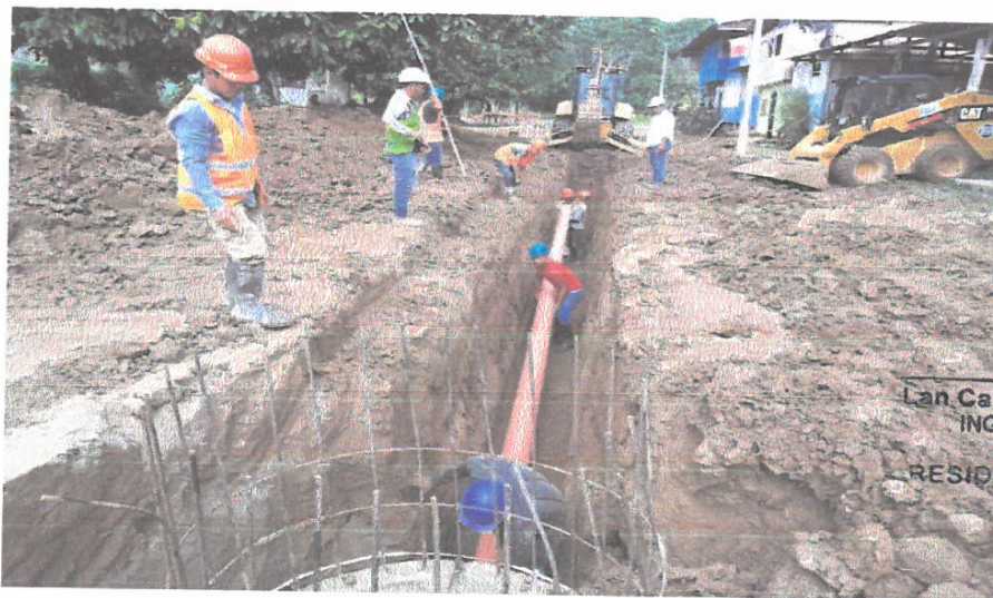
REFINE, NIVELACION, SUMINISTRO E INSTALACION DE TUBERIA PVC ISO-UF D=200 mm.
