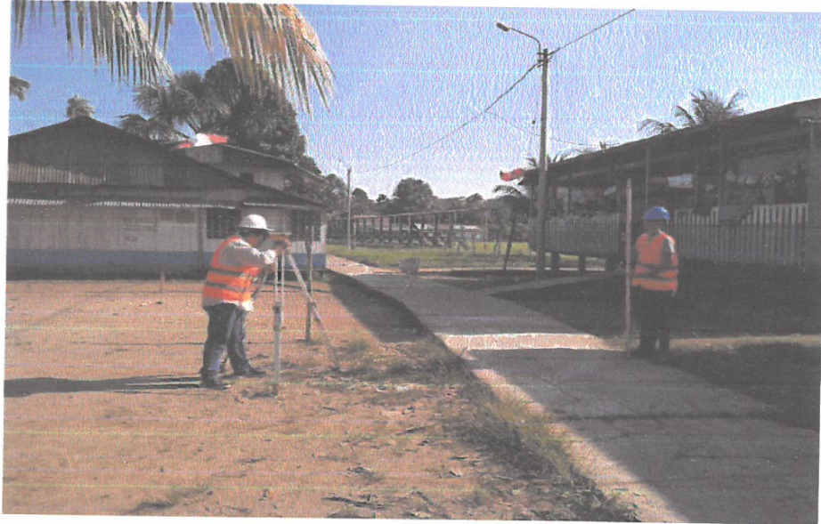
TRAZO, NIVEL Y REPLANTEO DE LAS CALLES QUE CONTEMPLA EL PROYECTO.
