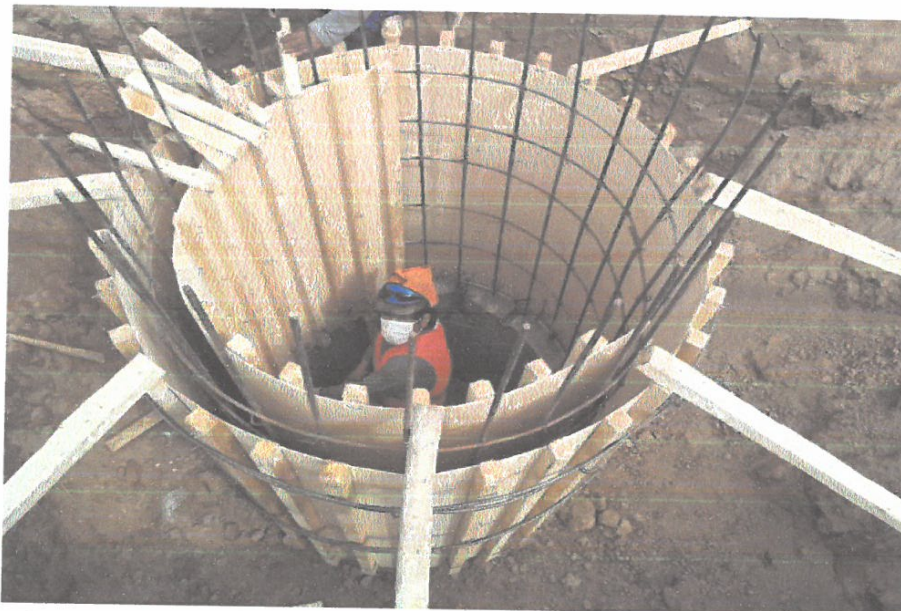
ENCOFRADO Y LLENADO DE MORTERO F' C=210KG/CM2 EN BUZON.
