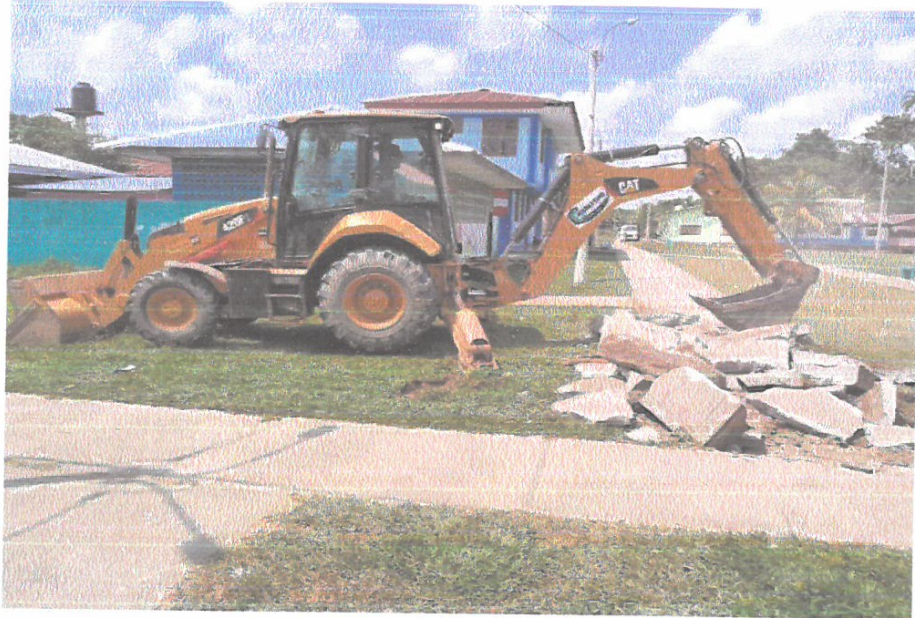
DEMOLICION DE VEREDA EXISTENTE DE MORTERO SIMPLE EN LA CALLE RAMON CASTILLA.
