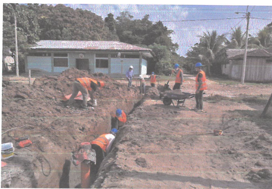
RELLENO EN ALCANTARILLADO DE AGUAS PLUVIALES CON ARENA.
