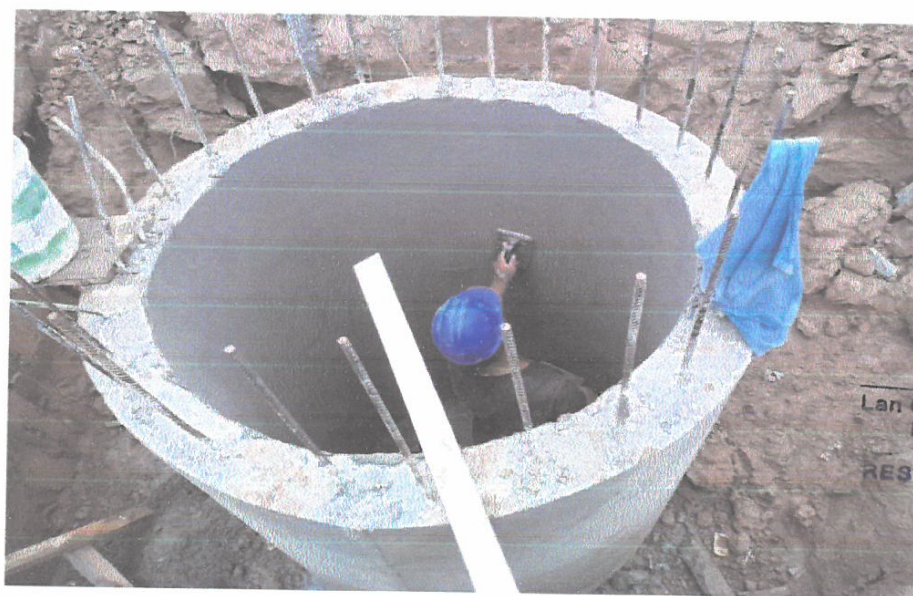
TARRAJEO PULIDO DE BUZON MORTERO C: A=1:3.
