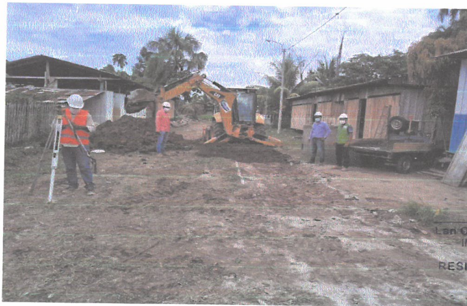
EXCAVACION PARA BUZONES DE MORTERO ARMADO F'C=210 KG/CM2.
