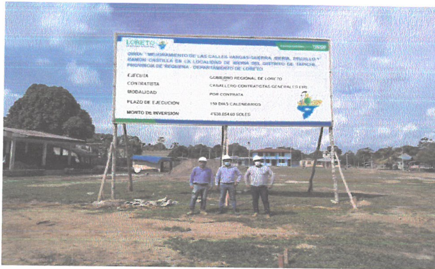
CARTEL DE OBRA 4.80 X 3.60 M. GIGANTOGRAFIA C/ BAST. DE MADERA 2"X2".
