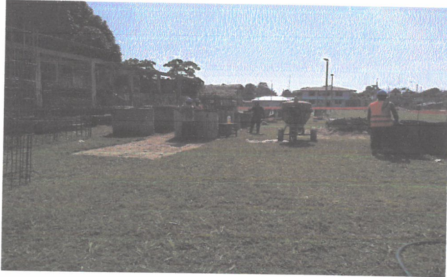
ELABORACION DE BUZONES PREFABRICADOS DE MORTERO ARMADO F'C=210KG/CM2.
