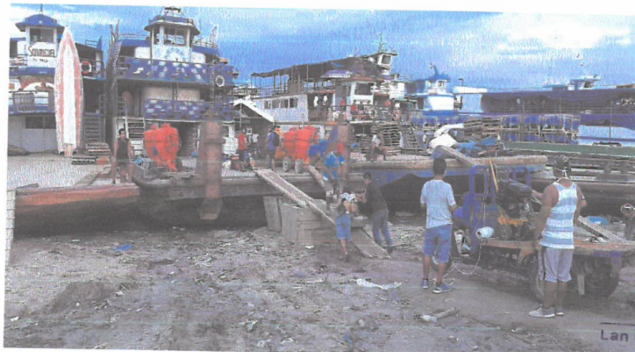
TRANSPORTE DE MATERIALES, HERRAMIENTAS Y MAQUINARIA A LA LOCALIDAD DE IBERIA.
