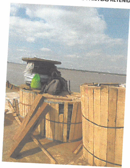
VISTA DE CARRETE DE CONDUCTORES CON SUS JABAS PROTECTORAS
