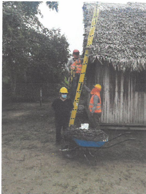
VISTA DE RESIDENTE CON PERSONAL REALIZANDO UNA CONEXIÓN DOMICILIARIA
