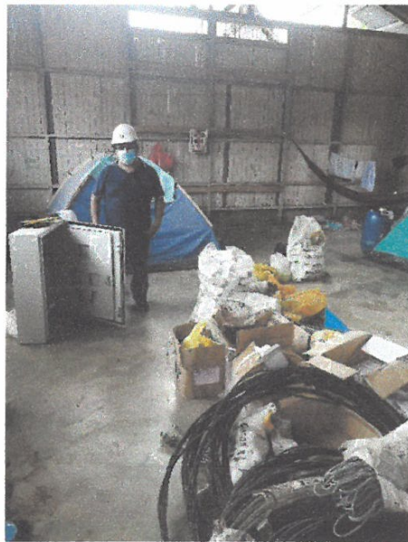
VISTA DE RESIDENTE DE OBRA EN EL ALMACEN DE LA OBRA
