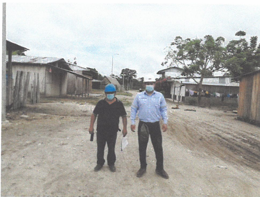
VISTA DEL RESIDENTE Y SUPERVISOR VERIFICANDO LA CANTIDADDE POSTES Y LUMINARIAS INSTLADAS EN LA OBRA
