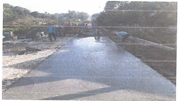
VACIADO DE CONCRETO F'C=210 KG/CM2, EN JR. 2 DE MAYO
