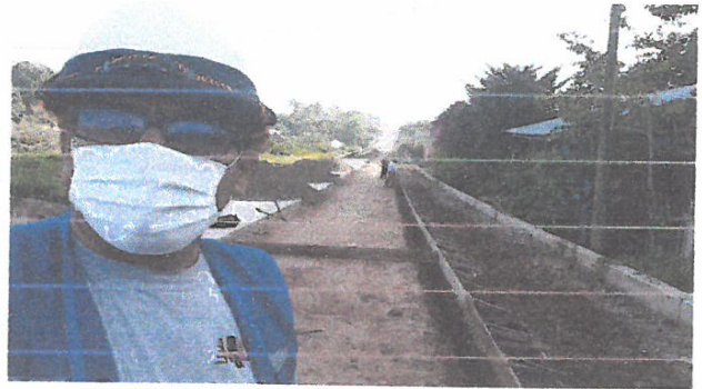
ENCOFRADO PARA LOSAS DE PAVIMENTO, EN JR. 2 DE MAYO
