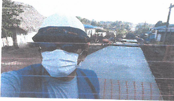
VACIADO DE CONCRETO F'C=210 KG/CM2, EN JR. 2 DE MAYO, ENTRE JR. TRUJILLO Y JR. ALFONSO UGARTE
