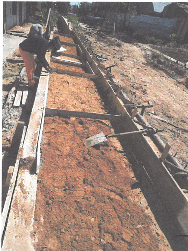
ENCOFRADO DE VEREDA EN LA CALLE CONDAMINE CUADRA 03, LADO DERECHO.
