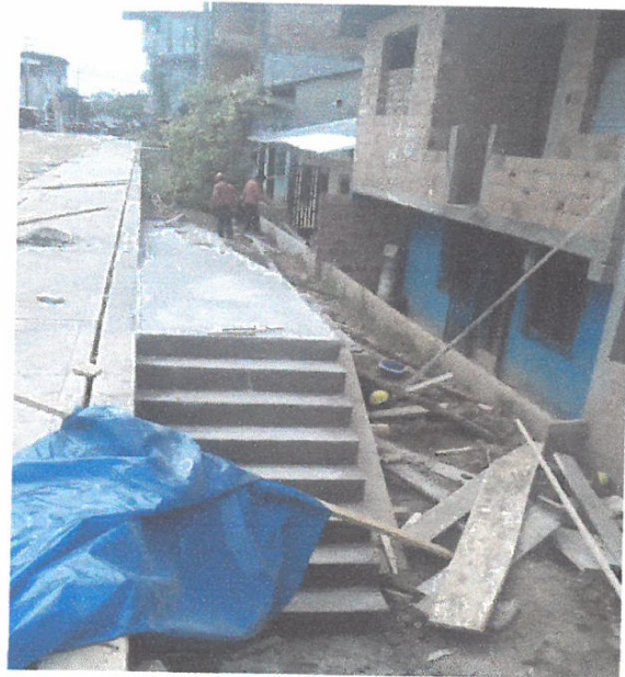
DESENCOFRADO DE RAMPA( ACCESO 02) EN LA CALLE TARATA CUADRA 06, LADO DERECHO.
