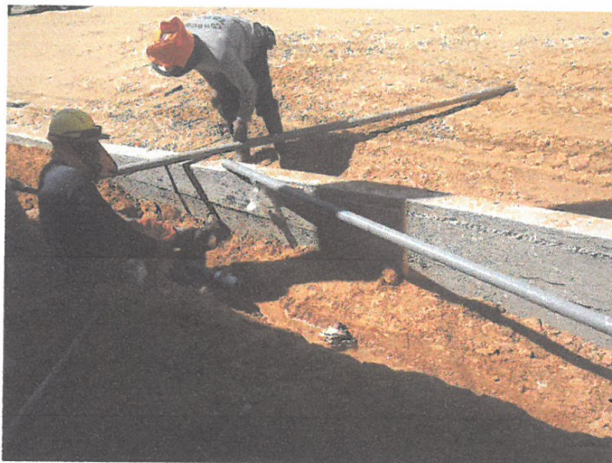
INSTALACION DE TUBERIA DE AGUA EN LA CALLE TARATA CUADRA 06, LADO IZQUIERDO.
