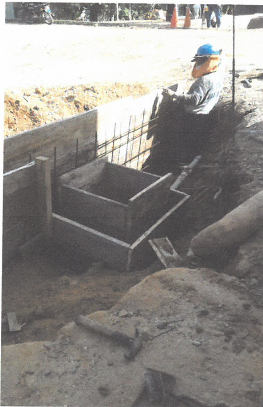
ENCOFRADO DE SARDINEL Y BUZON EN LA CALLE TARATA CUADRA 06, LADO IZQUIERDO.
