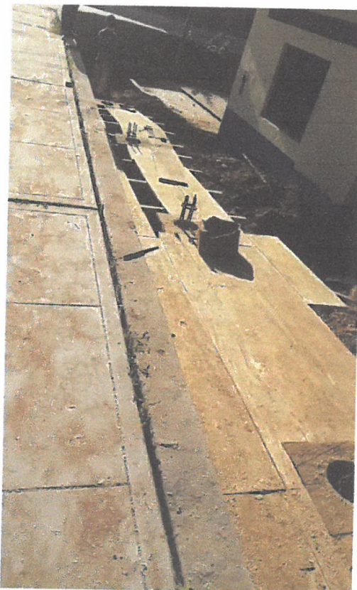
ENCOFRADO DE RAMPA ( ACCESO 01) EN LA CALLE TARATA CUADRA 06, LADO DERECHO.
