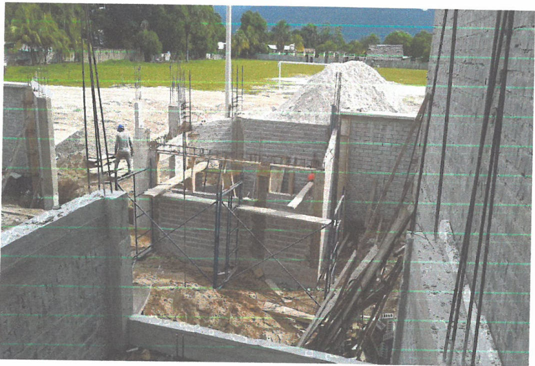
FOTO N° 12. Panorámica de los trabajos en acceso principal; la vista precisa el desarrollo de la construcción de la caseta de control de acceso a la Institución Educativa.
