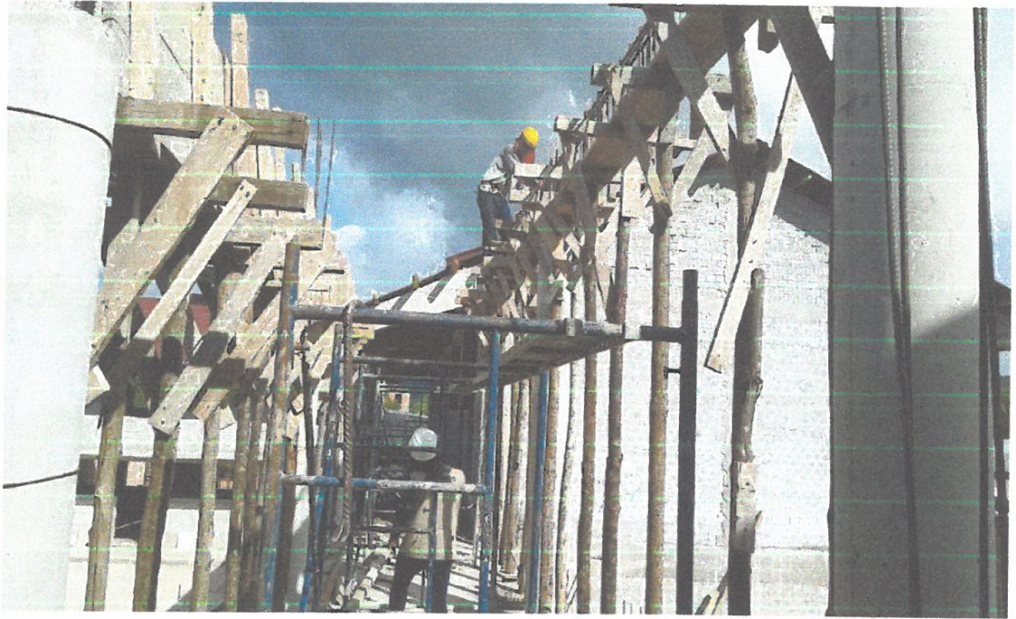
FOTO N° 07. Puente de acceso a módulos, 1, 2, 3, 4,5; la vista acusa el desarrollo de los trabajos De distribución del acero y estribado de las mismas para las vigas estructural, así como también Se evidencia los trabajos de encofrado
