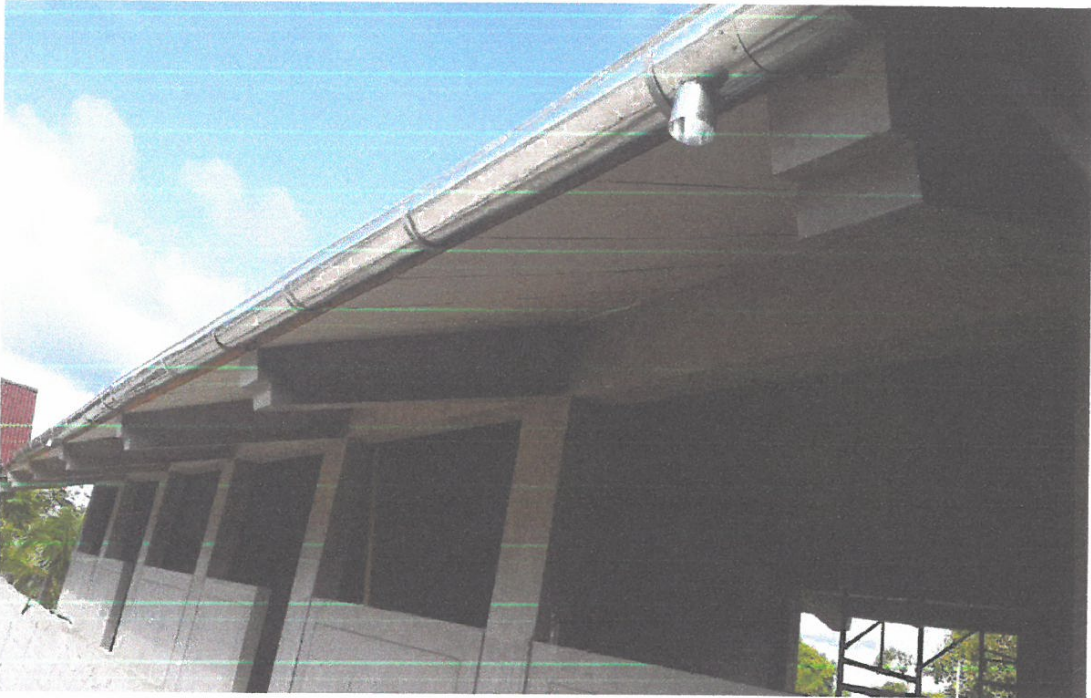
FOTO N° 01. Módulo 3, la vista da cuenta de lo trabajos de instalado de canaletas para el sistema de evacuación de aguas pluviales
