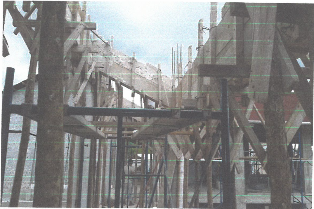
FOTO N° 09. Otra vista que acusa el desarrollo de los trabajos de encofrado de vigas soleras Transversales, en puente de acceso a módulos
