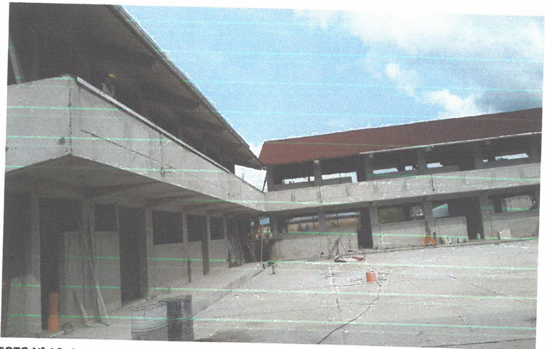
FOTO N° 16. Otra vista que da cuenta el desarrollo de los trabajos de acabados en cada uno de Los módulos
