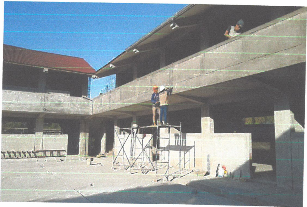
FOTO N° 14. Trabajos de acabados en módulos 3, y 4. La vista da cuenta la labor desplegada por la residencia, haciendo un control minucioso de los trabajos
