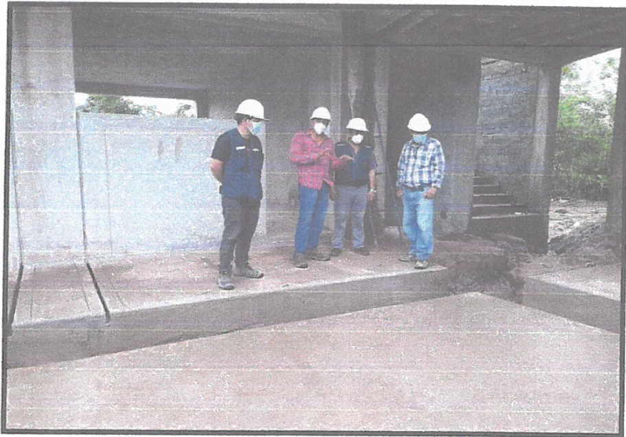
FOTO N°09: Verificando trabajos realizados en obra.
