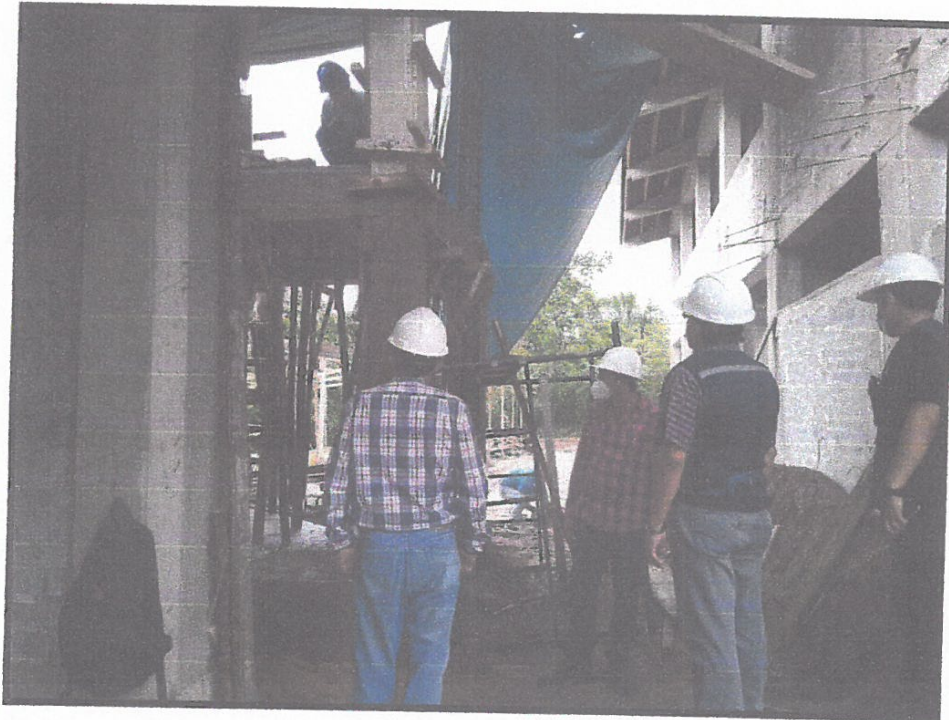
FOTO N°08: Desencofrado de columnas del segundo nivel.
