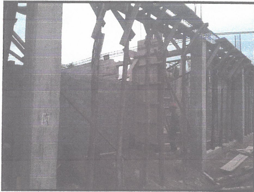
FOTO N°03: Encofrado de vigas modulo 03
