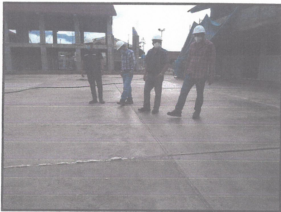
FOTO N°10: Verificando trabajos realizados en patio de formación.
