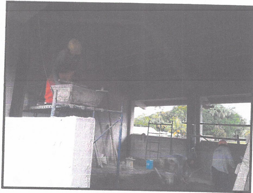
FOTO N°05: Tarrajeo de muros interiores.
