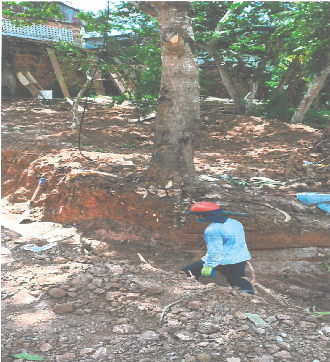
FOTO N° 01: EN LA VISTA SE OBSERVA AL PERSONAL RELISANDO LOS TRABAJOS DE LIMPIEZA DE TERRENO.
