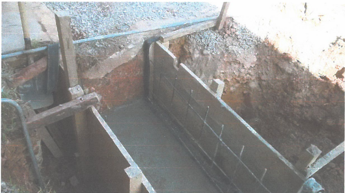
FOTO N° 03: EN LA VISTA SE OBSERBA EL TISNADO DE LA LOSA DE CUNETA PARA EMPEZAR EL ENCOFRADO DEL SARDINEL.
