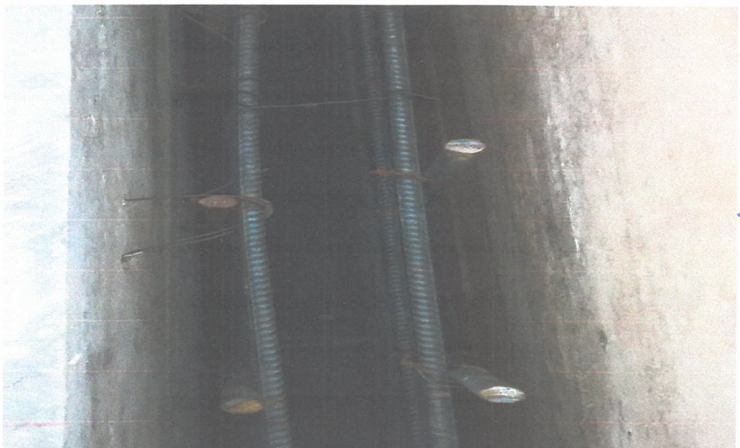
FOTO N° 11: EN LA VISTA SE OBSERVA EL RECUBRIMIENTO RESPECTIVO EN MURO.
