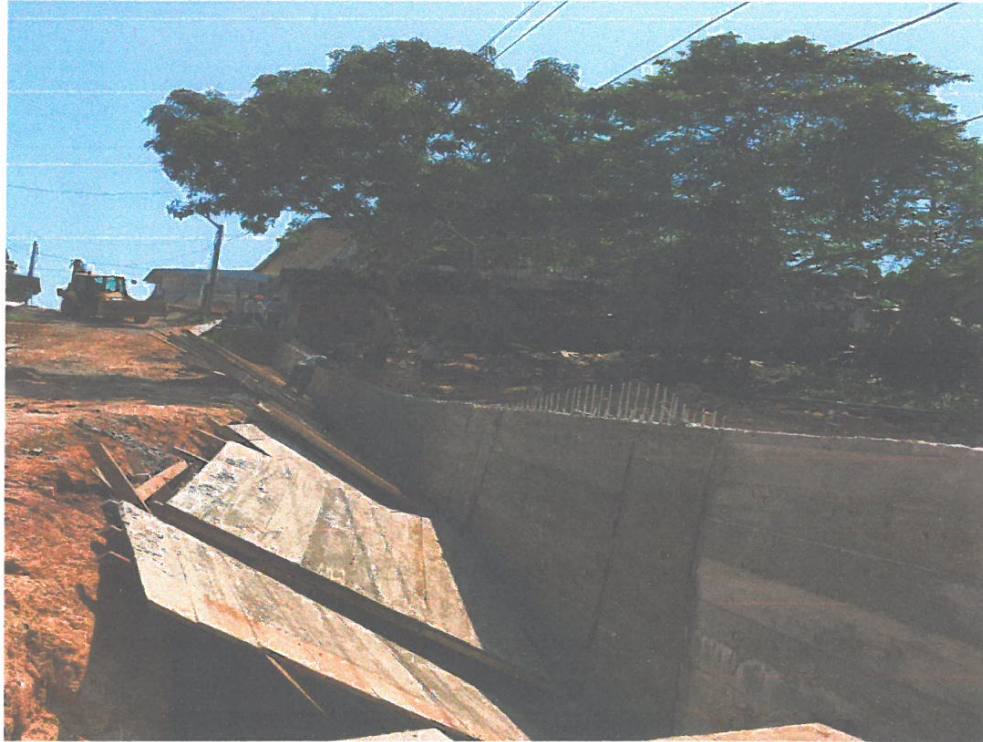
FOTO N° 04: EN LA VISTA SE OBSERVA AL PERSONAL REALIZANDO LOS TRABAJOS DE DESENCOFRADO DE MUROS.
