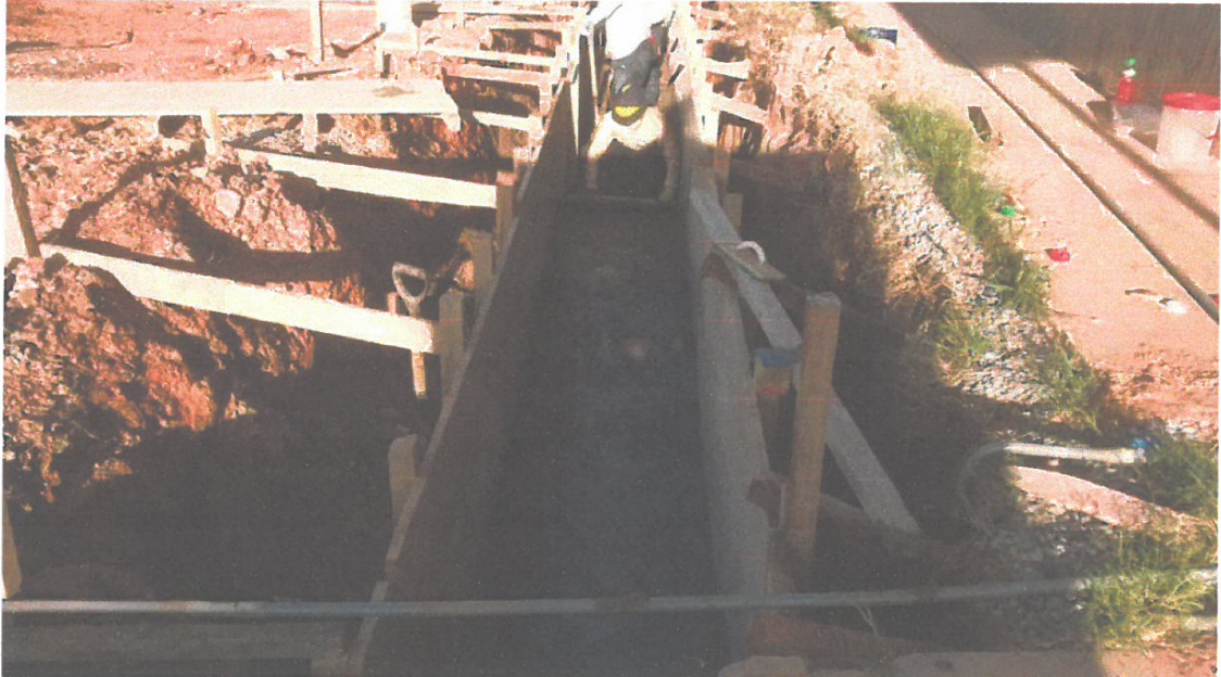
FOTO N° 02: EN LA VISTA SE OBSERVA AL PERSONAL REALIZANDO LOS TRABAJOS DE VACEO DE SOLADO EN CUNETA SARDINEL.
