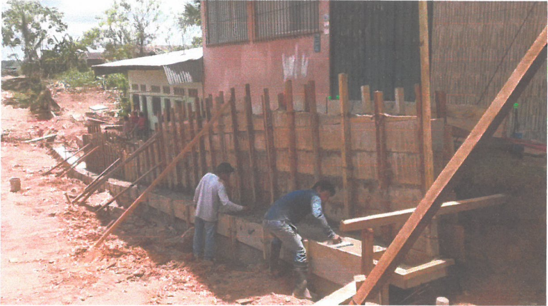
FOTO N° 12: EN LA VISTA SE OBSERVA AL PERSONAL HACIENDO EL TRABAJO DE FROTACHADO EN LOSA DE CUNETA.
