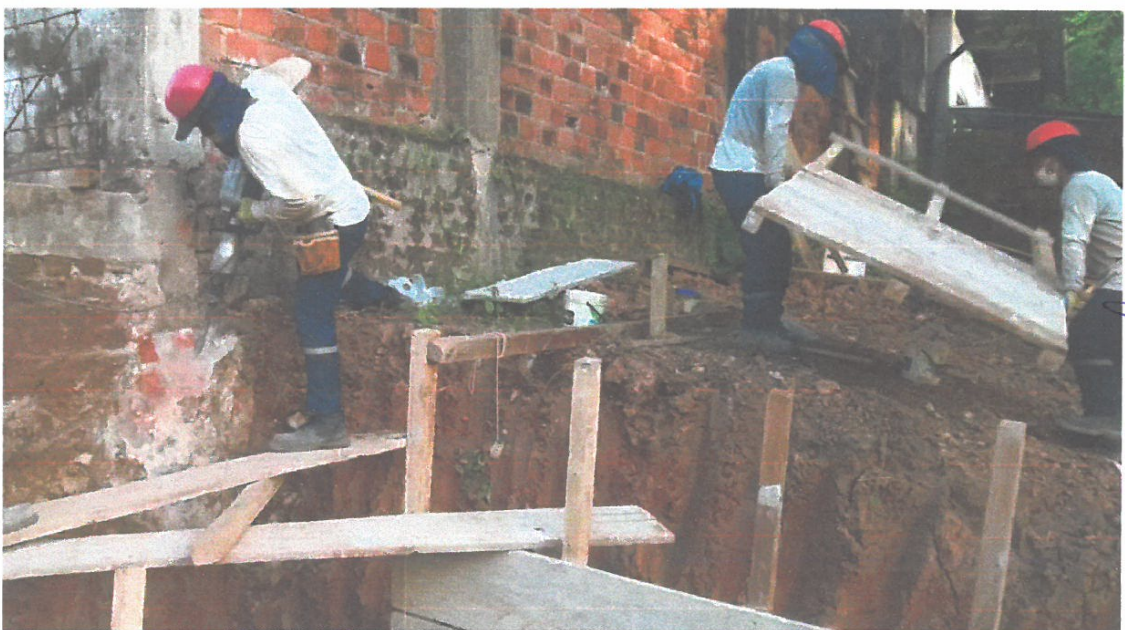
FOTO N° 09: EN LA VISTA SE OBSERVA AL PERSONAL HACIENDO EL TRABAJO DE DEMOLICIÓN DE MURO PARA HACER EL ENCOFRADO.
