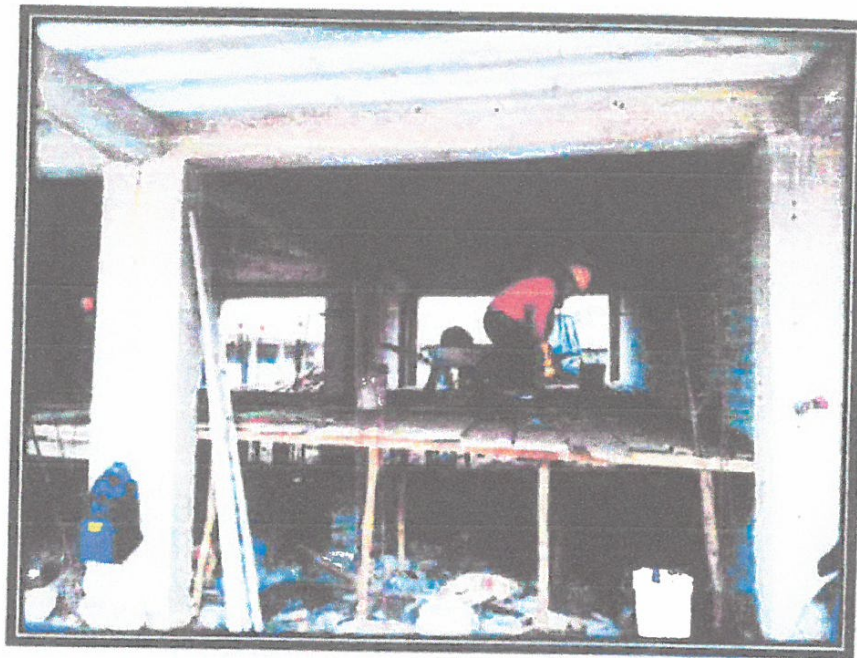
FOTO N°09: Tarrajeo cielo raso módulo 05.
