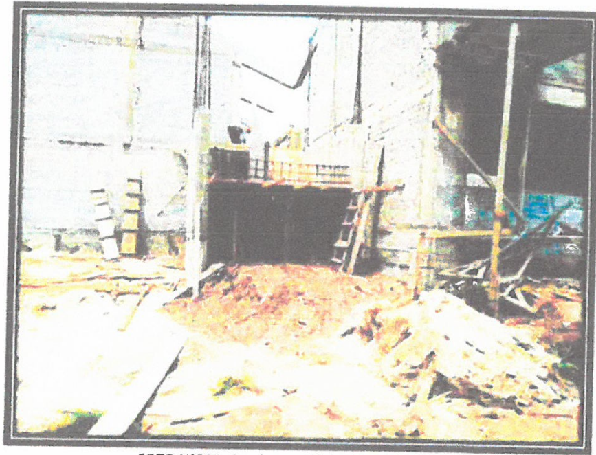
FOTO N°011: Escalera módulo 03 y módulo 04.
