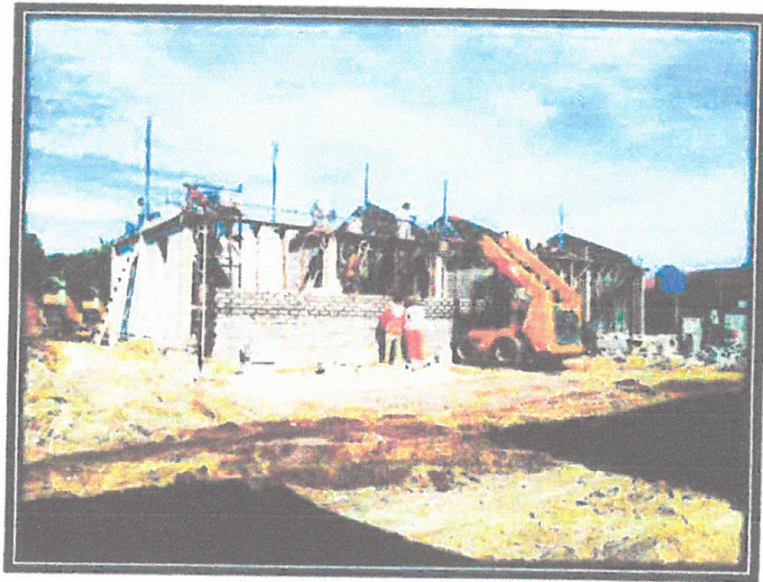
FOTO N°03: Viga Tímpano Módulo 10
