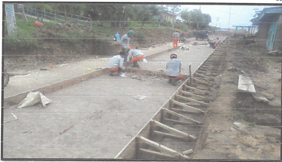
ENCOFRADO DE PAÑOS EN LOSA DE PAVIMENTO – LADO IZQUIERDO
