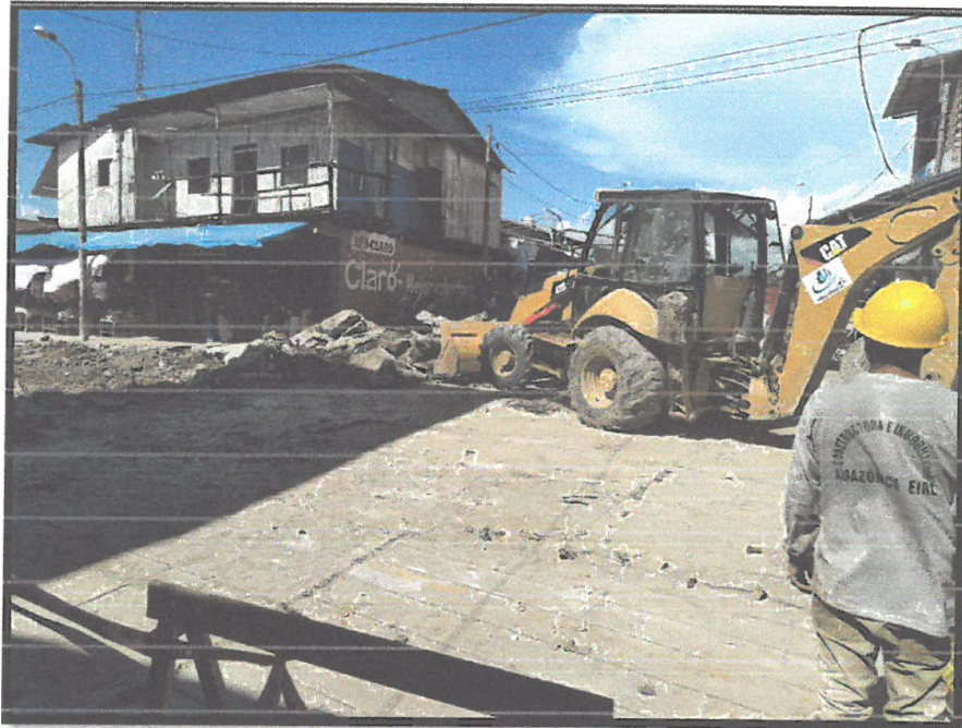
ACARREO Y ELIMINACIÓN DE MATERIAL DEMOLIDO
