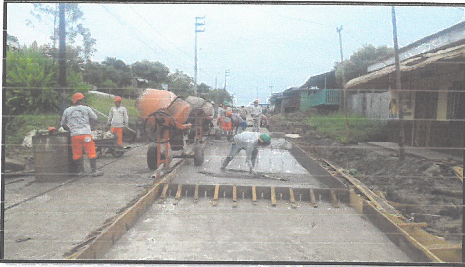
MORTERO F'C= 210 KG/CM2 EN LOSA DE PAVIMENTO – PROG. 0+420 LADO IZQUIERDO
