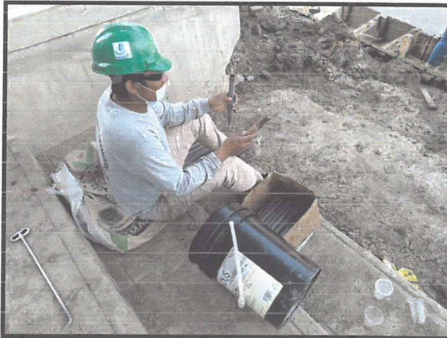
ESPIGA DE FIJACION DE TUBO DE PVC O 3/4" PARA JUNTA DE DILATACION
