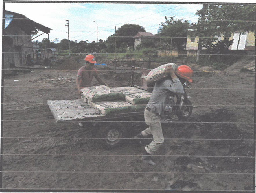
TRASTEIO DE MATERIAL (CEMENTO PORTLAND TIPO I)
