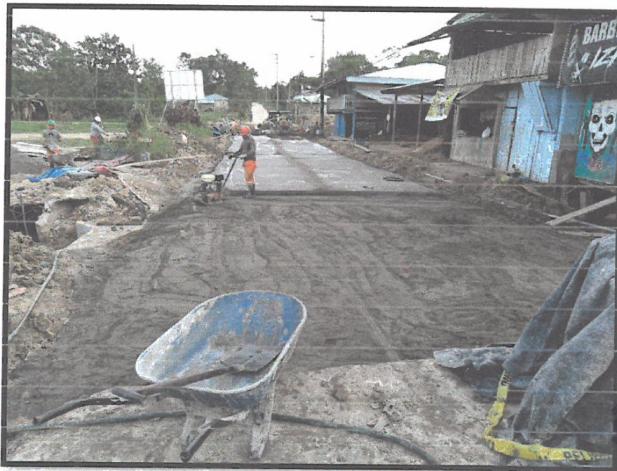
RELLENO CON MATERIAL DE PRESTAMO Y SOLADO EN PROG. 0+480 A 0+530
