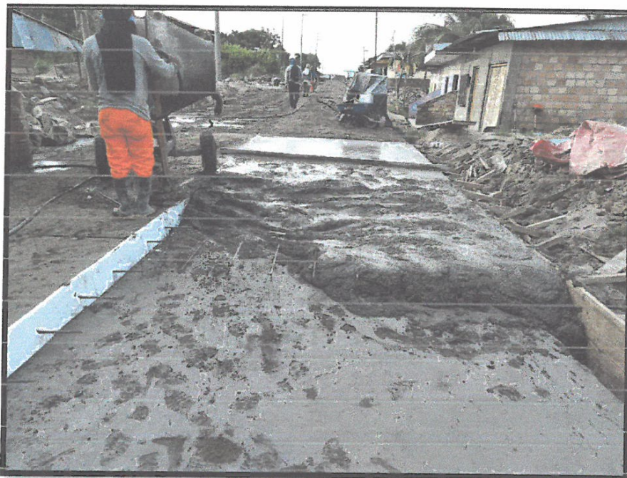
MORTERO F'C= 210 KG/CM2 EN LOSA DE PAVIMENTO – PROG. 0+480 A 0+530 LADO IZQ.
