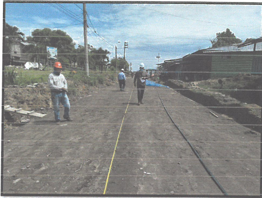
METRADO DE LOSA DE PAVIMENTACIÓN CON EL INSPECTOR DE OBRA PROG. 0+350 A 0+530
