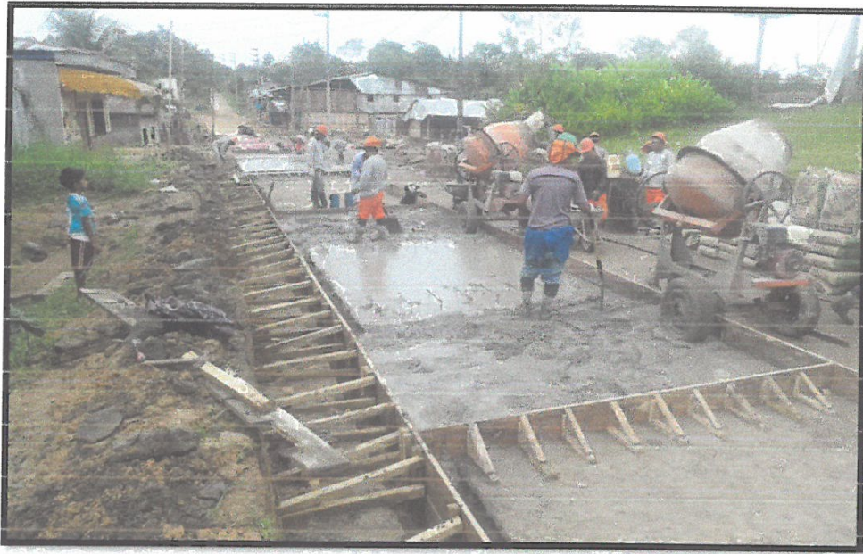
MORTERO F'C= 210 KG/CM2 EN LOSA DE PAVIMENTO – PROG. 0+380 LADO IZQUIERDO
