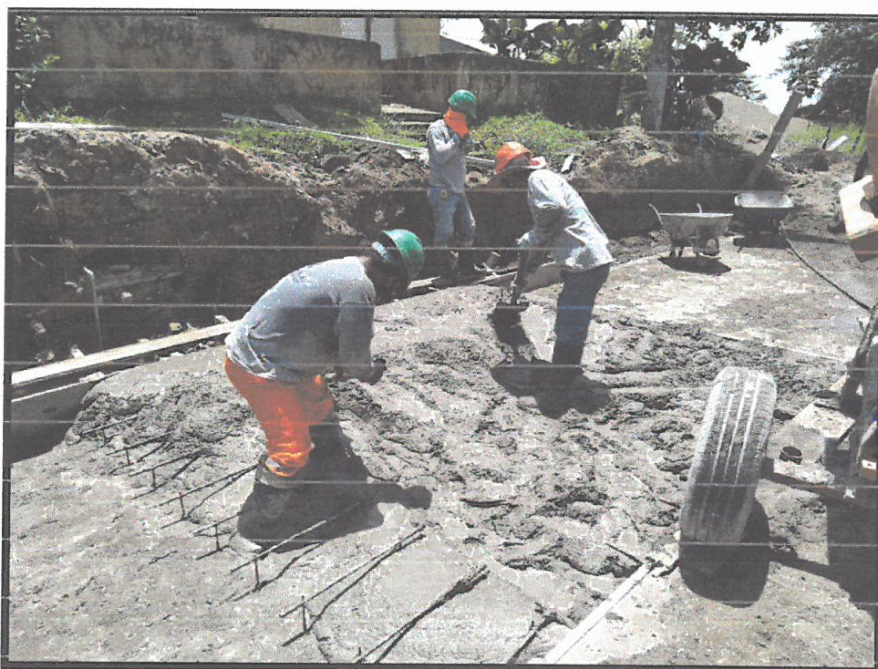
MORTERO F'C= 210 KG/CM2 EN LOSA DE PAVIMENTO – PROG. 0+360 LADO DERECHO.
