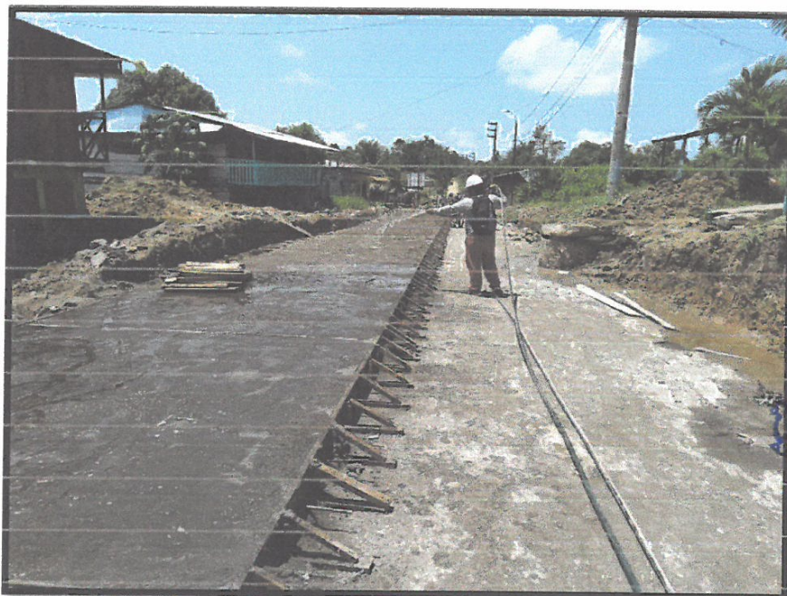
CURADO DE LOSA DE PAVIMENTO
