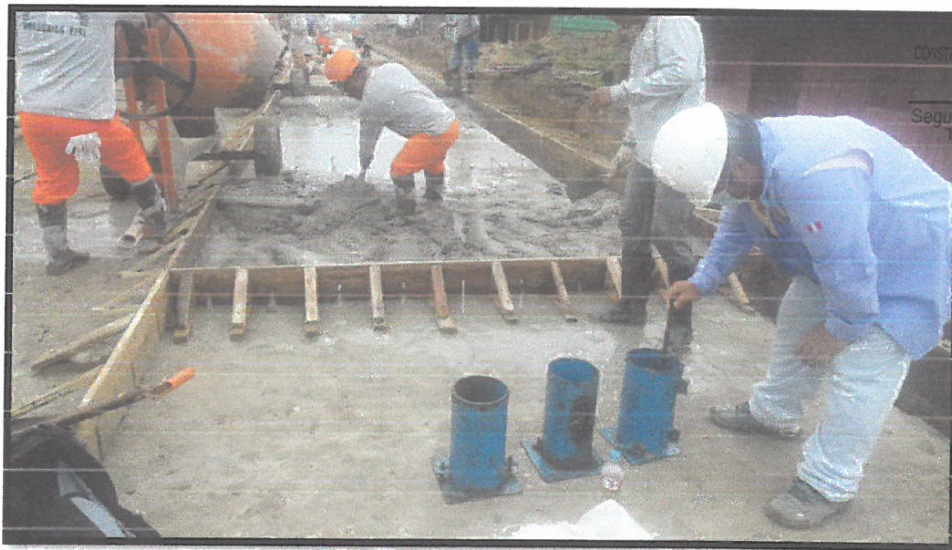
TESTIGOS DE MUESTRA DE PROBETAS PARA ENSAYO A LA ROTURA
