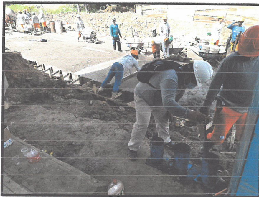
MORTERO F'C= 210 KG/CM2 EN LOSA DE PAVIMENTO – PROG. 0+280 LADO IZQ, PROBETA PARA ENSAYO A LA ROTURA
