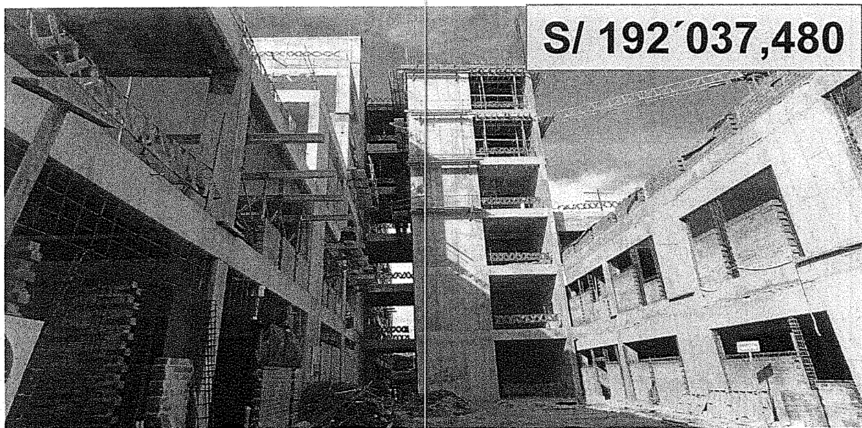
Construcción y equipamiento del nuevo Hospital de Iquitos "CÉSAR GARAYAR GARCÍA", provincia de Maynas. Avance: 20%
